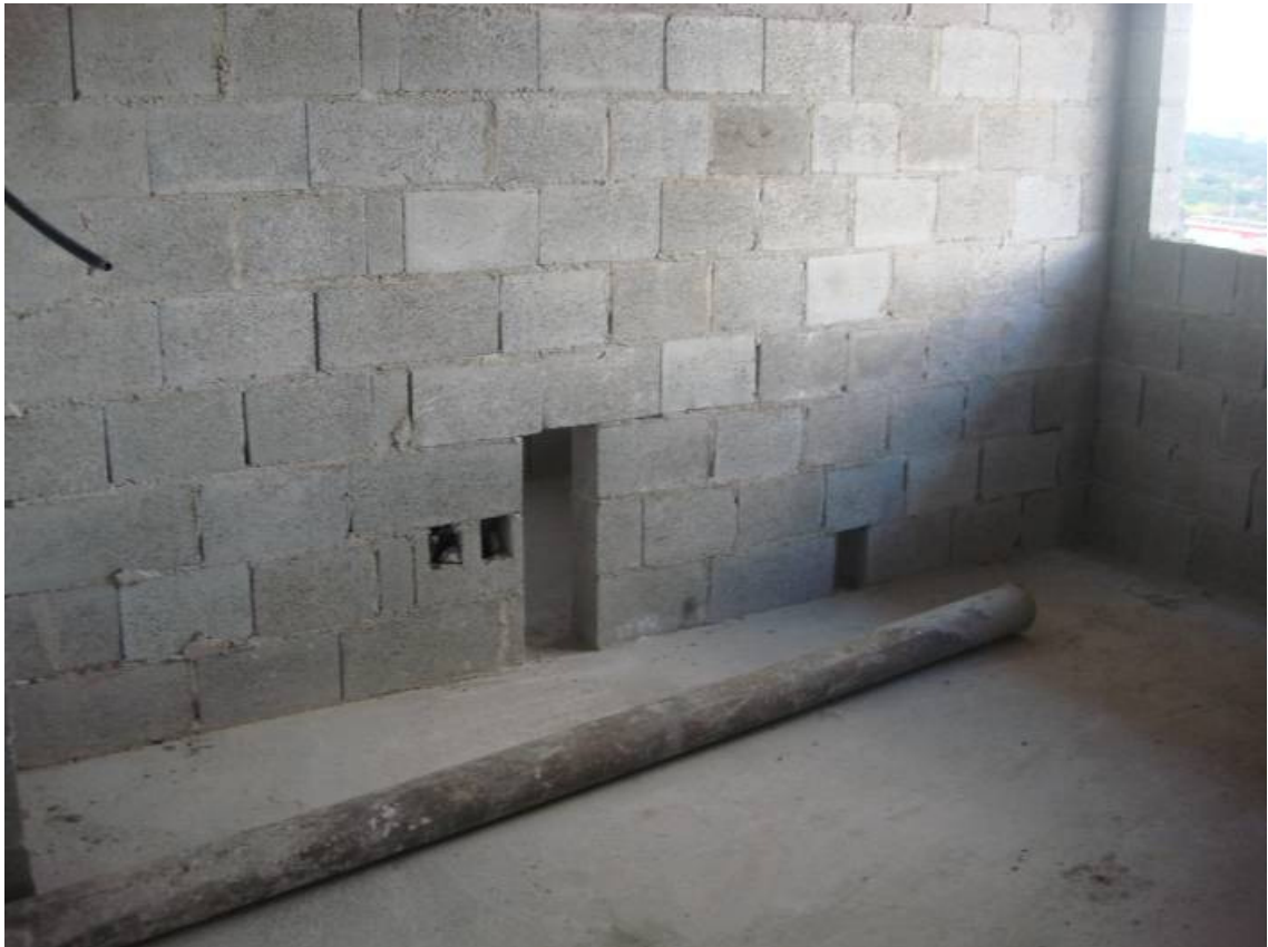
FIGURA 09 – Execução da alvenaria na obra Fonte: COSTA, 2010.
