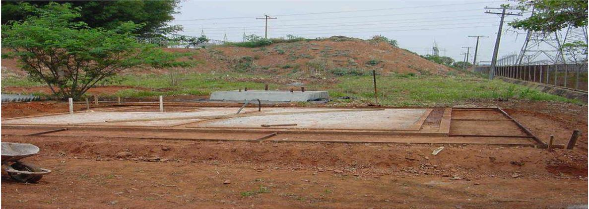
Figura 29 - Radier da casa pré-moldada a ser edificada.
