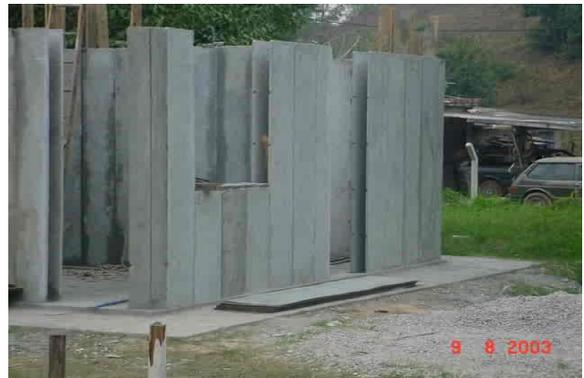
Figura 33 - Montagem dos painéis. Foto: Capremol.
