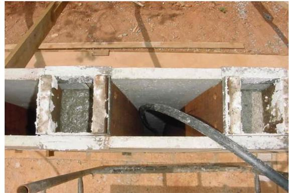
Figura 37 - Detalhe dutos nos painéis.
