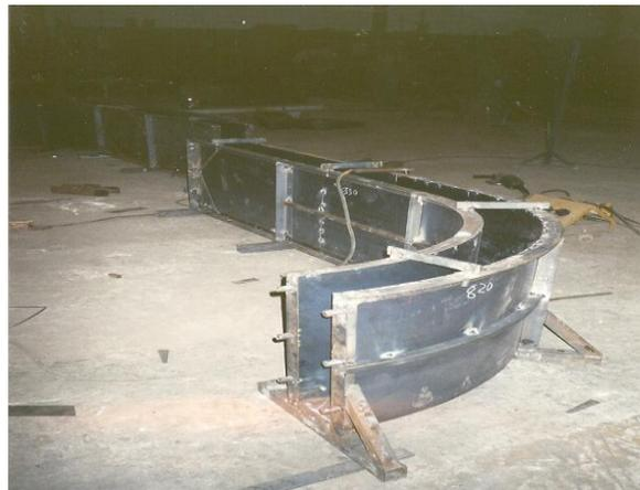
Figura 93 - Exemplo Formas Metálicas para concretagem.
