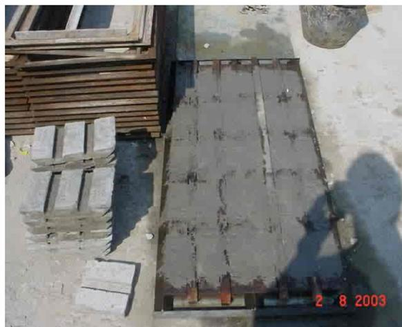
Figura 22 - Formas das galgas de parede.
