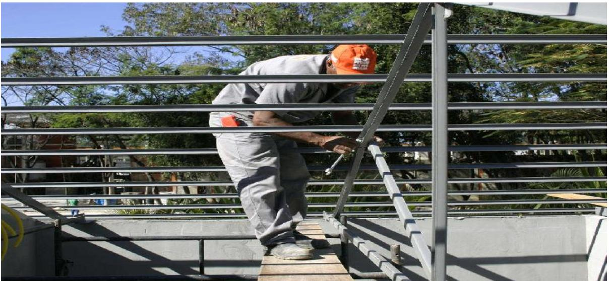
Figura 58 - Engradamento do telhado com perfis metálicos.
