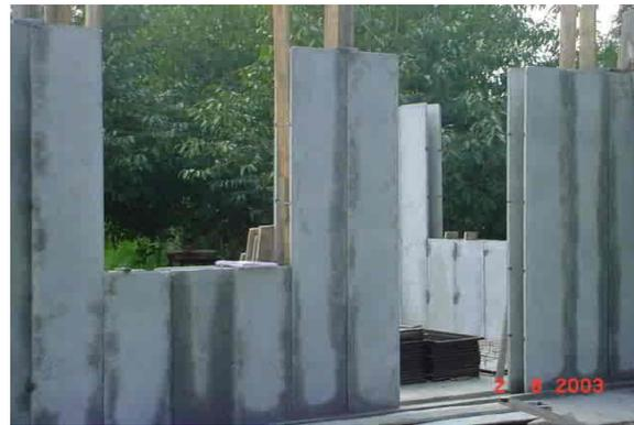
Figura 39 - Detalhe montagem painéis.
