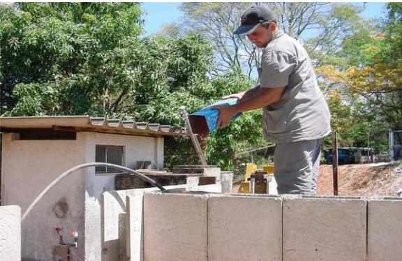
Figura 30 - Enchimento dos painéis. Foto: Capremol.
