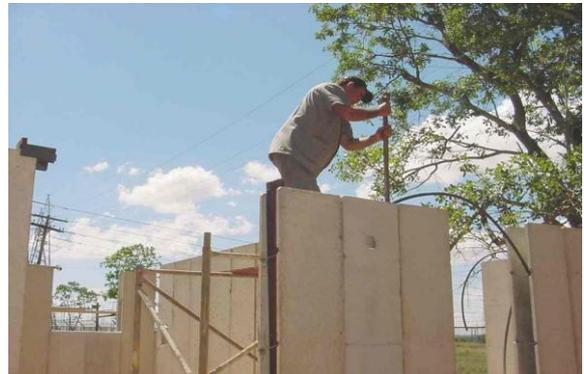
Figura 31 - Enchimento dos painéis. Foto: Capremol.
