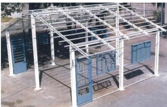
Figura 44 - Estrutura em aço sem vedações.
