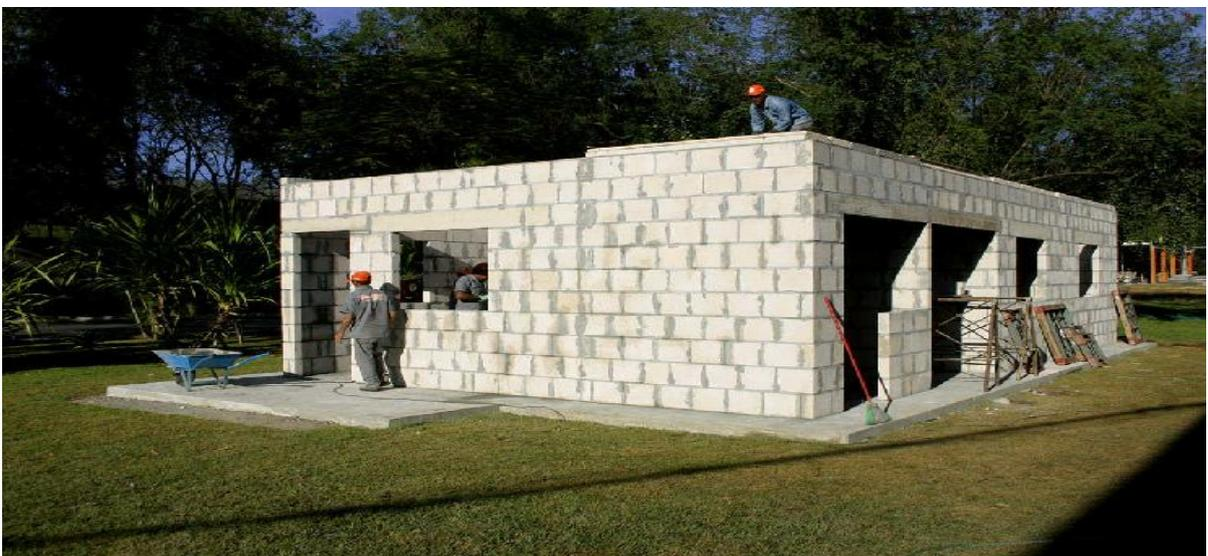
Figura 56 - Visada externa das paredes em fase final com tijolos do tipo SICAL.
