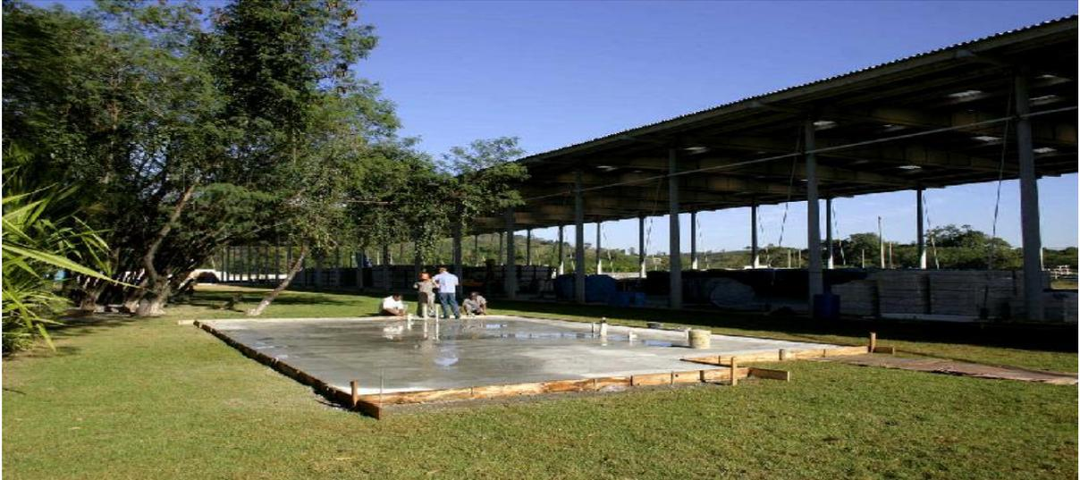
Figura 51 - Base da casa demarcada e moldada no local (Radier)
