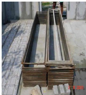
Figura 28 - Formas metálicas painéis.
