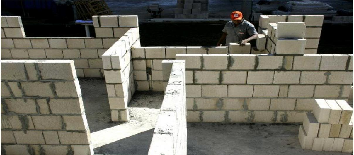
Figura 54 - Visada geral das paredes levantadas com tijolos do tipo SICAL.
