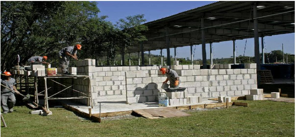
Figura 55 - Visada externa das paredes levantadas com tijolos do tipo SICAL.
