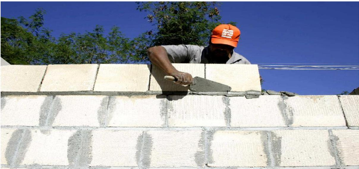
Figura 52 - Paredes levantadas com tijolos do tipo SICAL.
