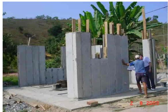
Figura 35 - Escoramento dos painéis. Foto: Capremol.
