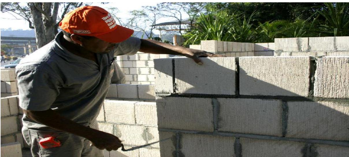
Figura 53 - Visada interna das paredes levantadas com tijolos do tipo SICAL.
