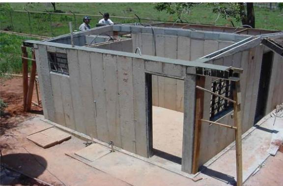
Figura 32 - Preparo para telhado. Foto: Capremol.
