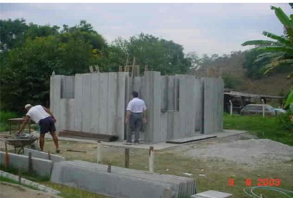
Figura 34 - Montagem dos painéis. Foto: Capremol.
