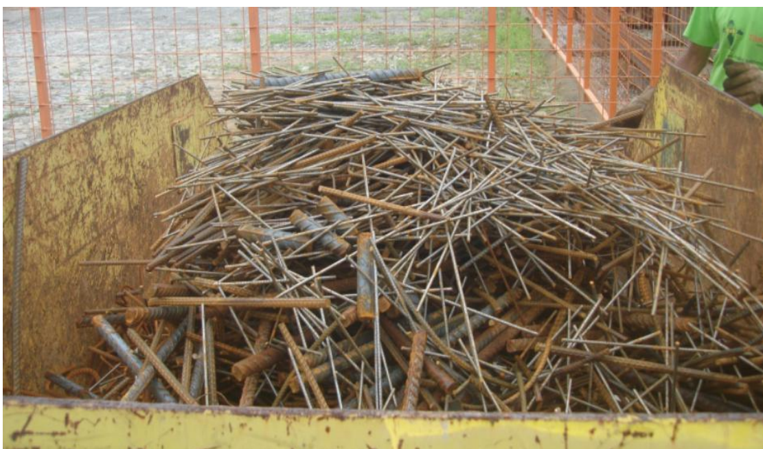
Figura 4.1: Sobras de vergalhões quando cortado e dobrado na obra
