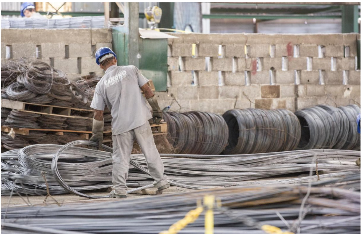
Figura 11.5: Dobra do aço convencional para transporte.
