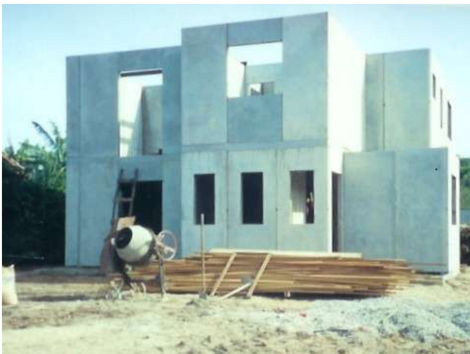
Gravura 12: Casa sendo executada com o Sistema Dominó. Observar os painéis.
