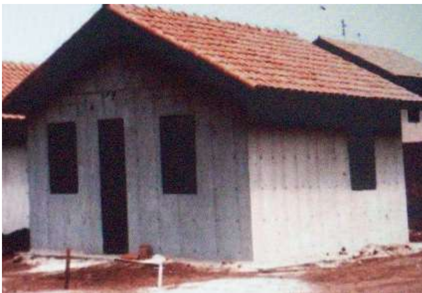
Gravura 07: Casa ABCP em Concreto Celular Espumoso.
