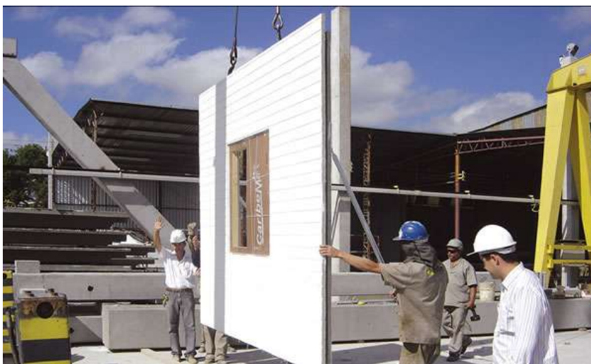
Gravura 10: Painel Plenum, sendo içado para fixação definitiva.
