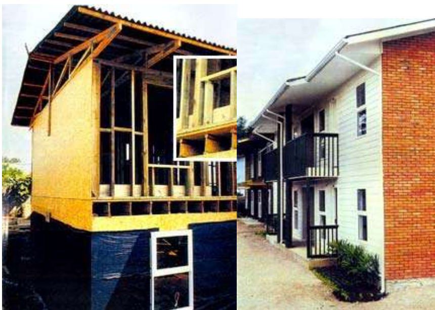
Gravuras 13 e 14: Casa em Light Wood Frame, durante a montagem a acabada.
