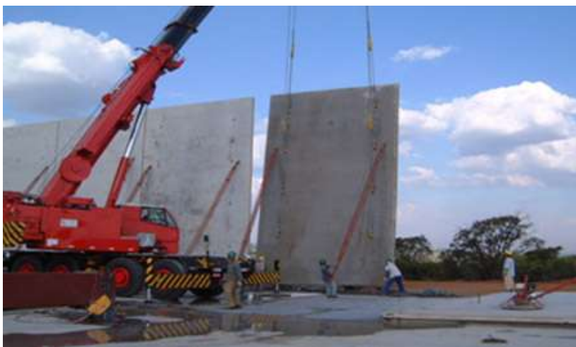
Gravura 11: Painéis Tilt-up, sendo posicionados e escorados, até fixação definitiva.
