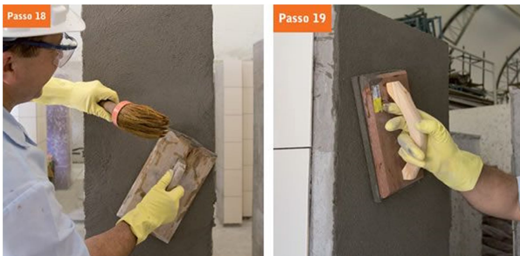
Figura 21 - Com uma desempenadeira com espuma e uma broxa é feita a correção e homogeneização da superfície. Fonte:Revista EQUIPE DE OBRA
