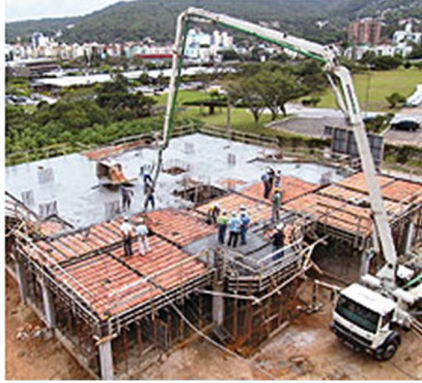
Figura 34 - Visão geral de um pavimento sendo concretado. Fonte:Revista CONSTRUÇÃO MERCADO
