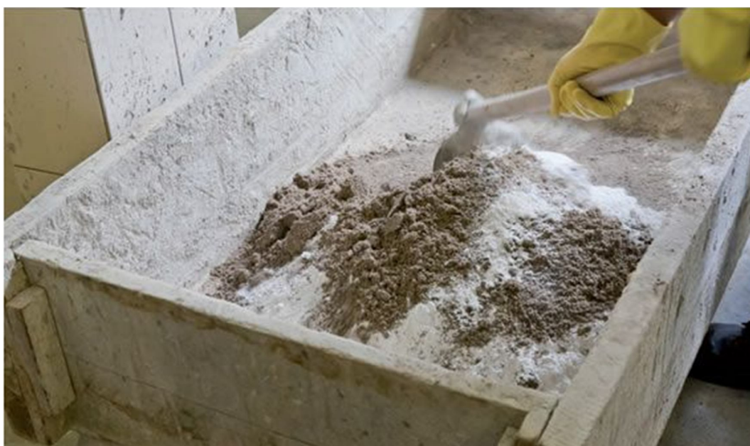
Figura 17 - Mistura de cal e areia 1:4. Fonte:Revista EQUIPE DE OBRA
