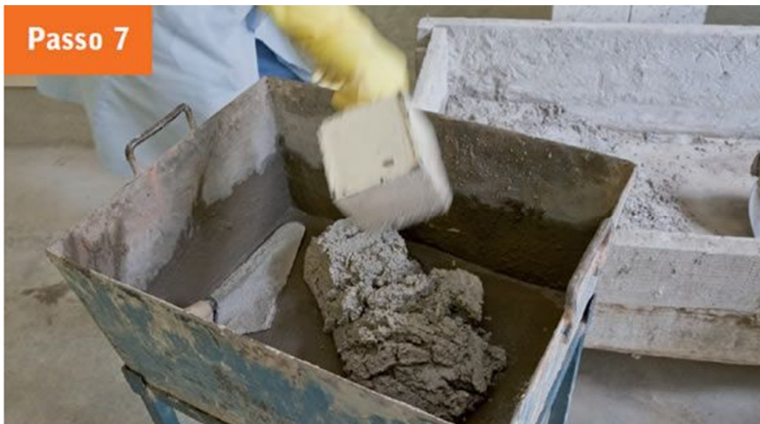
Figura 18 - Adição de cimento após 36 horas. Fonte: Revista EQUIPE DE OBRA
