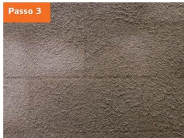
Figura 16 - Aplicação da camada de chapisco (3 a 5mm). Fonte:Revista EQUIPE DE OBRA
