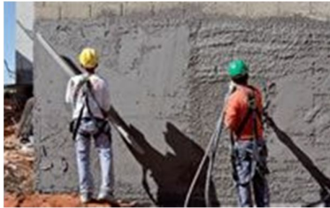
Figura 27 - Sarrafeamento e projeção. Fonte:Revista EQUIPE DE OBRA
