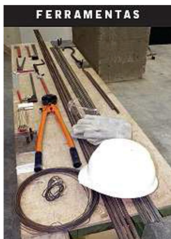
Figura 7 - Materiais e equipamentos necessários Fonte: Revista EQUIPE DE OBRA
