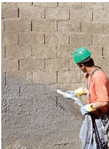
Figura 24 - Aplicação de chapisco utilizando uma pistola de pressão. Fonte:Revista EQUIPE DE OBRA
