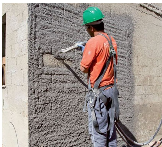
Figura 25 - Aplicação de argamassa em cordões na horizontal. Fonte:Revista EQUIPE DE OBRA
