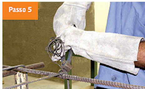
Figura 10 - Corte do excesso de arame recozido Fonte: Revista EQUIPE DE OBRA
