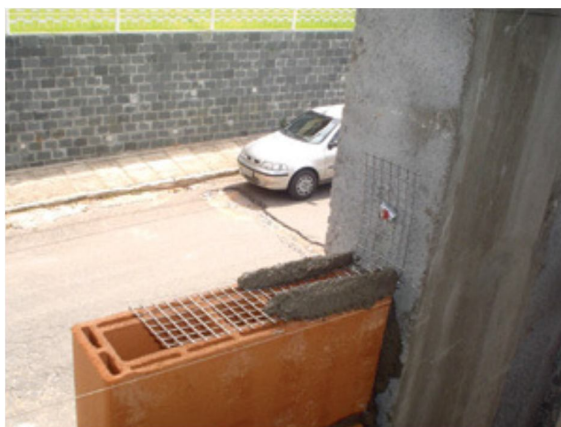
Figura 43- Utilização de telas na alvenaria. Fonte: Revista TÉCNICA
