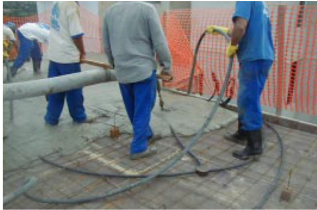
Figura 35 - Concretagem laje de pequena espessura. Fonte: Revista CONSTRUÇÃO MERCADO
