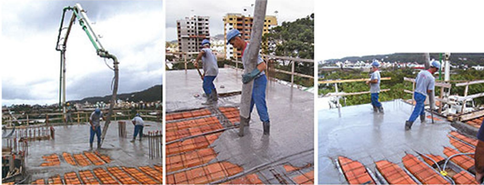
Figura 36 - Concretagem de um pavimento. Fonte: Revista CONSTRUÇÃO MERCADO
