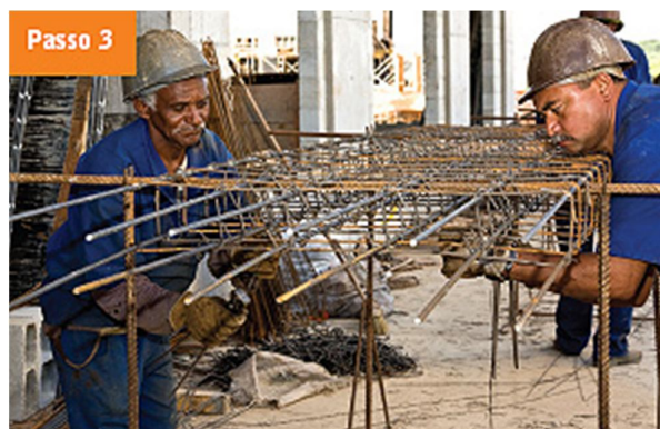
Figura 8 - Montagem da armadura Fonte: Revista EQUIPE DE OBRA
