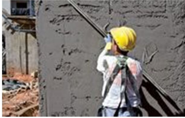
Figura 26 - Sarrafeamento. Fonte:Revista EQUIPE DE OBRA
