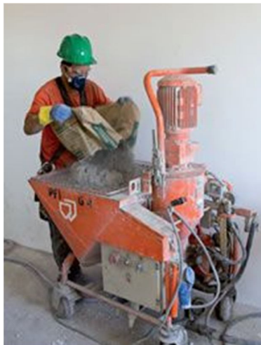
Figura 23 – Equipamento de abastecimento de argamassa na projeção. Fonte:Revista EQUIPE DE OBRA
