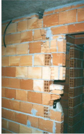
Figura 37 - Alvenaria de vedação tradicional. Fonte:Revista TÉCNNE
