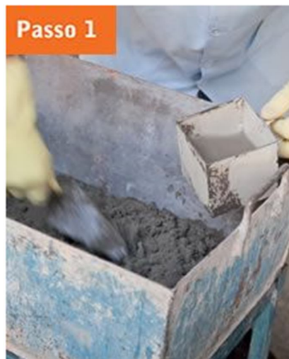
Figura 14 - Mistura areia cimento no traço 1:3 até atingir consistência fluida.
