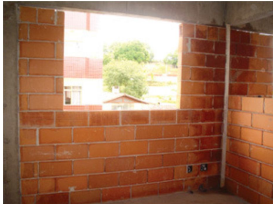
Figura 38 - Alvenaria Racionalizada. Fonte: Revista TÉCNICA
