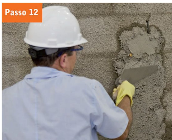
Figura 19 - Aplicação do emboço nas mestras. Fonte: Revista EQUIPE DE OBRA
