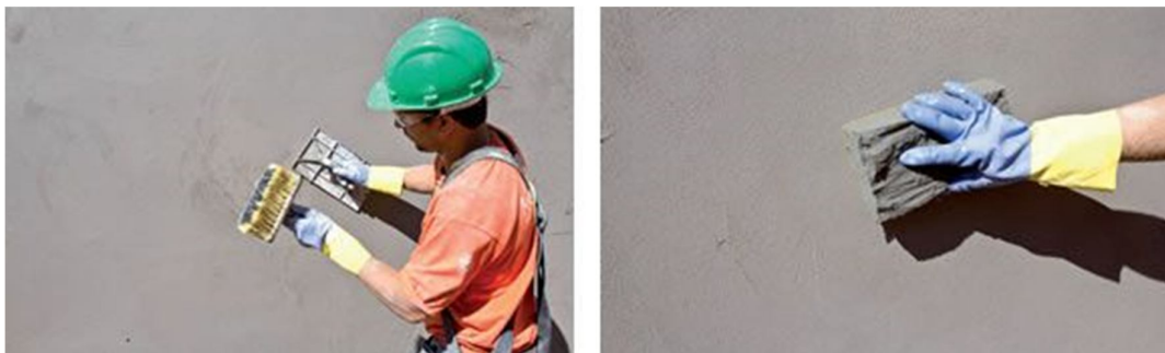
Figura 28 - Regularização final. Fonte:Revista EQUIPE DE OBRA
