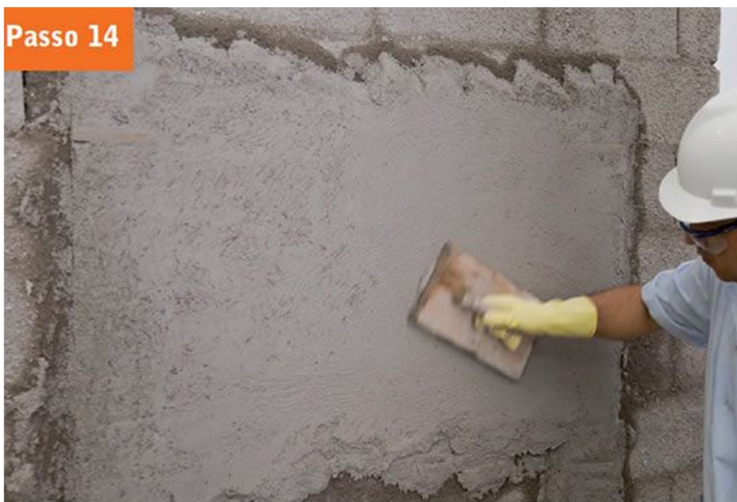
Figura 20 - Desempeno da superfície. Fonte:Revista EQUIPE DE OBRA
