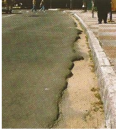
Figura 29 - Escorregamento de massa asfáltica por fluência decorrente do excesso de ligante. (Bernucci, 2007)
