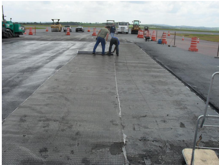
Figura 64 - Aplicação de grelha de fibra de carbono. (Fonte: INFRAERO)
