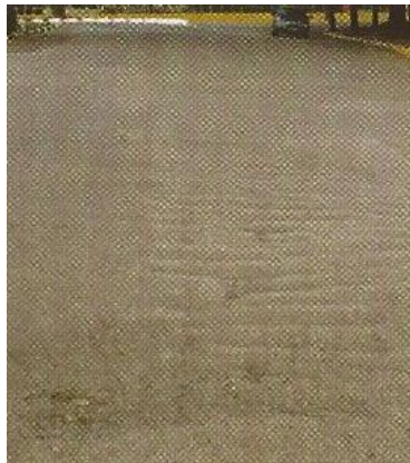
Figura 30 – Corrugação devido ao excesso de massa asfáltica ocorrente em áreas de aceleração e desaceleração. (Bernucci, 2007)
