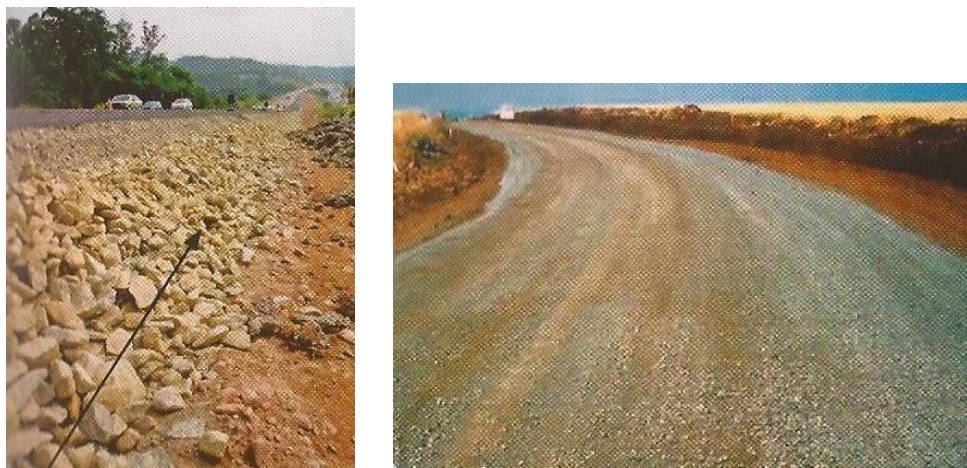
Figura 7 - Materiais granulares usados em bases, sub-bases ou reforços – Rachão e bica corrida. (Fonte: Bernucci et.al., 2007)
