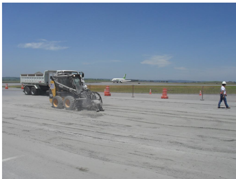
Figura 59 – Execução de fresagem. (Fonte: INFRAERO)
