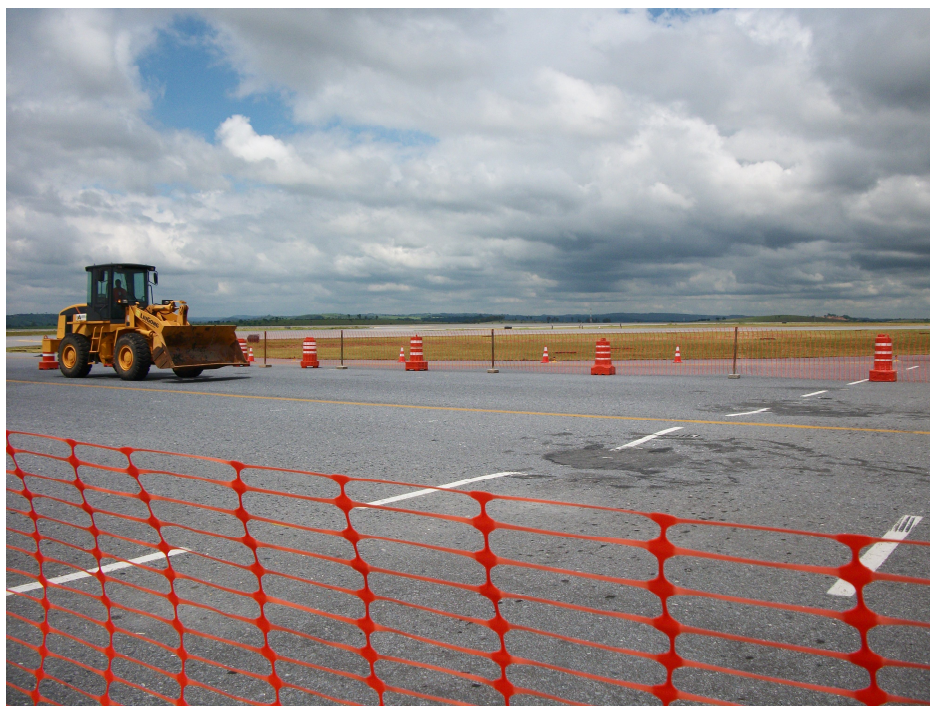
Figura 56 - Área preparada para execução dos serviços. (Fonte: INFRAERO)
