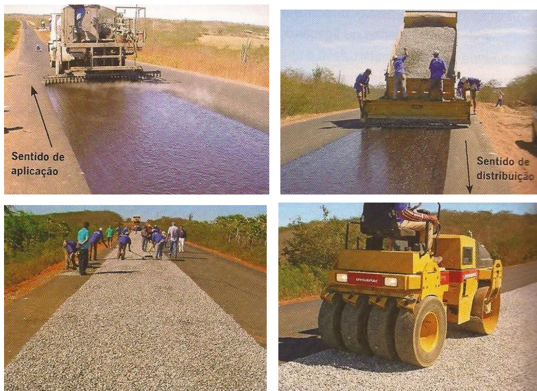
Figura 17 - Etapas sucessivas de um tratamento superficial simples.
