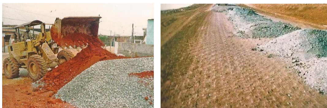
Figura 8 - Solos e solos agregados usados em bases, sub-bases ou reforços – Solo-brita. (Fonte: Bernucci et.al., 2007)
