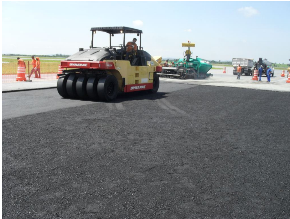
Figura 62 – Aplicação e compactação da primeira camada de CBUQ.
