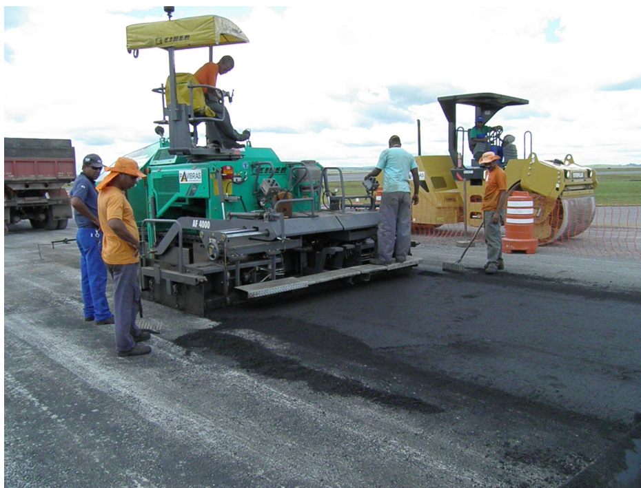
Figura 67 - Acabamento da segunda camada de CBUQ. (Fonte: INFRAERO)
