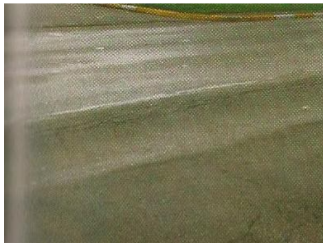
Figura 28 - (a) Afundamento plástico e (b) afundamento por consolidação localizado.
