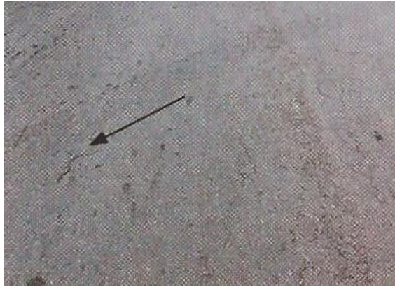
Figura 26 - Trincas longitudinais causadas principalmente pelo envelhecimento do ligante asfáltico.
