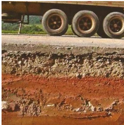
Figura 12 - Estrutura de pavimento com revestimento asfáltico.
