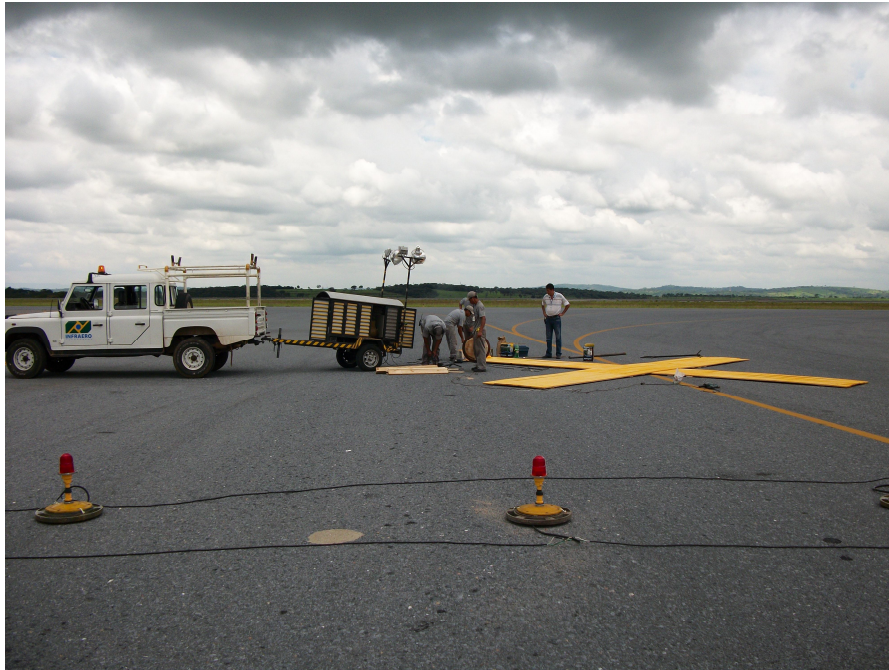
Figura 51 - Sinalização horizontal na superfície asfáltica da taxiway FOX-2. (Fonte: INFRAERO)
