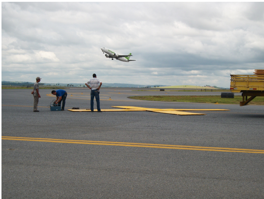
Figura 52 - Sinalização horizontal na superfície asfáltica da taxiway FOX-2. (Fonte: INFRAERO)
