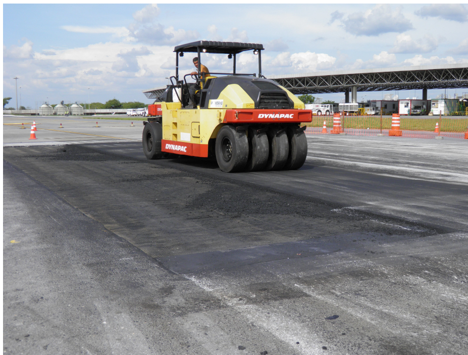
Figura 66 - Compactação da segunda camada de CBUQ. (Fonte: INFRAERO)
