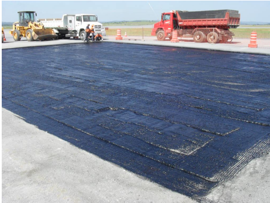
Figura 61 – Imprimação. (Fonte: INFRAERO)
