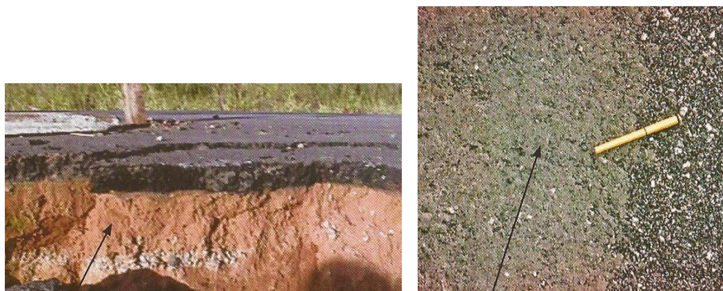
Figura 9 - Materiais cimentados usados em bases, sub-bases ou reforços – Solo cimento e brita tratada com solo cimento. (Fonte: Bernucci et.al., 2007)
