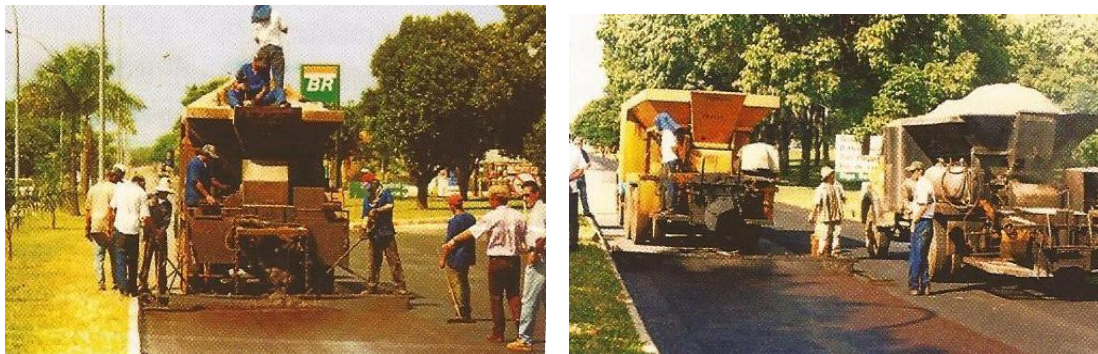
Figura 16 - Exemplo de aplicação de lama asfáltica em trecho de via urbana.
