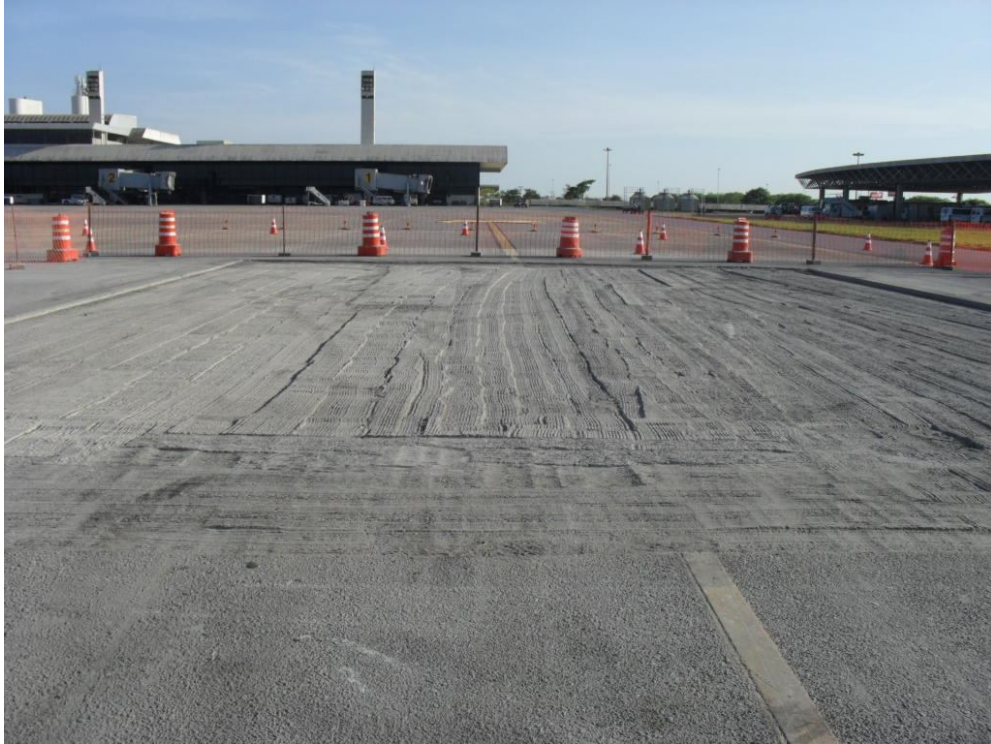
Figura 60 - Área fresada. (Fonte: INFRAERO)
