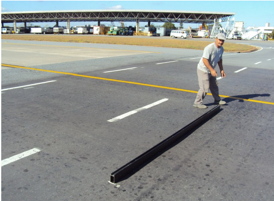
Figura 71 - Monitoramento de recalques no novo trecho recuperado. (Fonte: INFRAERO)
