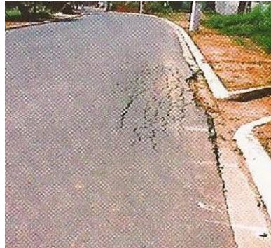
Figura 28 - (a) Afundamento plástico e (b) afundamento por consolidação localizado.
