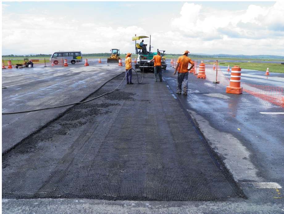
Figura 65 - Aplicação da segunda camada de CBUQ.
