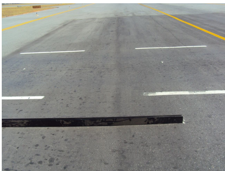
Figura 70 - Monitoramento de recalques no novo trecho recuperado. (Fonte: INFRAERO)
