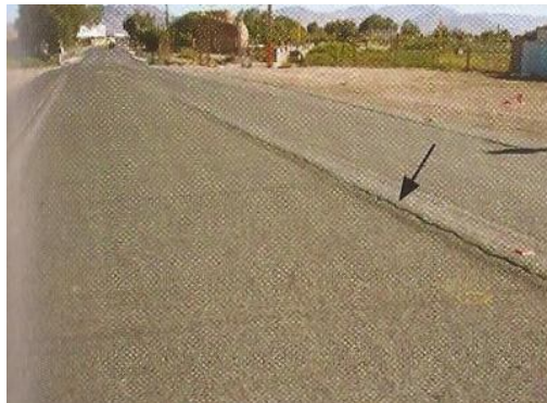
Figura 27 - Trincas de retração.
