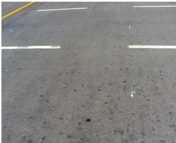
Figura 69 - Trecho recuperado em operação. (Fonte: INFRAERO)
