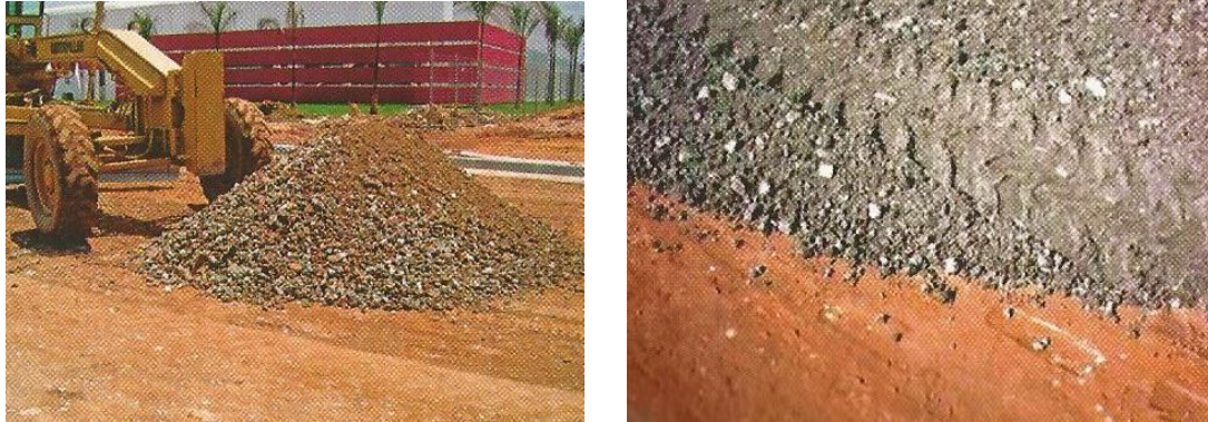
Figura 10 - Materiais reciclados usados em bases, sub-bases ou reforços – Resíduos de construção civil e escória de aciaria.
