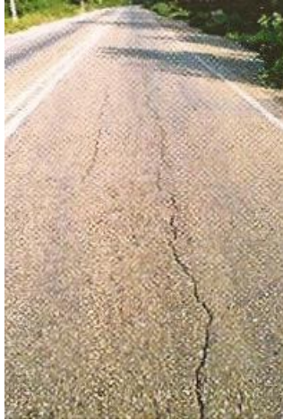
Figura 26 - Trincas longitudinais causadas principalmente pelo envelhecimento do ligante asfáltico.
