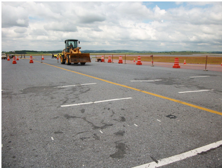
Figura 55 – Área preparada para execução dos serviços. (Fonte: INFRAERO)
