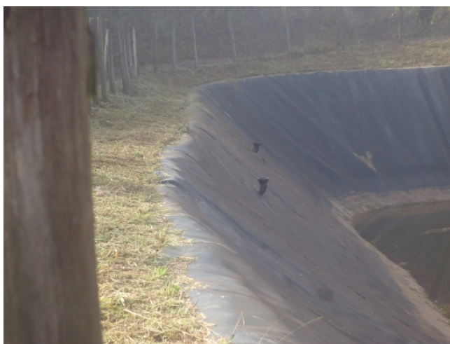
Figura 3.2: Lagoa de estabilização do Aterro Sanitário de Itabirito.
