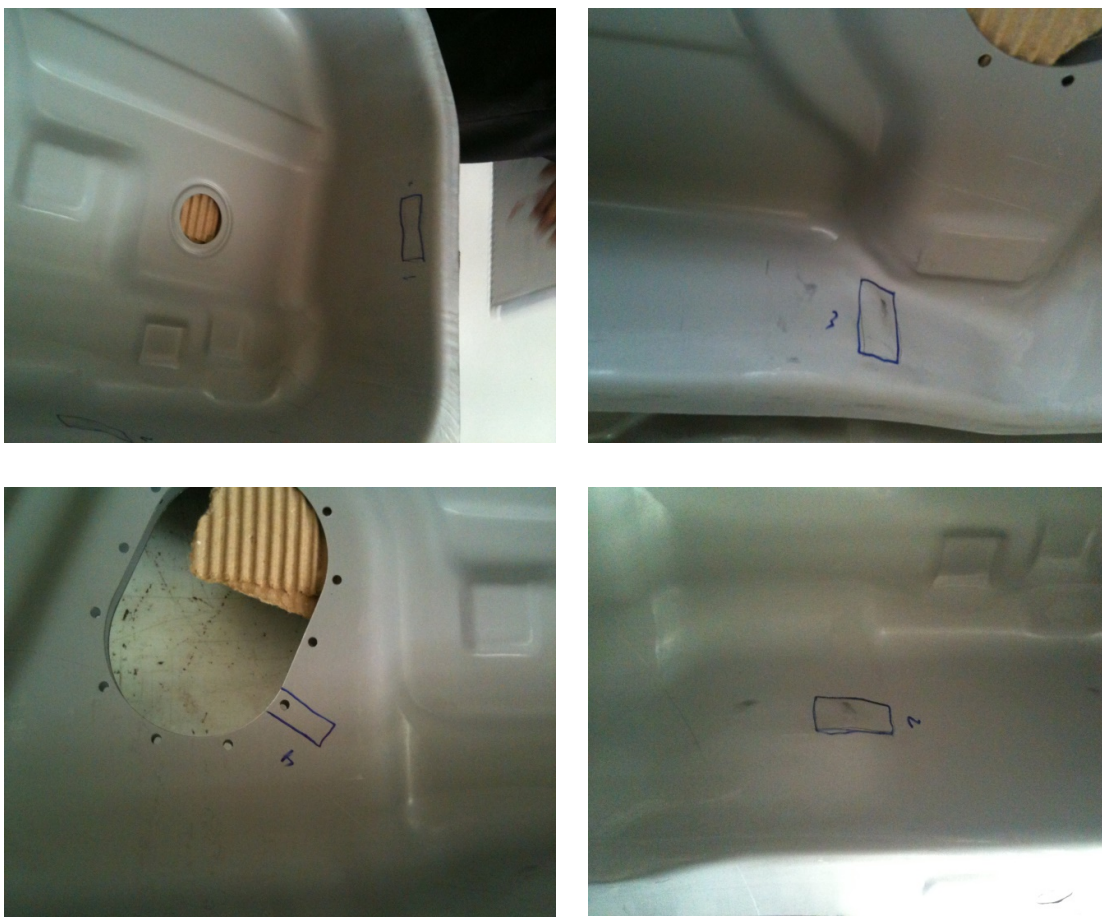
FIGURA 22 Inspeção visual dos tanques para amostragem nas regiões críticas.
