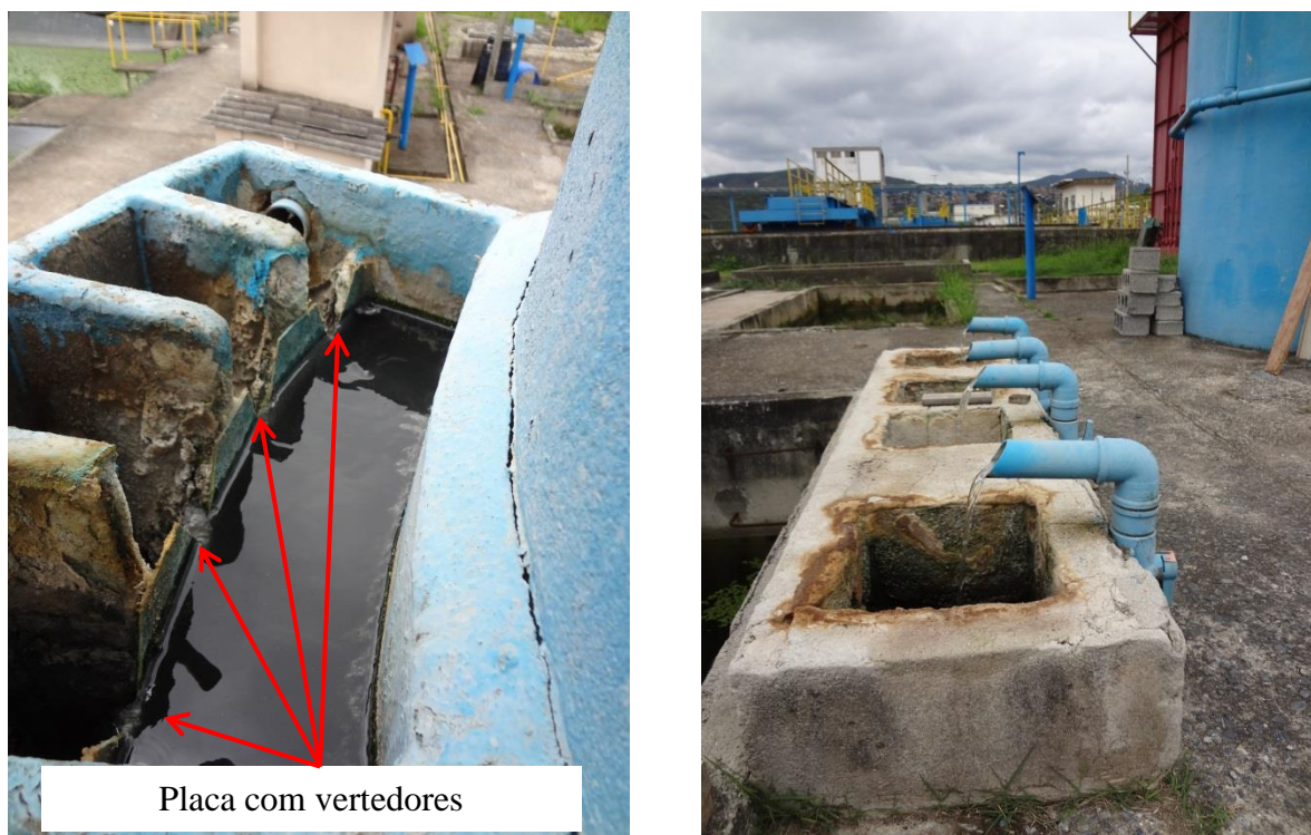
FIGURA 4.4: Sistema de distribuição do efluente do reator UASB para as duas lagoas em paralelo. (a) caixa de distribuição do reator UASB e (b) tubulação de saída para Lc/Lodo e Ls/Lodo.
