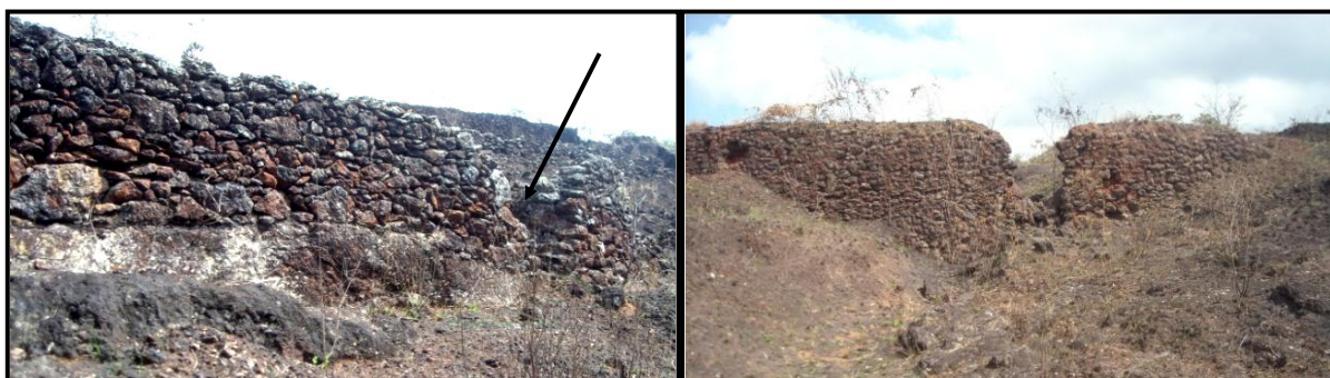
Figura 12 – Fotografias da vista de ruínas de mundéus. À esquerda, um mundéu semicircular em alvenaria. A seta indica o local de escoamento da água. À direita, detalhe do espaço para saída de água. Mariana, Morro de Santana
