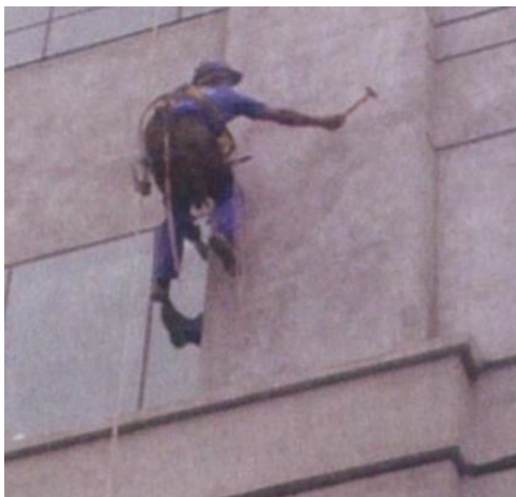
Figura 3.6: Realização de ensaio de percussão Fonte: CARASEK, s.d, s.p
