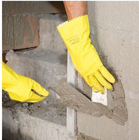
Figura 2.8: Aplicação de massa grossa ou emboço Fonte: Engenharia Civil, 2013, s.p.
