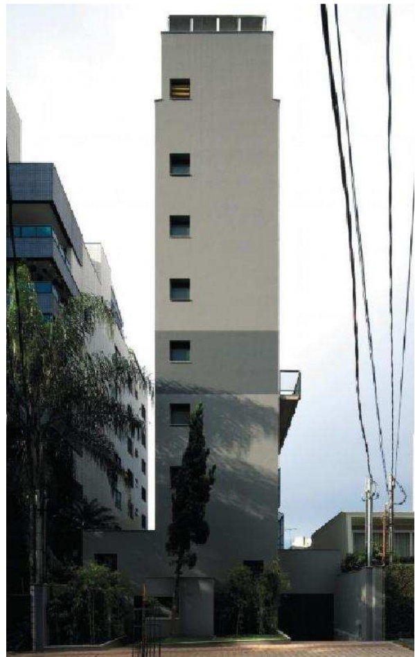
Figura 06 – Fachada Frontal ed. Montevideú Fonte: revista arquitetura e urbanismo
