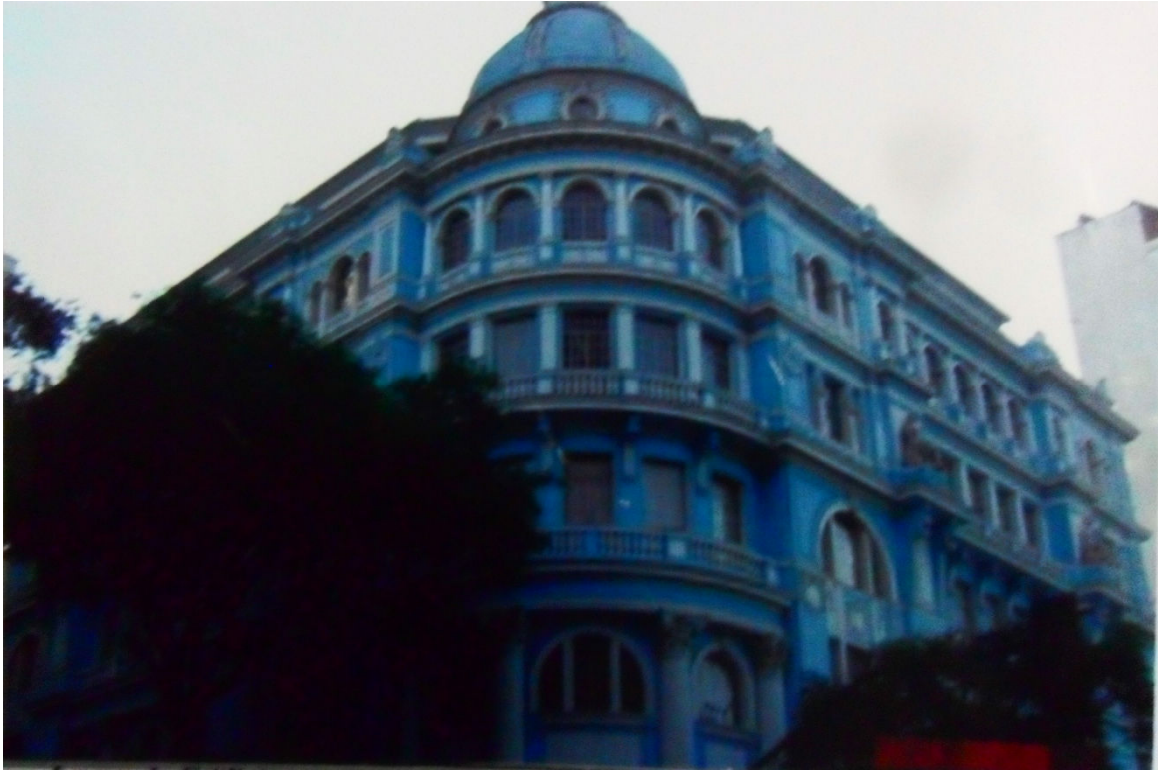
Figura 4 – Fachada Lages JK – biblioteca SESC
