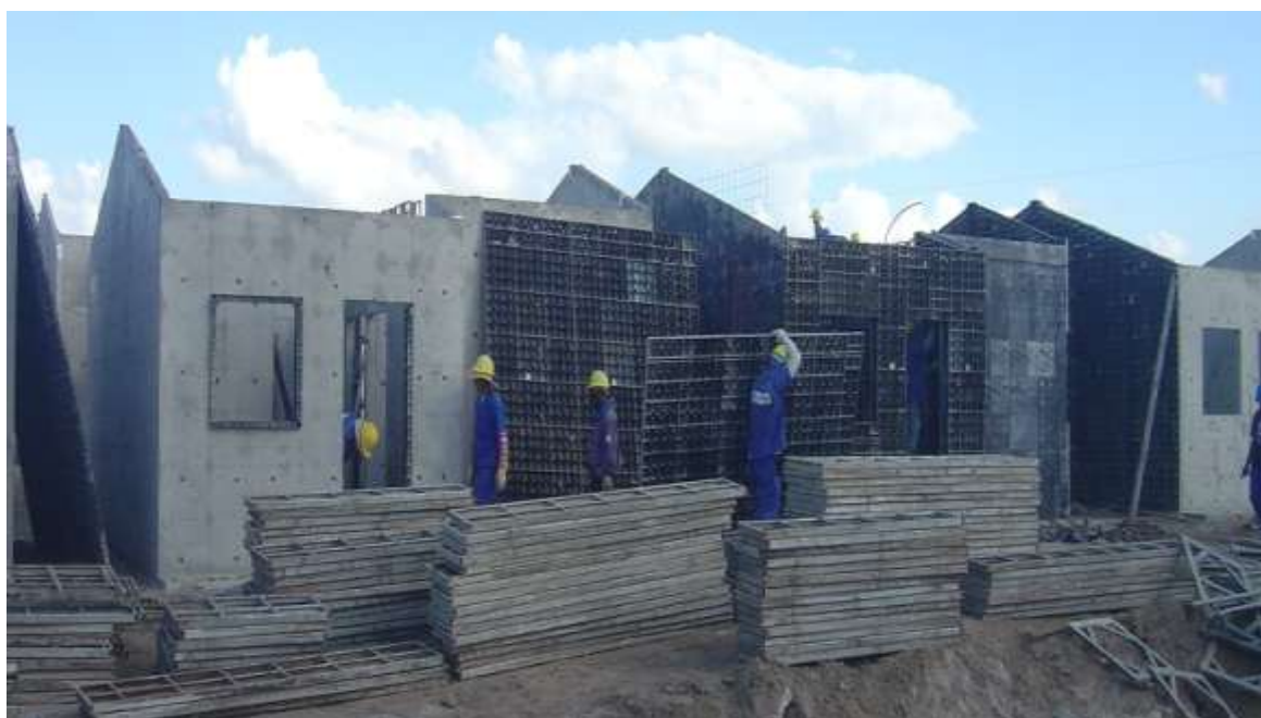
Figura 2.25: Desfôrma Fonte: Metro Modular, 2013
