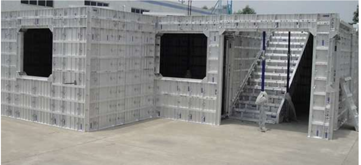
Figura 2.20: Fôrma de alumínio monoportáveis Fonte: Comunidade da Construção – Produtos e Serviços, 2013
