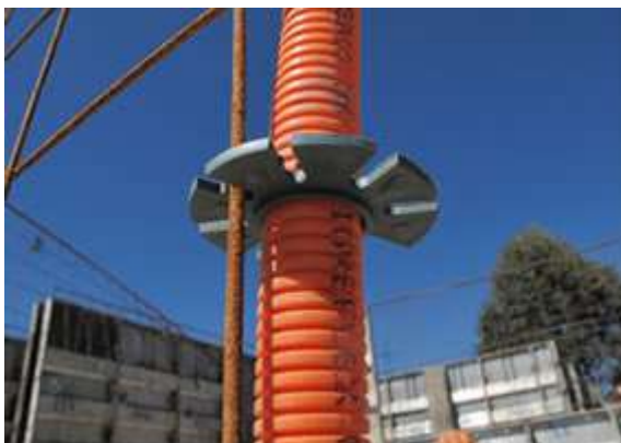
Figura 2.17: Uso de espaçador plástico para ligação de eletroduto na armadura Fonte: ABCP, 2010
