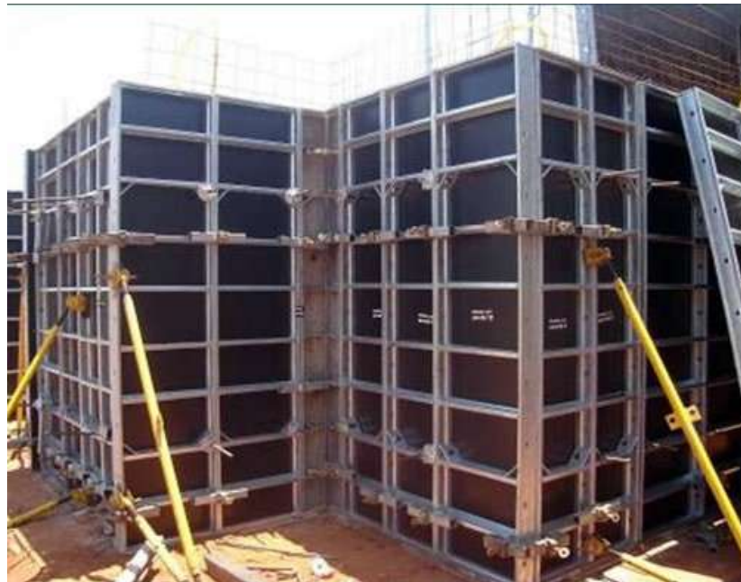
Figura 2.21: Fôrma metálica e compensado Fonte: Comunidade da Construção, 2013
