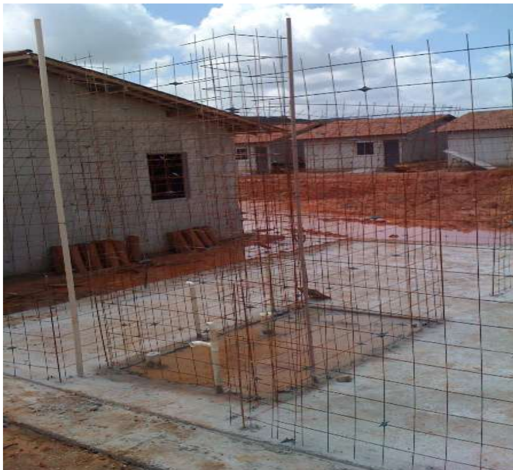
Figura 2.15: Execução das armaduras no sistema Parede de Concreto Fonte: Gethal Sistemas Construtivos, 2013
