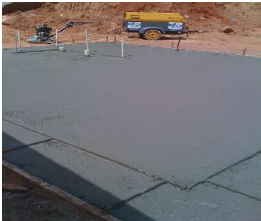
Figura 2.13: Fundação tipo Radier Fonte: Gethal Sistemas Construtivos, 2013
