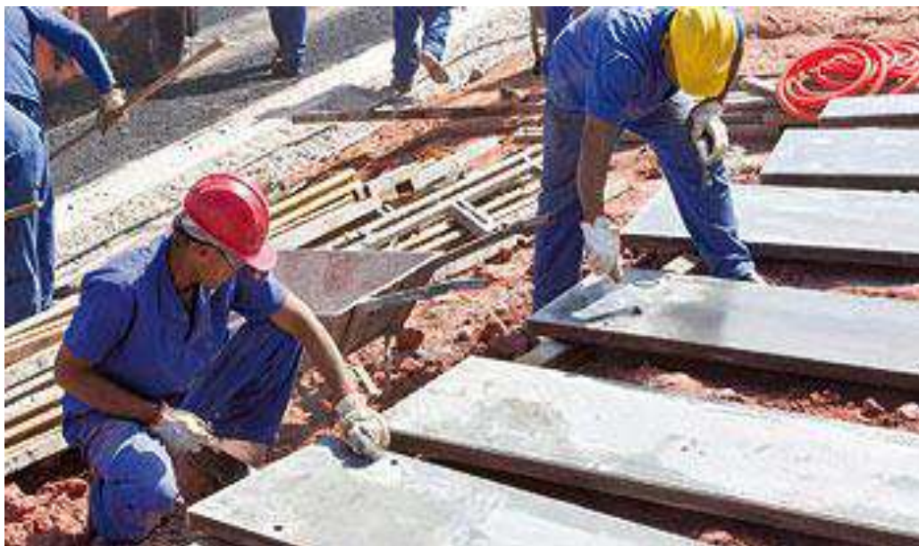
Figura 2.26: Limpeza das formas Fonte: Revista Equipe de Obras, 2011
