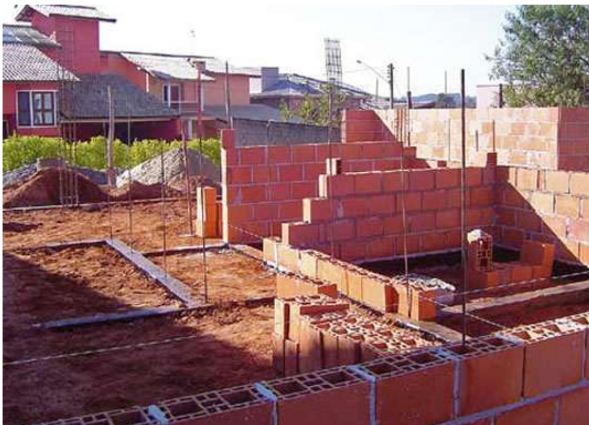
Figura 2.7: Alvenaria estrutural em blocos de cerâmica Fonte: Paula Magrini - Revista Casa & Construção, 2008
