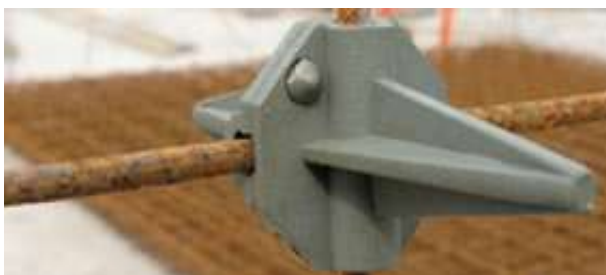
Figura 2.18: Uso de distanciador plástico na armadura Fonte: Núcleo Parede de Concreto, 2012
