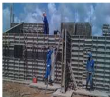
3 - Montagem das Fôrmas
