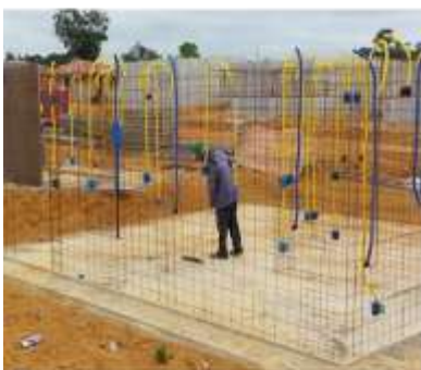
2 - Armaduras e Instalações
