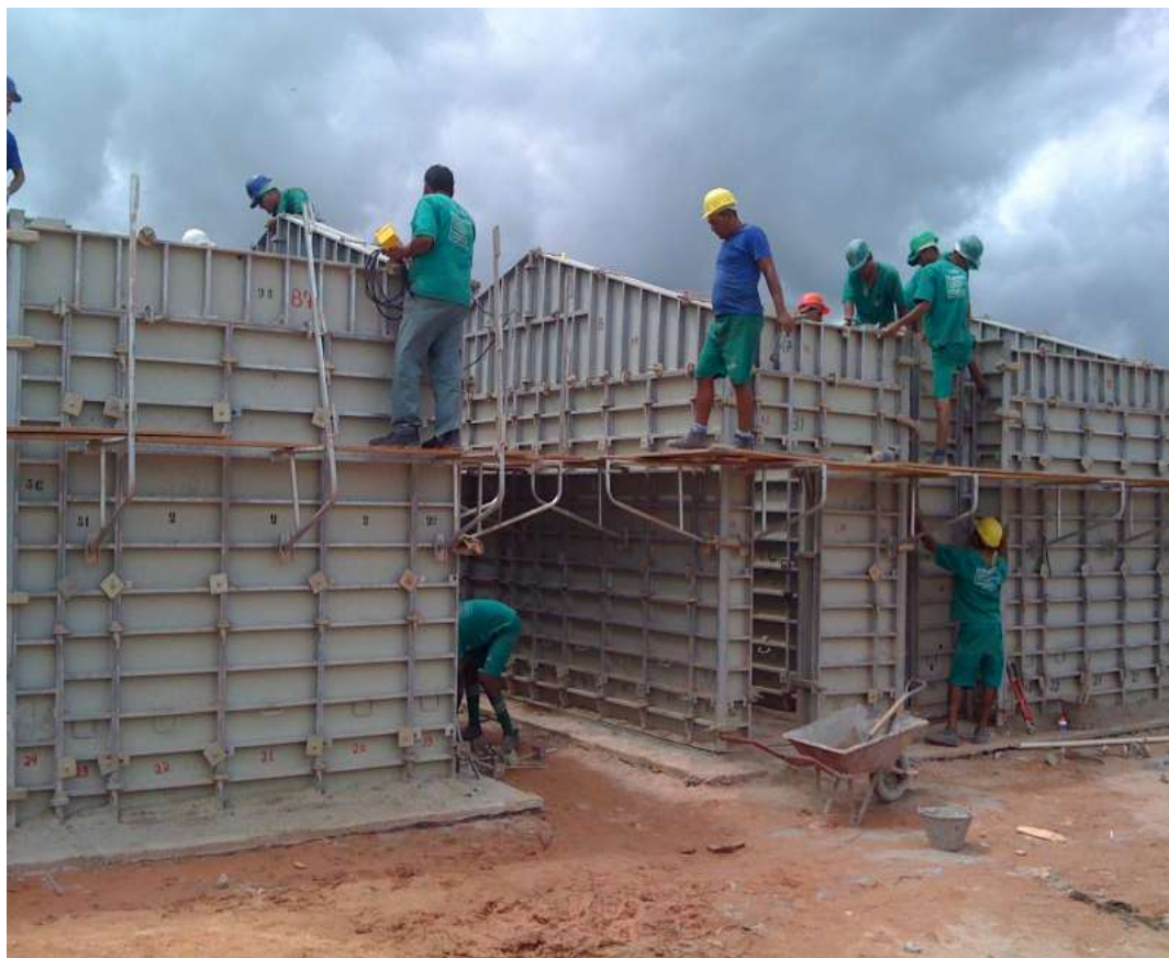
Figura 2.23: Montagem de fôrmas no sistema Paredes de Concreto Fonte: Gethal, 2013
