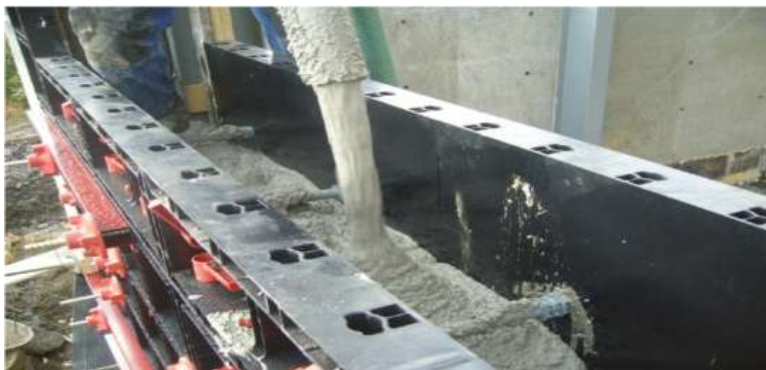
Figura 2.28: Aplicação de concreto no sistema Paredes de Concreto Fonte: Ecopore, 2013
