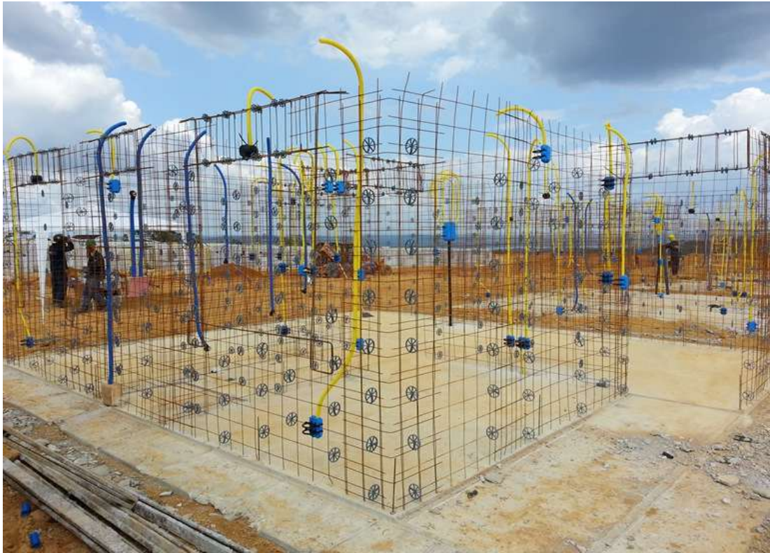
Figura 2.19: Montagem da rede elétrica no sistema Paredes de Concreto Fonte: Metro Modular, 2013
