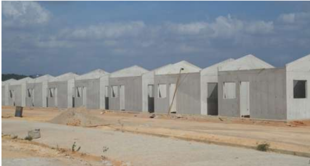
Figura 2.10: Conjunto habitacional sendo construído com o sistema Paredes de Concreto Fonte: Ecopore, 2013
