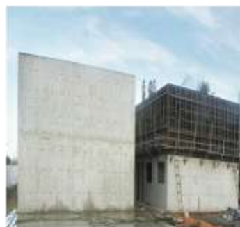
5 - Retirada das Fôrmas
