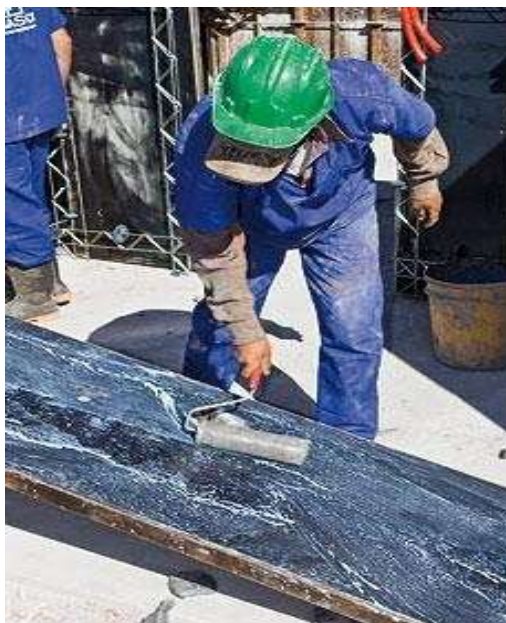
Figura 2.24: Utilização de desmoldante Fonte: Projeto de Casas, 2011
