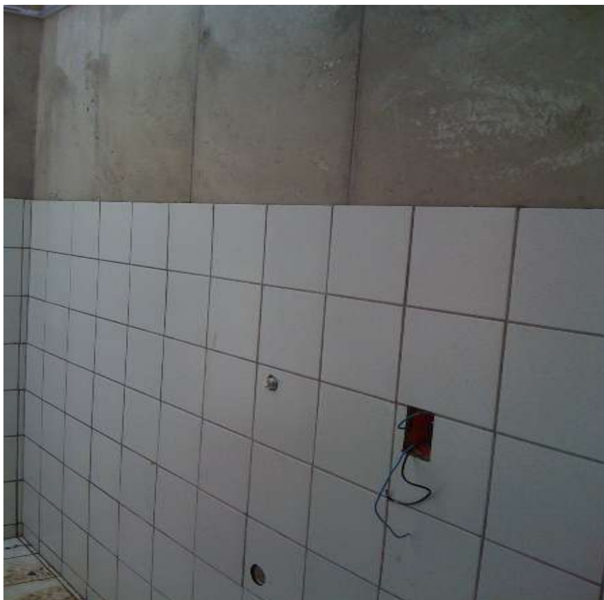
Figura 2.30: Revestimento feito diretamente sobre as Paredes de Concreto Fonte: Gethal Sistemas Construtivos, 2013
