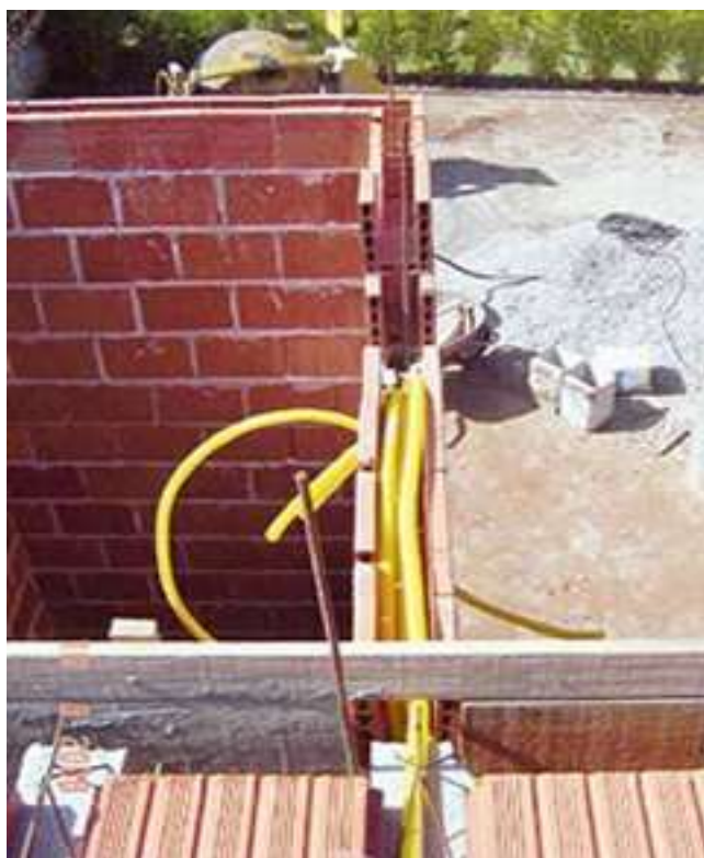
Figura 2.9: Tubulações elétricas sendo embutidas no sistema de alvenaria estrutural Fonte: Paula Magrini - Revista Casa & Construção, 2008
