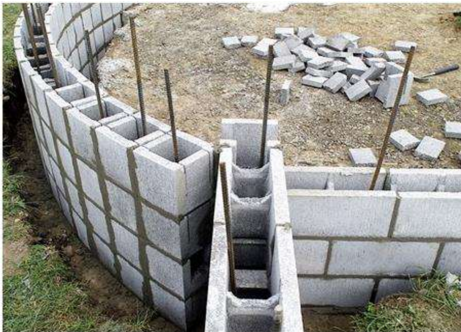
Figura 2.6: Alvenaria estrutural em blocos de concreto Fonte: Núcleo de Apoio Pedagógico à Educação a Distância - UFRGS, 2011
