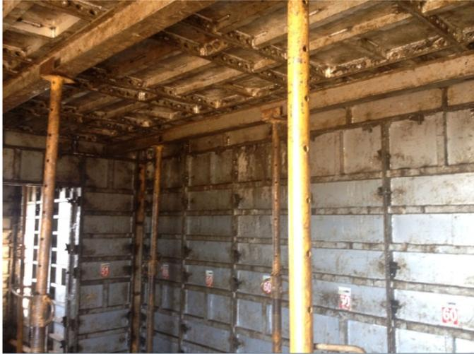
**Figura 61:** Sistema de fôrmas em lajes e paredes (Fonte: QRTZ Incorporações – Belo Horizonte)
