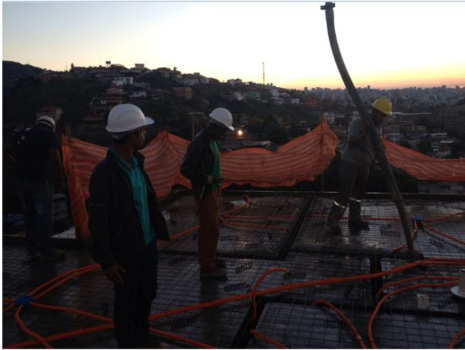
**Figura 58:** Aplicação do CAA em lajes (Fonte: QRTZ Incorporações – Belo Horizonte)
