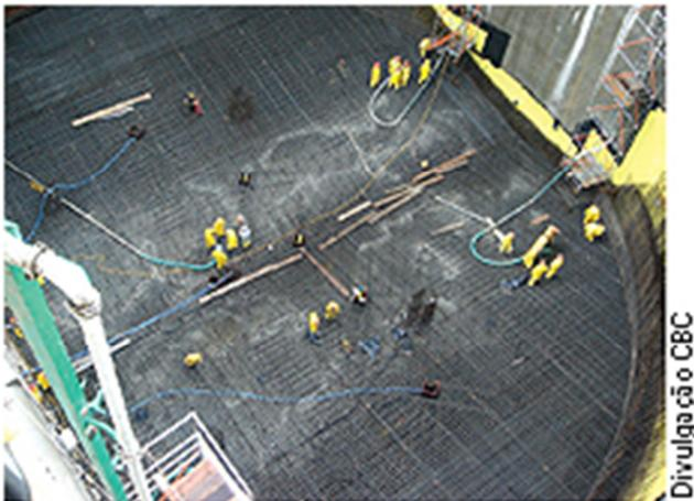
**Figura 35:** Concretagem da laje de fundo dos poços da estação (Fonte: Revista Técnica, 2008)
