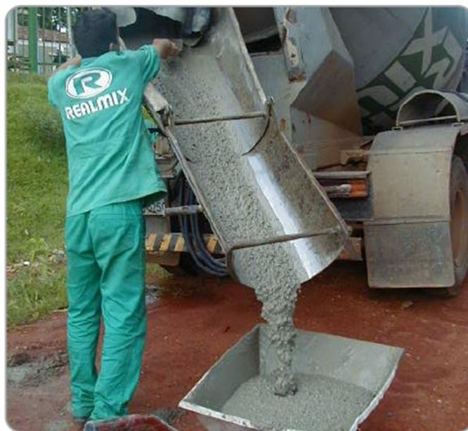
**Figura 43:** Descarga de concreto feito pelo caminhão betoneira (Fonte: REALMIX, 2005)
