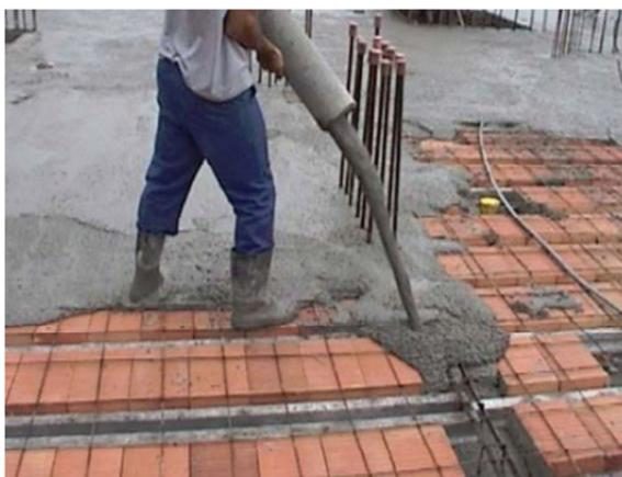
**Figura 4:** Aplicação do concreto auto-adensável em lajes (IBRACON, 2011)
