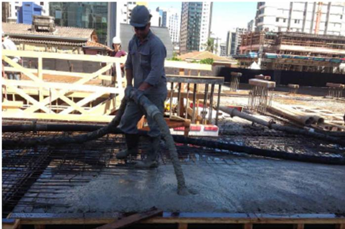
**Figura 59:** Aplicação do CAA em lajes (Fonte: Direcional Engenharia – Belo Horizonte)
