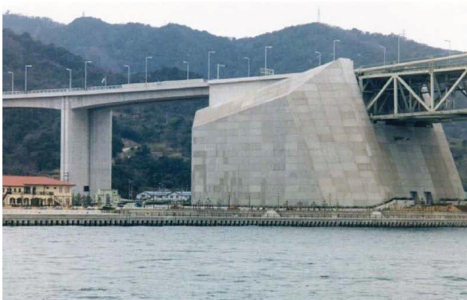
**Figura 23:** Blocos de ancoragem na ponte Akashi-Kaikyo (Fonte: Comunidade da Construção, 2012)
