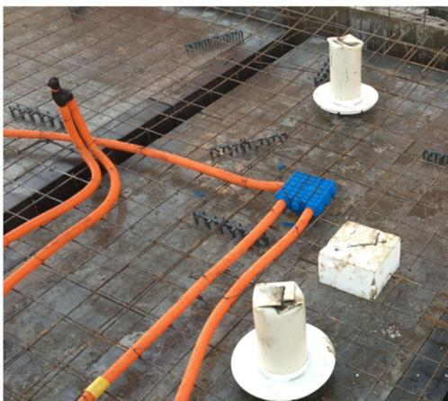
**Figura 54:** Trecho de laje liberado para o concreto
