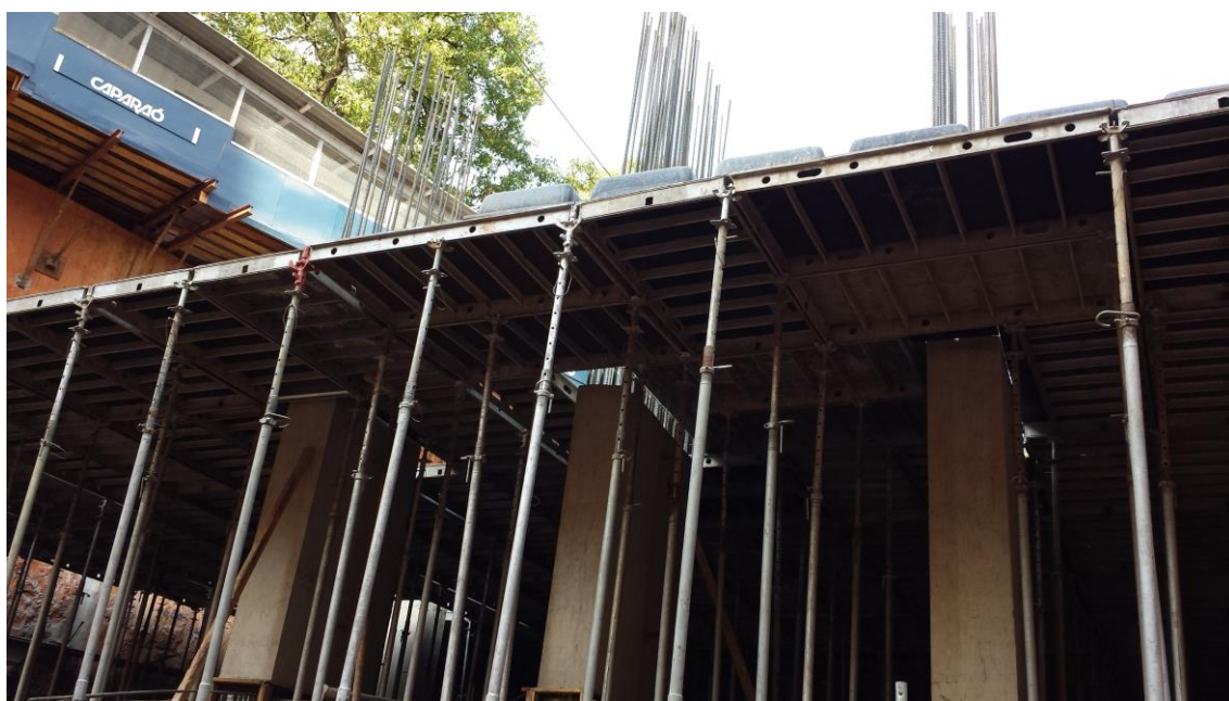
Figura 34: Laje forrada (pé-direito duplo) vista de baixo Fonte: Construtora Caparaó, 2013
