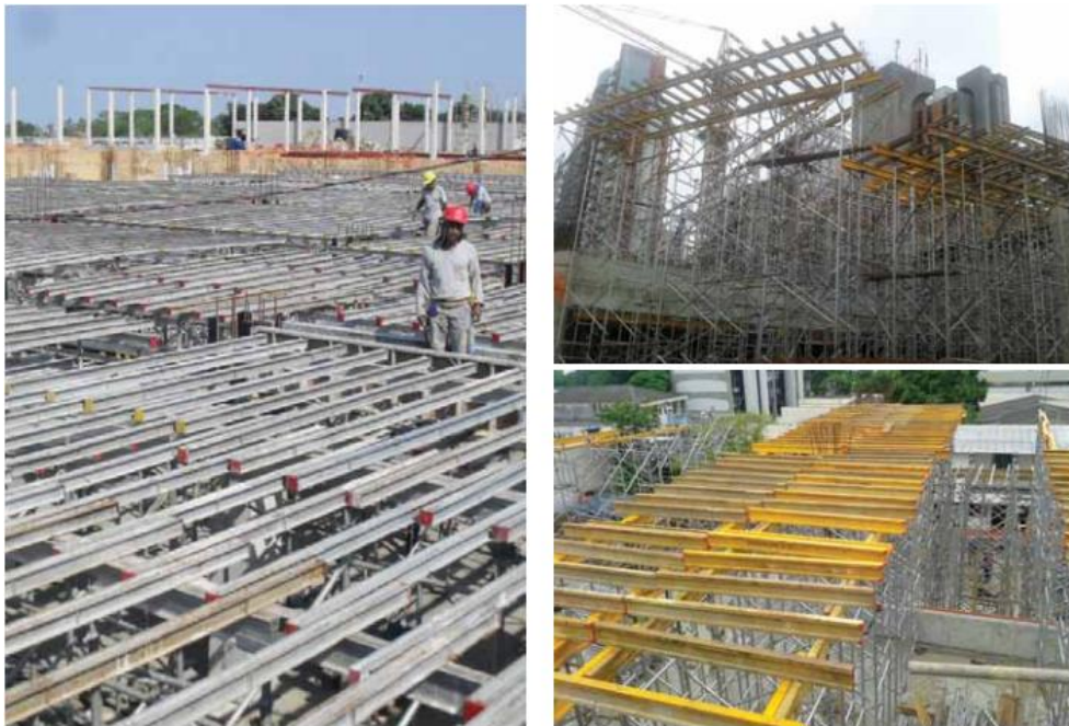
Figura 19: Montagem de cimbramentos Fonte: SH Fôrmas, 2013
