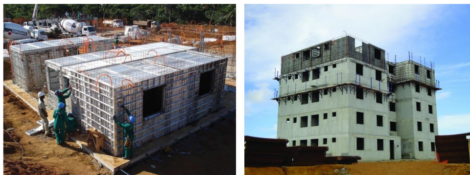
Figura 17: Sistema Easy-set Fonte: Mills, 2013
