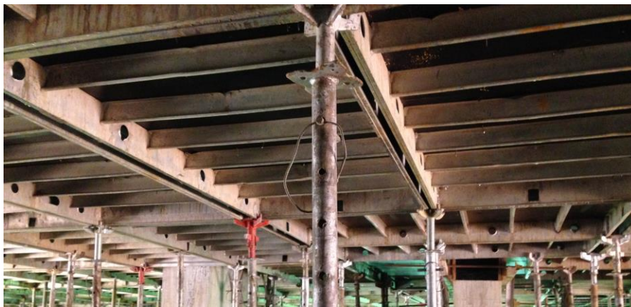
Figura 31: Detalhe do posicionamento das escoras no sistema TOPEC SH Fonte: Construtora Caparáó, 2013
