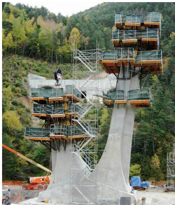
Figura 24: Execução de torres com fôrmas trepantes Fonte: Ulma, 2013
