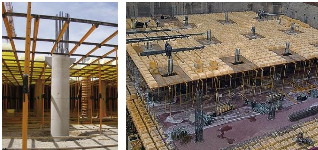
Figura 18: Montagem do sistema RECUB Fonte: Ulma, 2013
