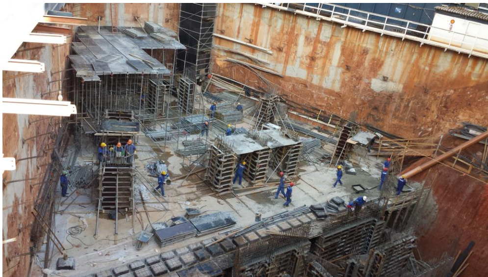
Figura 35: Montagem da laje do teto do 2º subsolo (pé-direito duplo) Fonte: Construtora Caparaó, 2013
