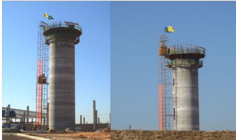
Figura 22: Execução de torres de água com sistema deslizante Fonte: Buzolin Torres D'água
