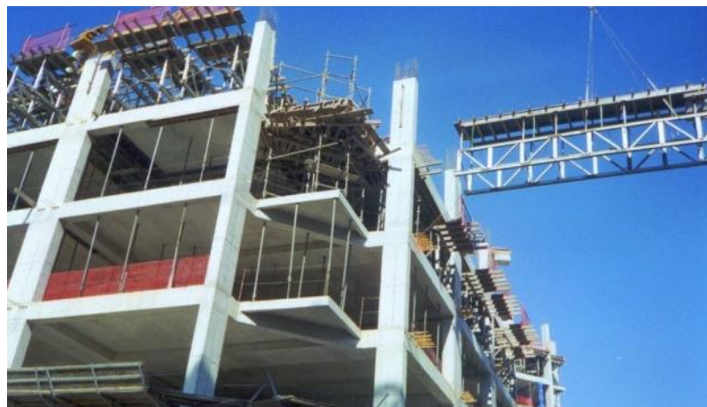
Figura 20: Sistema de mesas voadoras Fonte: Mills, 2013
