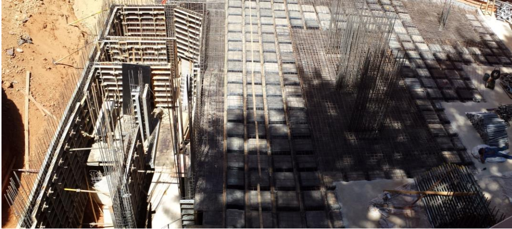
Figura 32: Laje e paredes do teto do 4º subsolo Fonte: Construtora Caparaó, 2013
