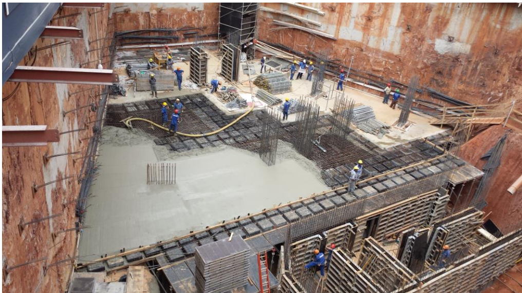
Figura 33: Concretagem da laje do teto do 4º subsolo Fonte: Construtora Caparaó, 2013
