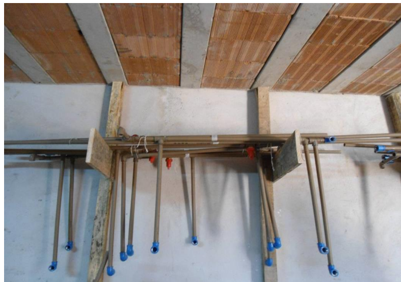
Figura 21: Estoque de tubulações (Elaborada pelo autor).
