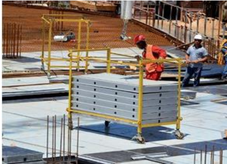
Figura 9: Limpeza e organização no canteiro. Fonte: http://construplena.com.br/noticia.php?id=15
