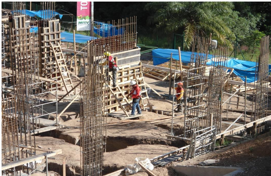
Figura 17: Montagem da forma (Elaborada pelo autor).
