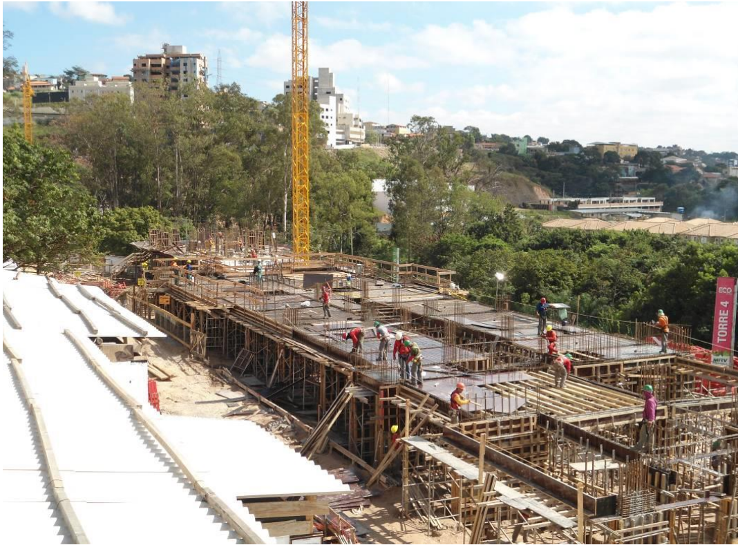
Figura 15: Execução da torre 4.(Elaborado pelo autor).
