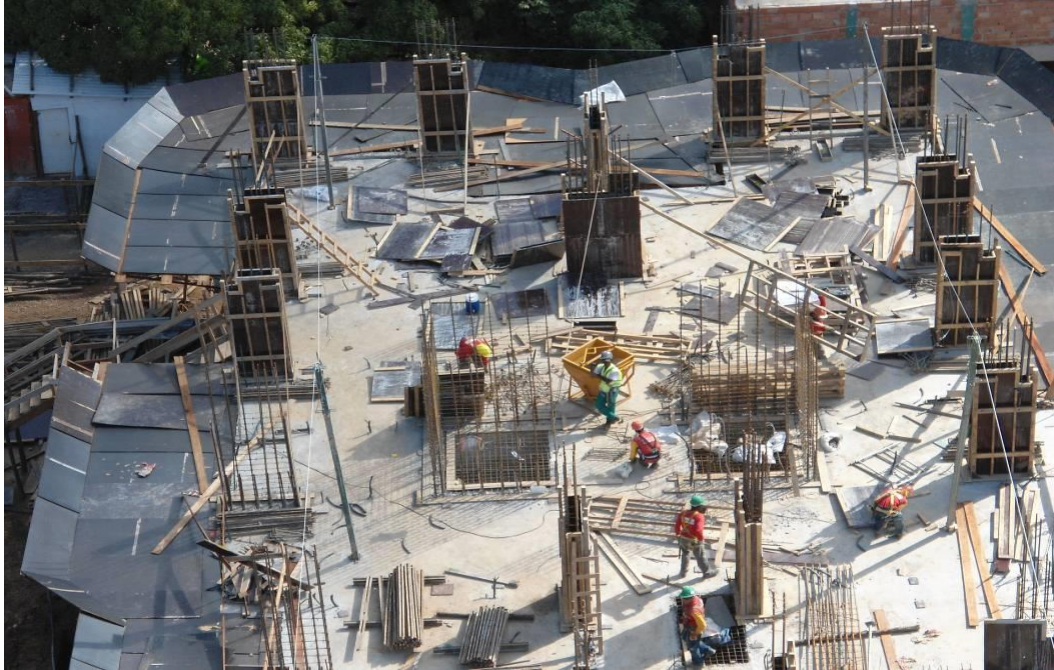
Figura 18: Montagem da forma, no segundo pavimento (Elaborada pelo autor).
