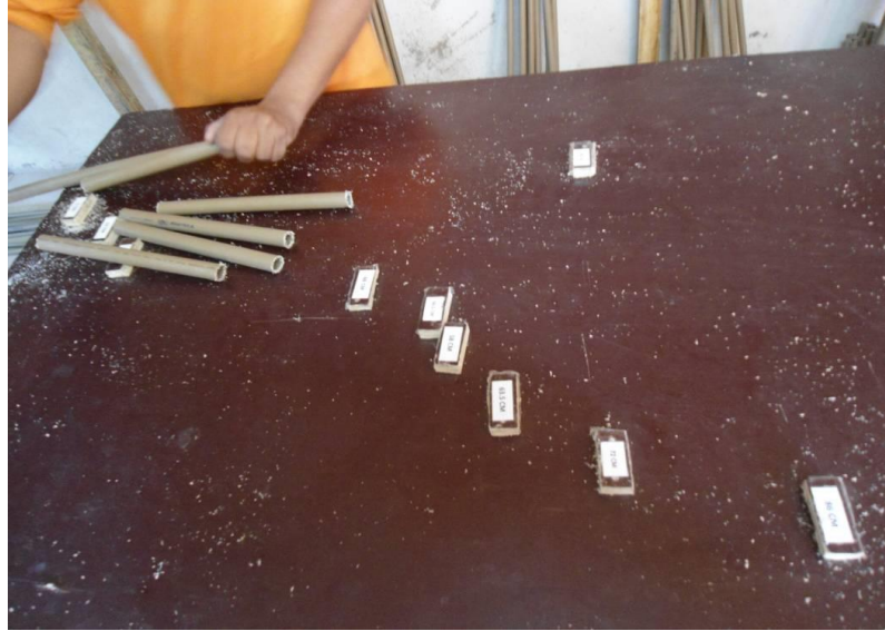
Figura 20: Montagem das tubulações sobre medida (Elaborada pelo autor).
