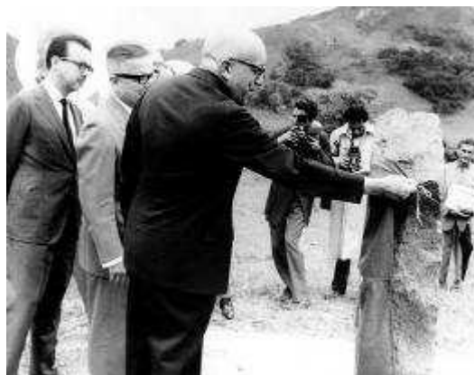
Figura 4: Início das obras em 1962.
