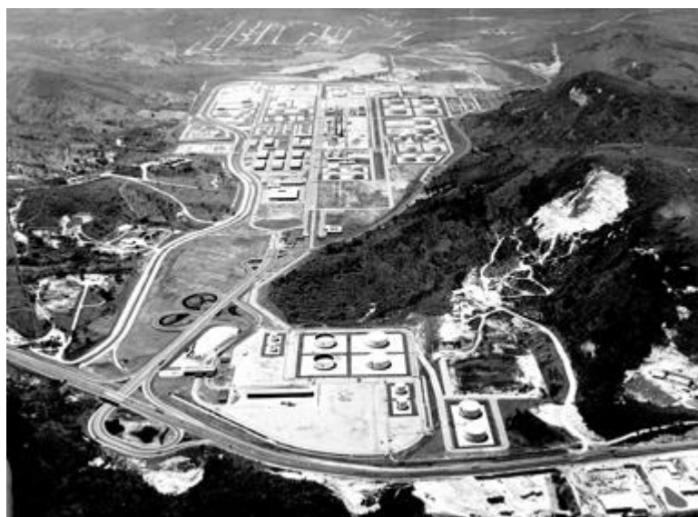
Figura 2: Vista aérea da REGAP início anos 70.
