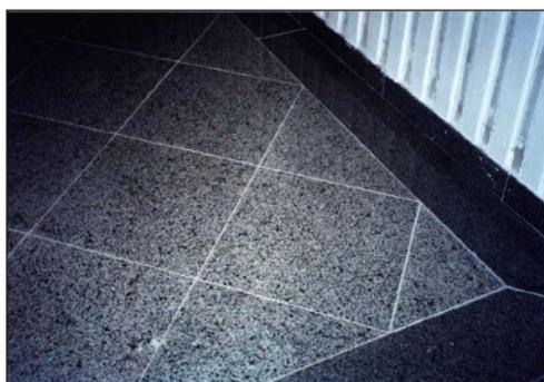
**Figura 22** – Ambiente interno (hall de elevador) revestido com placas polidas de granito (30x30 cm) e bordas de placas escuras de diorito (10x60 cm) – Botucatu / SP - (LAMAGUTI, 2001)
