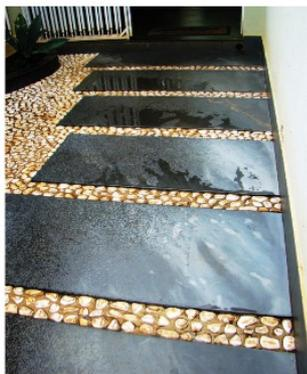
**Figura 35** – Piso combinado de seixos e lajões de ardósia cinza - (AMAR / MG)
