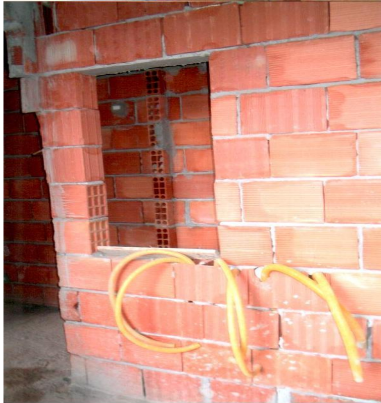
Figura 5.1: Alvenaria paginada executada.
