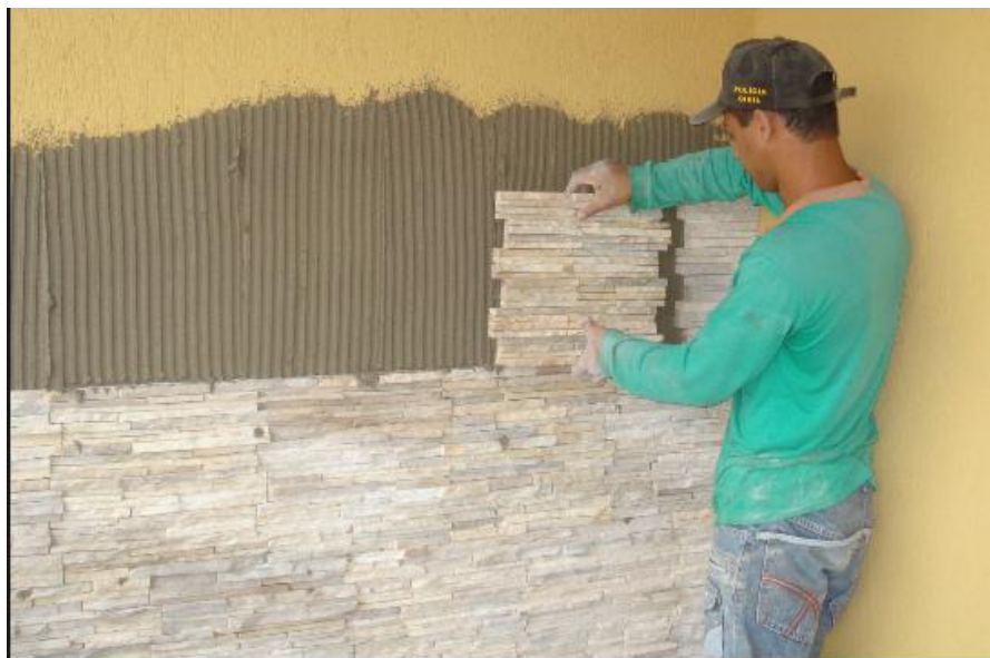
Figura 5.4: Aplicação de pedra filetada por placa pronta.
