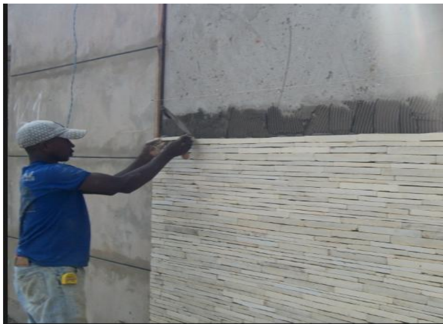
Figura 5.3: Execução de revestimento em Pedra Filetada
