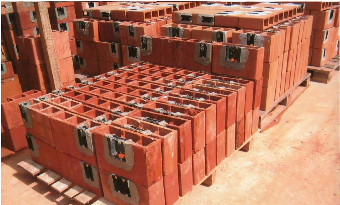
Figura 5.2: Estoque de blocos canaletas com as caixas elétricas chumbadas.
