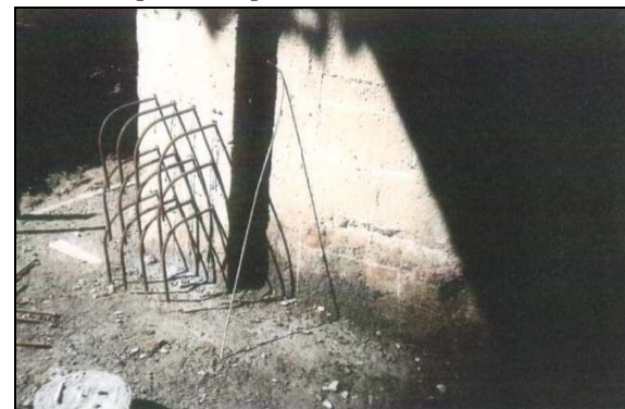
(f) Detalhe da ancoragem dos pilares nos novos blocos de fundação.
