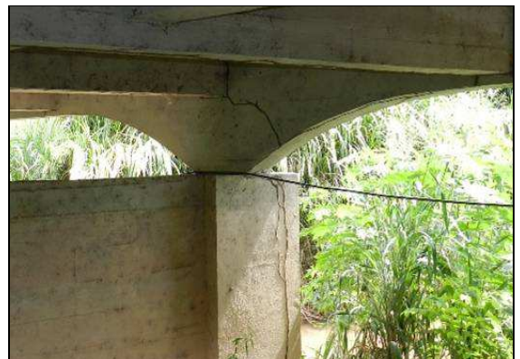
(f) Apoio com pequeno deslocamento da longarina em relação ao pilar
