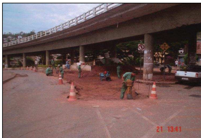
Figura 4.70 – Rebaixamento de pista de acesso à via sob o viaduto.
