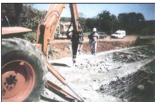
(a) Demolição das lajes
