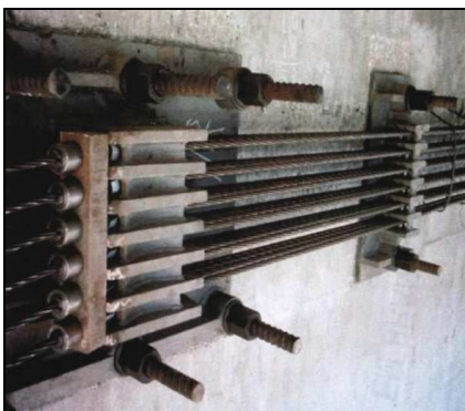
(a) Ancoragem do sistema de protensão
