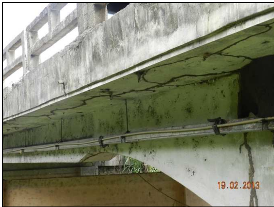
(c) Bom estado dos elementos apesar das manchas de sujeira e ninhos de aranhas – vista lateral da longarina e do reforço realizado na sua região central
