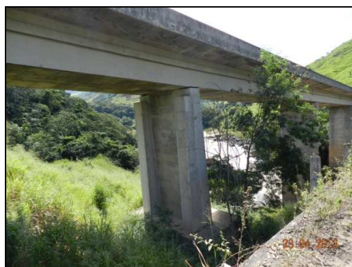
(b) Pilar P2 e a estrutura do reforço em bom estado
