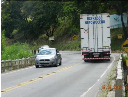
(a) Vista geral da ponte
