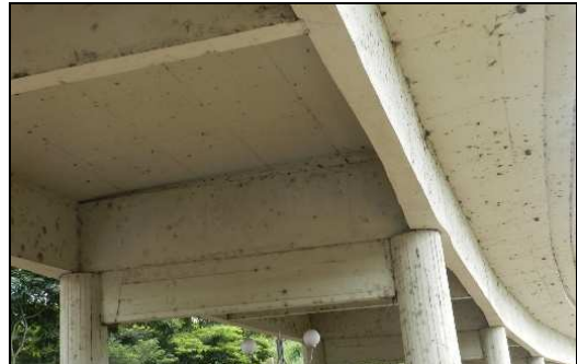
(d) Elementos do tabuleiro na parte central do viaduto em bom estado. Manchas e sujeira aderida a superfície das tranversinas e pilares e na face inferior do balanço.
