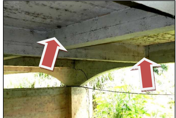
(b) Manchas brancas em diversos pontos nos elementos da parte inferior do tabuleiro
