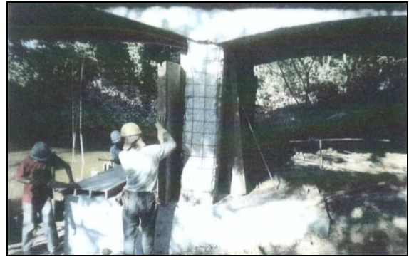
(b) Colocação da armadura e da forma do pilar
