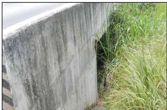
(c) Boas condições do encontro do vão adicional.
