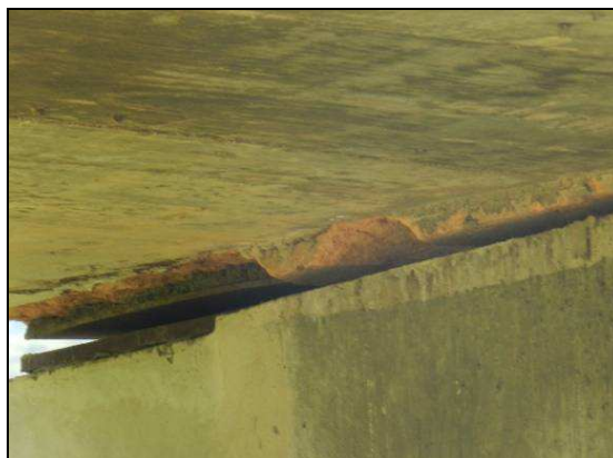
(j) Detalhe do aparelho de apoio do pilar P2.
