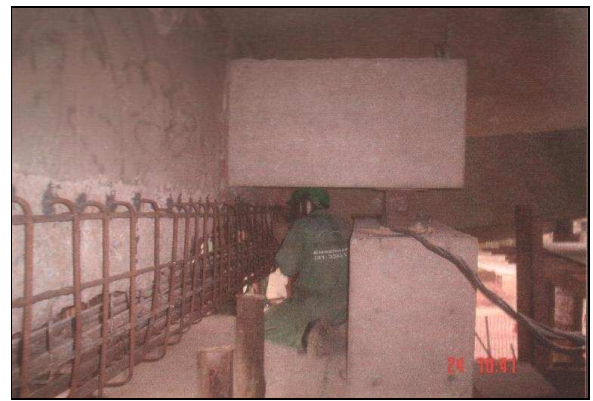
(b) – Vista do sistema de elevação do vão e da região com aumento de seção da longarina à direita no extremo Belo Horizonte. (sentido Governador Valadares – Belo Horizonte)
