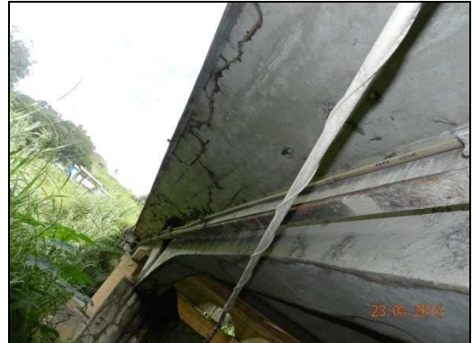
(h) Vista da face inferior da laje em balanço
