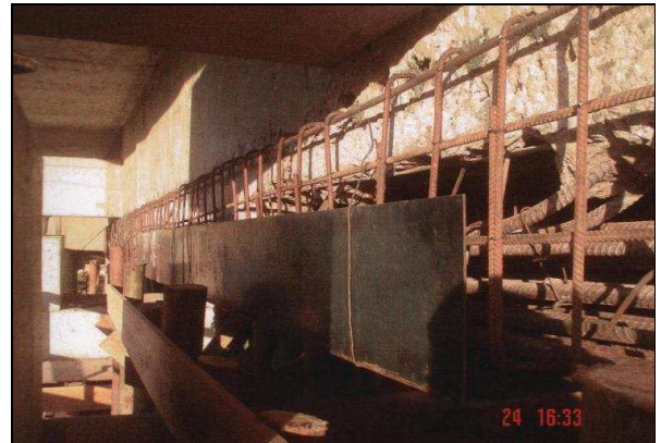
(d) – Vista da armadura do aumento de seção da longarina. (sentido Governador Valadares – Belo Horizonte)
