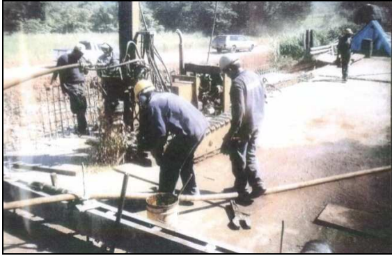
(a) Execução de estaca raiz
