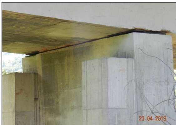
(i) Vista da região dos aparelhos de apoio do pilar P2.
