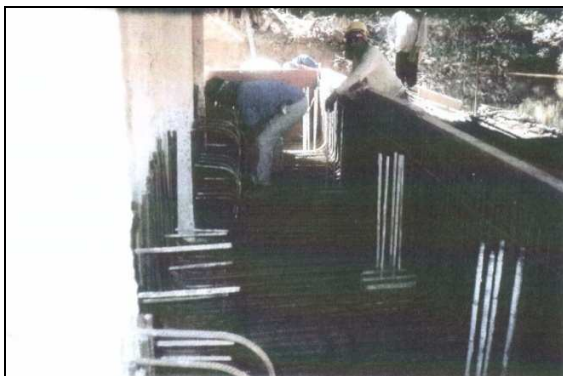
(e) Chumbadores dos pilares e armação de ancoragem das estacas
