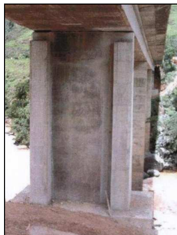
Figura 4.49 – Vista do pilar P2 após o reforço
