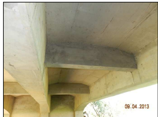
(b) Vista inferior do tabuleiro – boas condições dos elementos.
