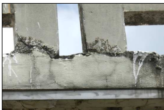
(e) Detalhe do encontro do guarda-corpo com a laje do tabuleiro.
