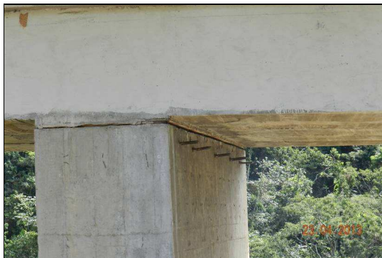
(k) Vista da região dos aparelhos de apoio do pilar P3.
