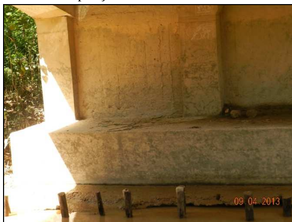
(d) Bom estado dos blocos de concreto
