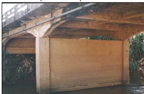
(d) - Visão lateral da ponte.
