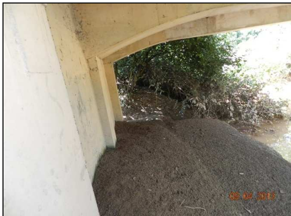
(a) Pilares em bom estado com bloco totalmente coberto por material transportado pelo Córrego
