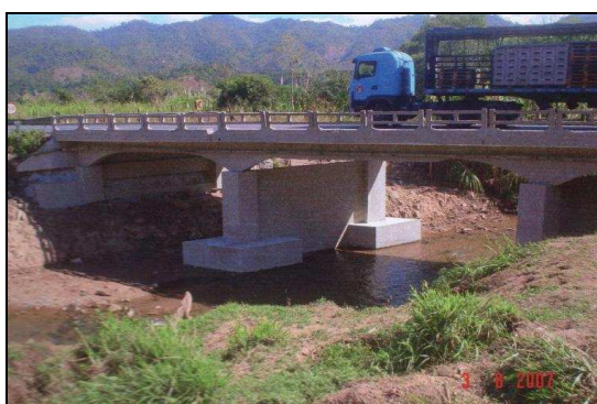
(a) Vista lateral da obra após os serviços de reforço
