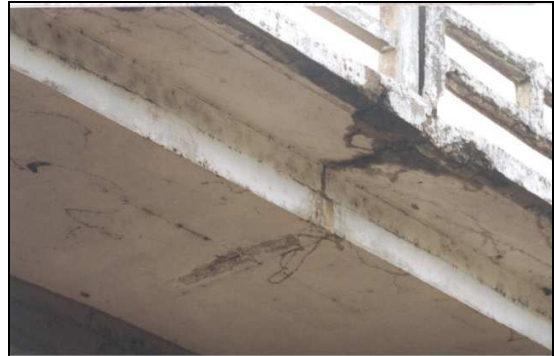
(f) – Ponto de escoamento das águas provenientes do tabuleiro.
