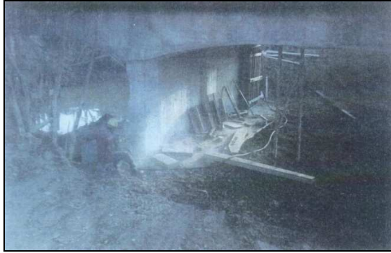
(a) Apicoamento do pilar
