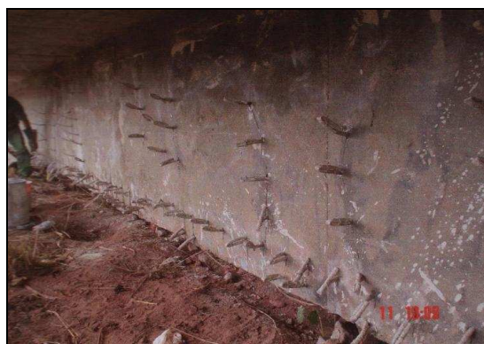
Figura 4.69 – Detalhe dos bicos de injeção da resina epóxi
