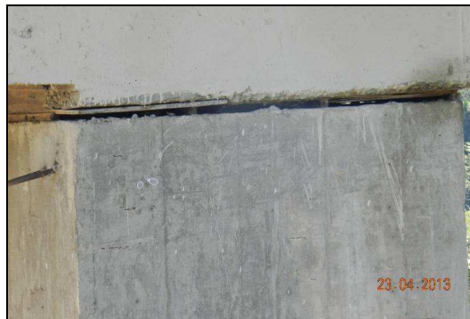
(l) Vista da região dos aparelhos de apoio do pilar P4.
