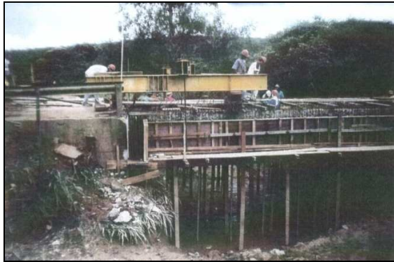
(e) Vista do reforço das longarinas
