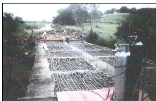
(b) Lajes demolidas com as armações existentes preservadas.
