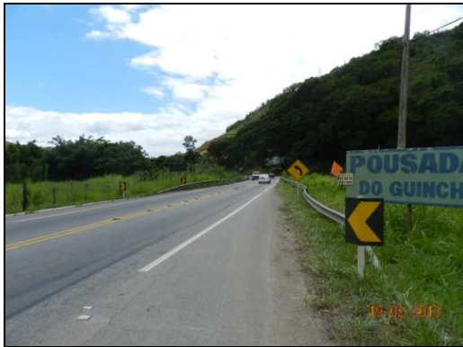
(g) Vista da proximidade da ponte lado Belo Horizonte
