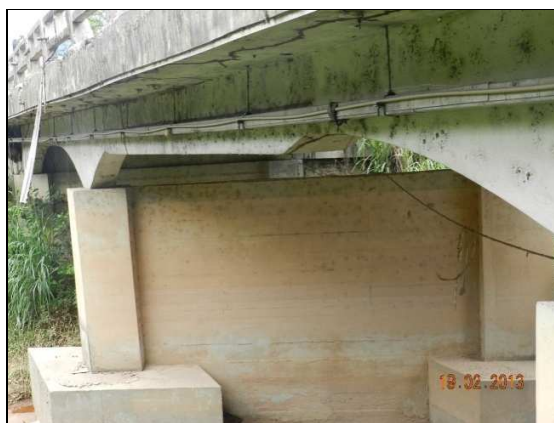
(a) Vista do pilar central em boas condições
