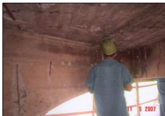
(b) Vista das armaduras sendo tratadas com aplicação de primer anticorrosivo
