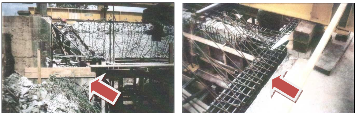
(a) Detalhe da recuperação do encontro.
