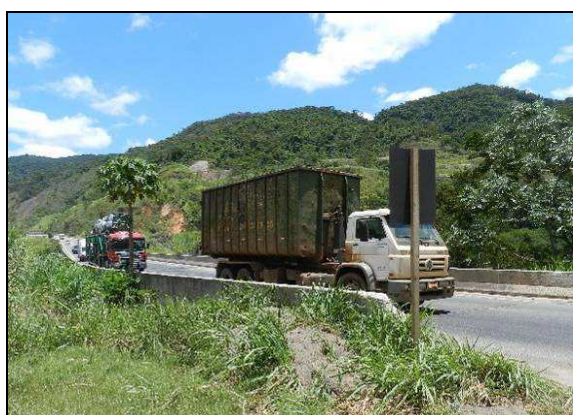
(a) Vista lateral da ponte Lado Belo Horizonte
