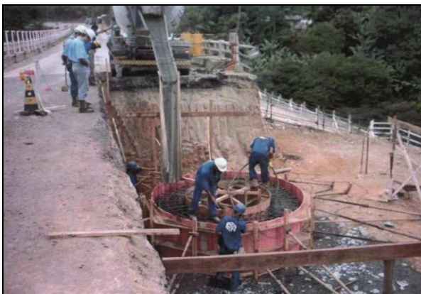
(a) Execução dos blocos
