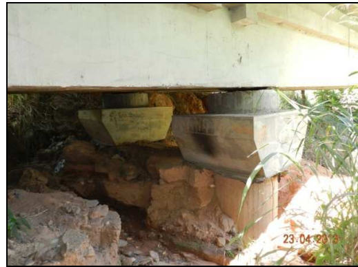
(j) Bom estado dos pilares P5 e P6
