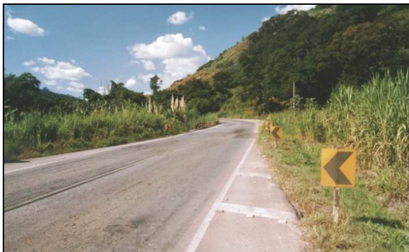
(a) - Vista geral da chegada na ponte.
