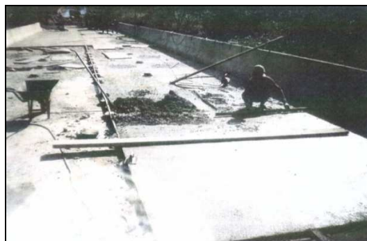
(b) Concretagem da sobre-laje
