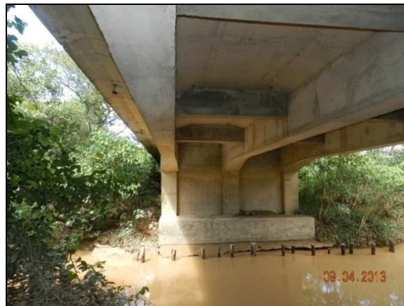
(b) Nível da água do Córrego abaixo do nível do bloco. Exposição do sistema de estacas.
