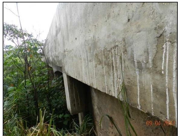
(f) Vista lateral do encontro do lado de Belo Horizonte.
