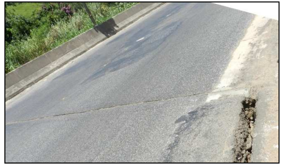
(d) Vista da junta de dilatação Lado Governador Valadares
