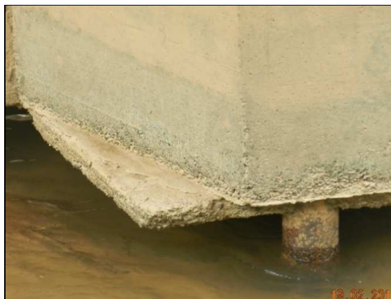
(c) Vista do sistema de fundação de reforço
