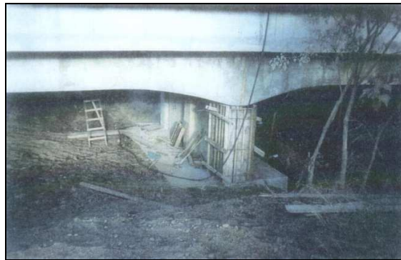
(c) Forma do pilar preparada para a concretagem
