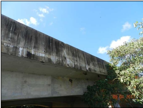
(e) Vista lateral da ponte
