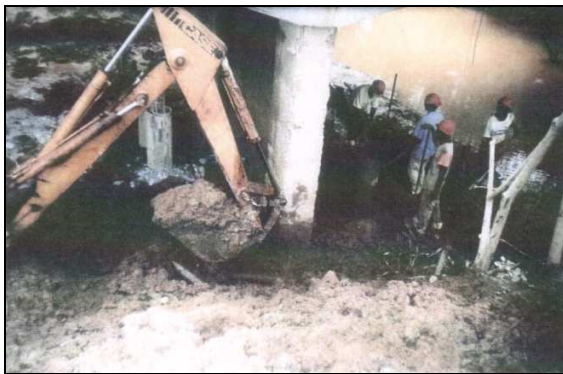
(c) Escavação do bloco
