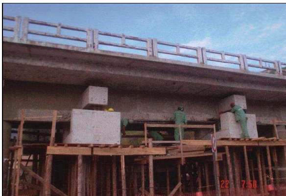
(a) – Vista lateral do sistema de elevação do vão. Longarina à direita extremo Belo Horizonte. (sentido Governador Valadares – Belo Horizonte)
