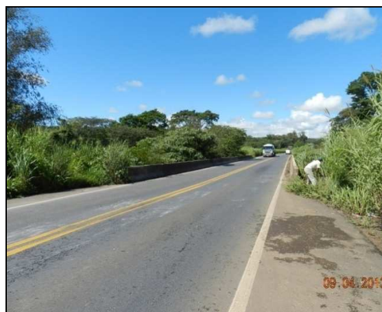
(b) Vista geral da ponte – lado de Curvelo
