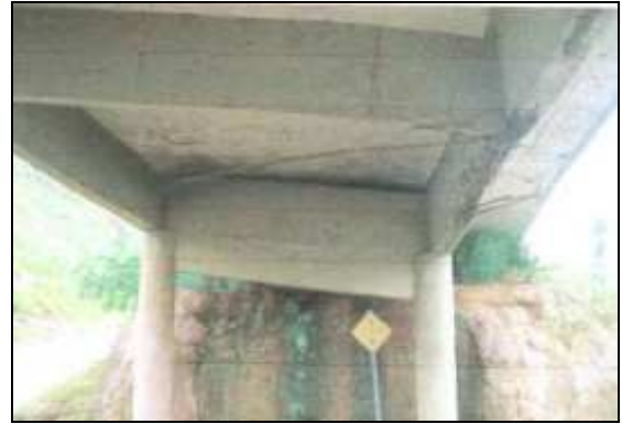
(f) – Visão inferior do tabuleiro no trecho da longarina. Longarina à direita. Extremo Belo Horizonte. (sentido Governador Valadares – Belo Horizonte)
