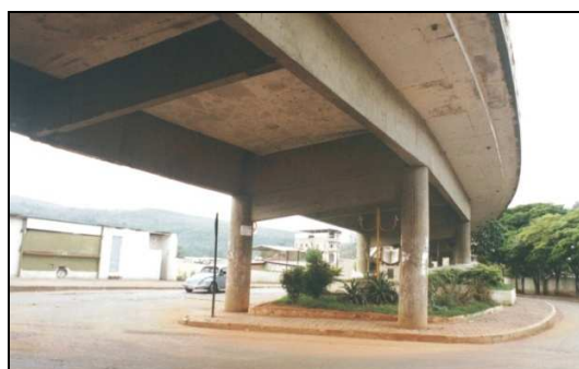
(b) – Vista lateral do viaduto.
