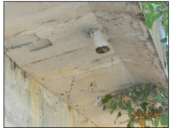
(f) Vista inferior da laje do balanço
