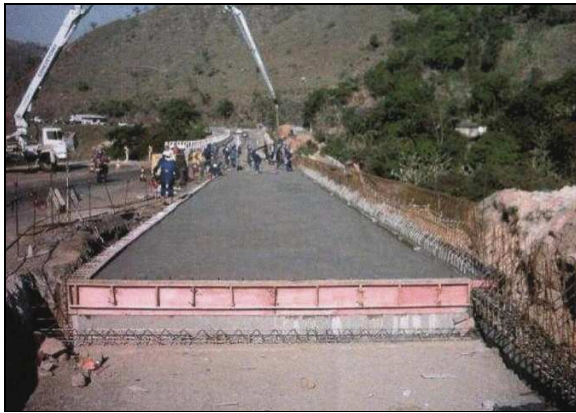
(e) Concretagem de meia pista e armação da barreira New Jersey
