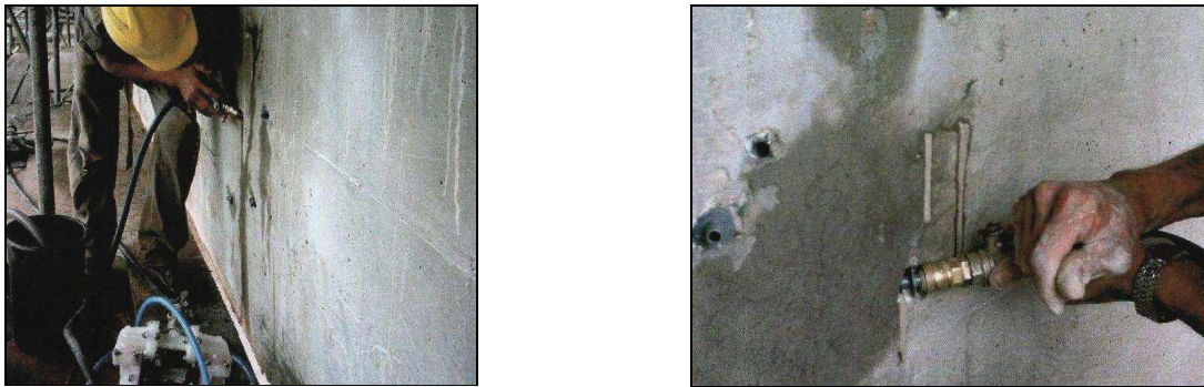
Figura 4.56 – Injeção de resina epoxídica tixotrópica para tratamento de fissuras existentes no pilar P2
