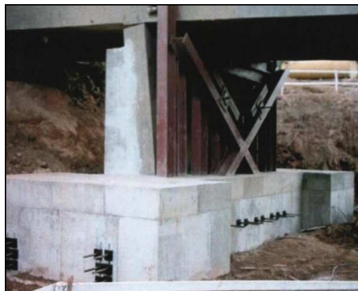
Figura 4.47 – Pilar P1 e o novo bloco de fundação
