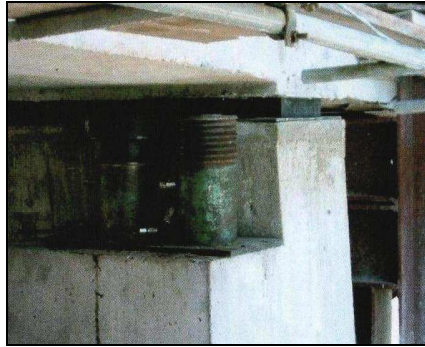
Figura 4.54 – Procedimento de troca dos aparelhos de apoio para o pilar P2
