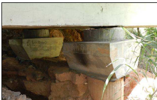
(o) Vista da região dos aparelhos de apoio dos pilares P6 e P7.
