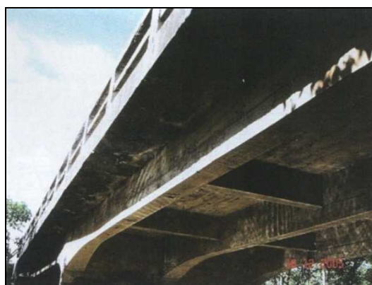
(b) Vista lateral e inferior da ponte
