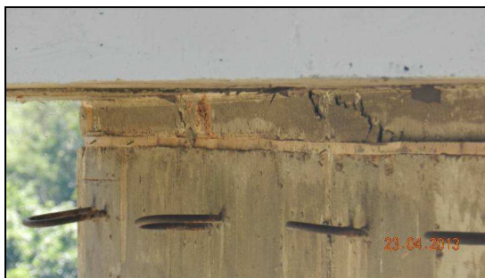
(m) Detalhe da região do aparelho de apoio do pilar P4.
