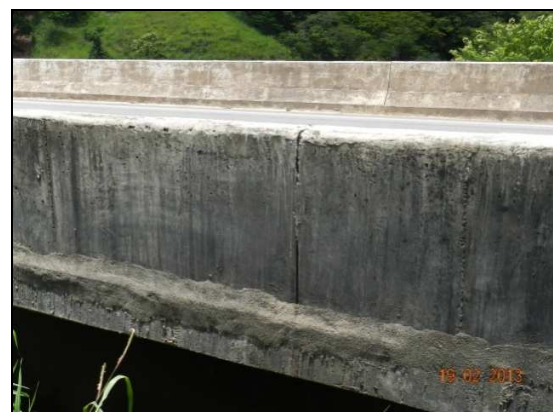
(h) Vista lateral do vão adicional da obra do reforço. Lado Belo Horizonte
