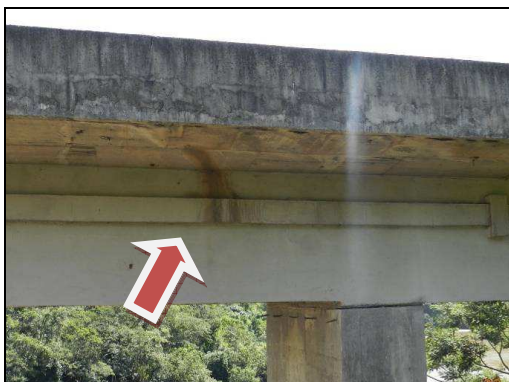
(f) Marcas de escoamento d'água na saída do dreno da laje em balanço atingindo a face lateral da viga caixão
