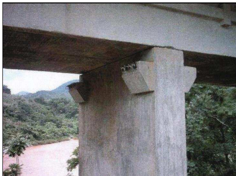
Figura 4.52 – Detalhes dos consoles nos pilares P5, P6 e P7 para instalação de macacos hidráulicos para troca dos aparelhos de apoio
