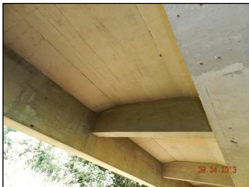
(a) Vista inferior do tabuleiro – boas condições dos elementos.
