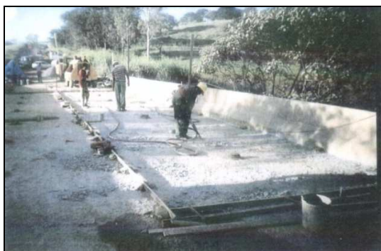
(a) Preparo da laje para execução de sobre-laje em concreto com a barreira New Jersey executada
