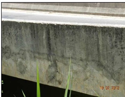
(g) Vista lateral da ponte mostrando o encontro da estrutura antiga com a estrutura da barreira instalada na obra de reforço. Lado Governador Valadares
