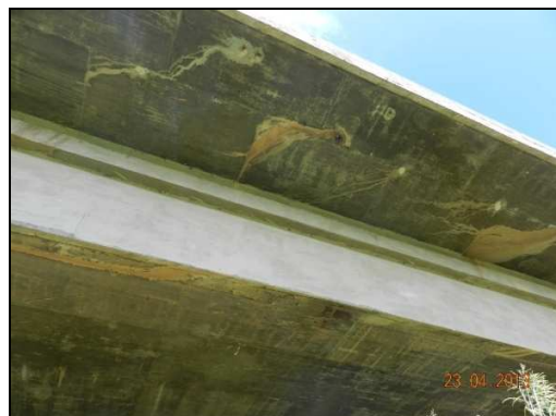
(h) Marcas de escoamento a partir dos drenos localizados na parte inferior do balanço
