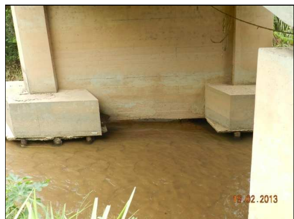
(b) Vista dos blocos e das estacas do reforço da ponte
