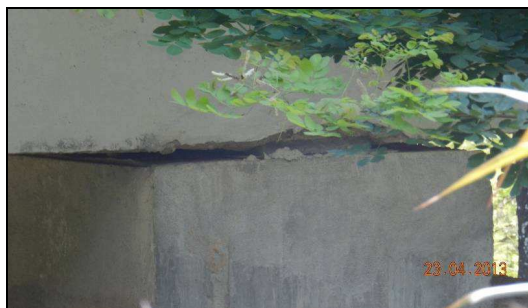
(n) Vista da região dos aparelhos de apoio do pilar P5.
