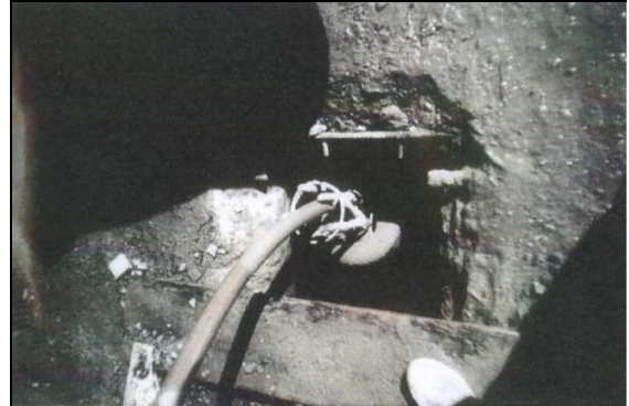
(b) Injeção de argamassa na estaca raiz
