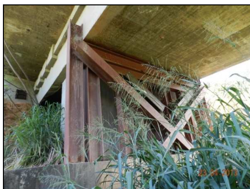
(a) Pilar P1 e estrutura do reforço em bom estado
