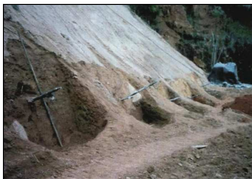
(a) Preparação da base da encosta para recebimento das placas pré-moldadas de concreto
