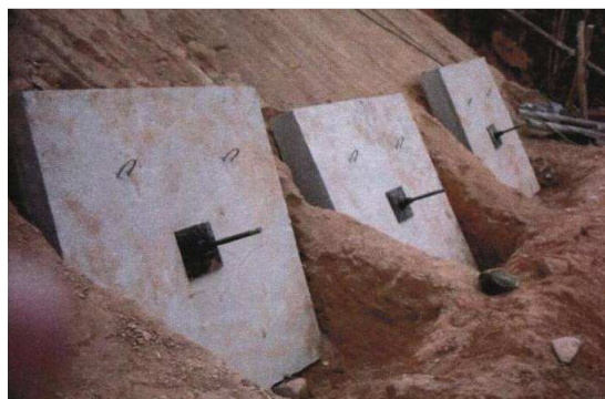
(b) Placas pré-moldadas de concreto com tirantes.
