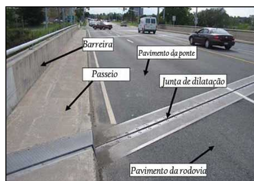
(c) Vista da pista sobre a ponte e identificação dos elementos.
