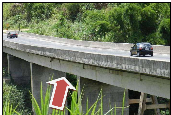
(b) Aspecto final com a caixa envoltória de concreto
