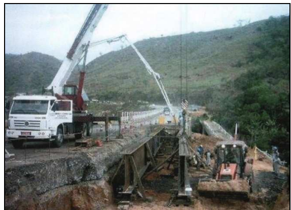
(b) Instalação das longarinas metálicas
