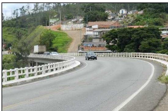
(a) Vista geral do viaduto. Lado Belo Horizonte
