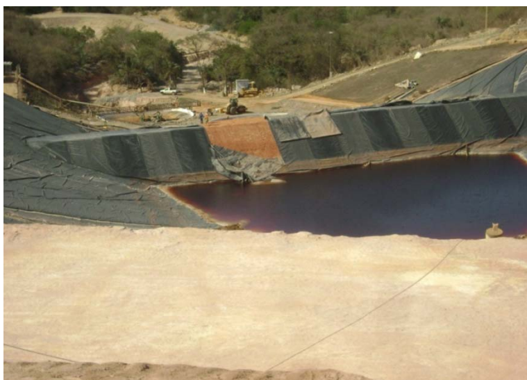
FIGURA 3.4 – Vista da área de jusante e dique de contenção.
