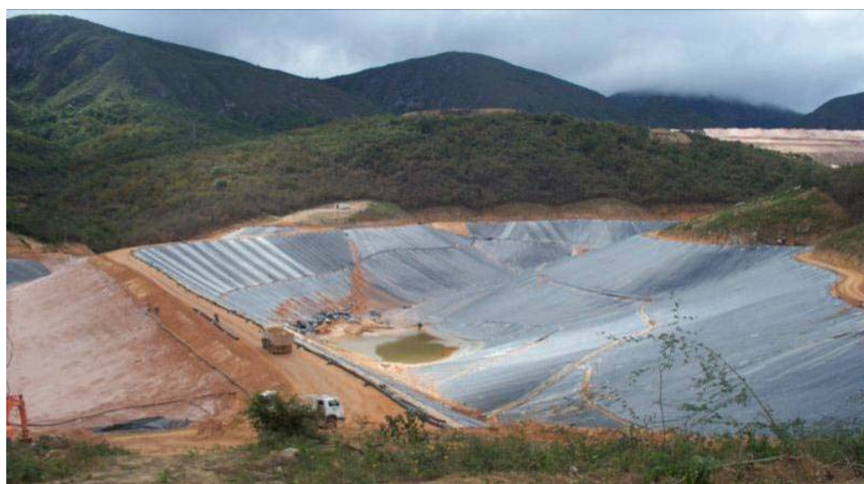
FIGURA 3.3 – Vista geral da barragem de Jacobina 1ª etapa (DAM, 2010).
