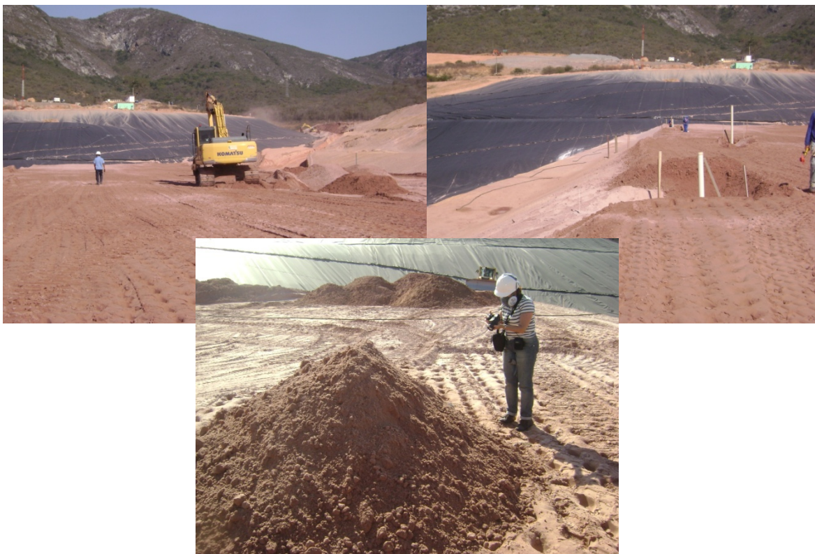
FIGURA 4.2 – Amostragem do underflow .
