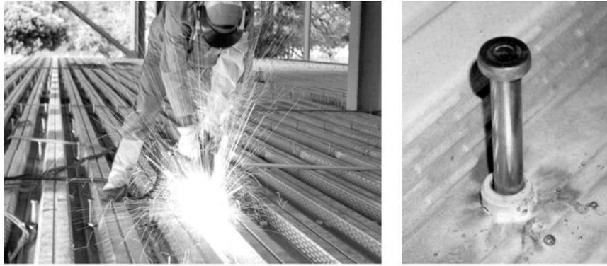
FIGURA 2.13 – Aplicação de conectores *stud bolts* sobre *deck* metálico (CRUZ *et al.*, 2006).
