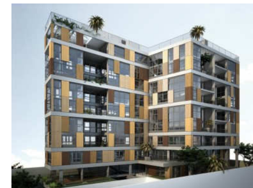
FIGURA 23 - Edifício Fidalga 772. Incorporadora Idea!Zarvos. São Paulo. FONTE: < http://www.idealzarvos.com.br >. Acesso: maio2014.
