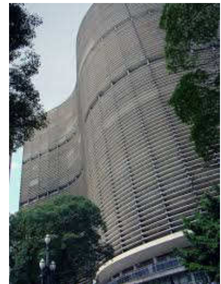
FIGURA 18 - Edifício Copan. São Paulo. FONTE: < http://pt.wikipedia.org >. Acesso: maio2014.
