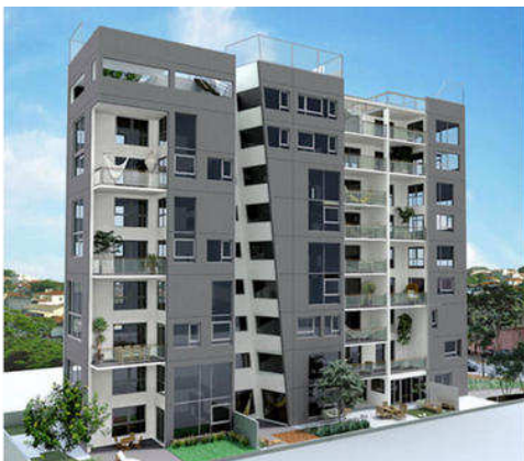
FIGURA 24 - Edifício Kimberê 1749. Incorporadora Idea!Zarvos. São Paulo. FONTE: < http://www.idealzarvos.com.br >. Acesso: maio2014.
