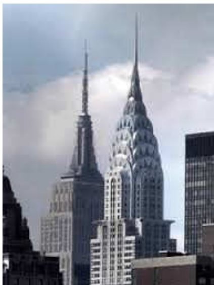
FIGURA 19 - Edifício Chrysler Building. Nova York. FONTE: < http://pt.wikipedia.org >. Acesso: maio2014.
