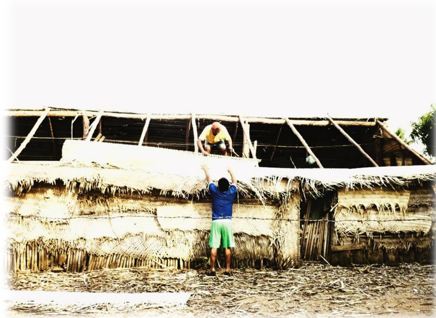
Figura 5 - Homens bororo reformando o telhado de uma casa
