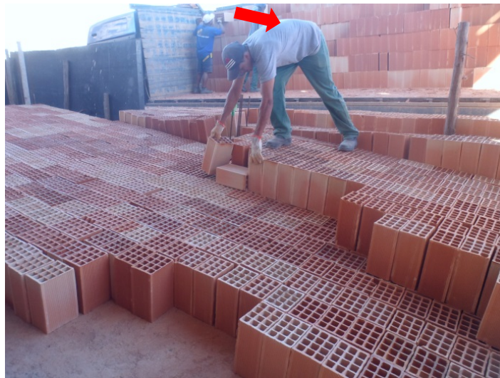
Figura 3 - Trabalhador posicionando os tijolos na pilha
