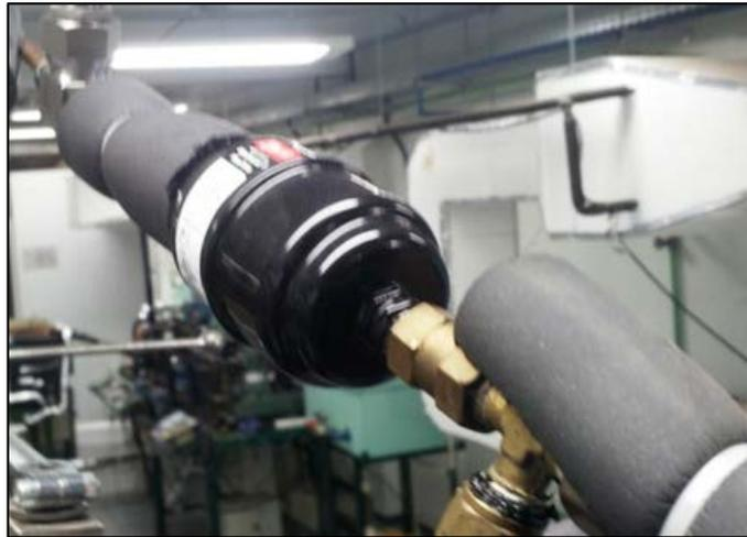
FIGURA 3.8 - Filtro secador da bomba de calor
