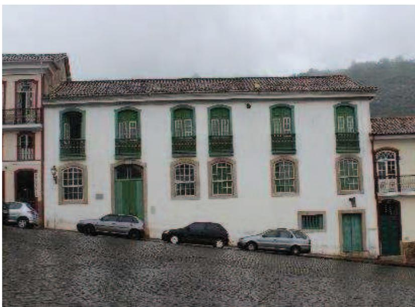
**Figura 106** – Casa de Gonzaga. A edificação, que se localiza à Rua do Ouvidor, foi restaurada entre 2004 e 2006. Nas obras foram contemplados os seguintes itens: telhados, pisos, forros, instalações elétricas e hidráulicas; prevenção e combate a incêndios; segurança; e, pintura. Fonte: Arquivos do autor, 2014.
