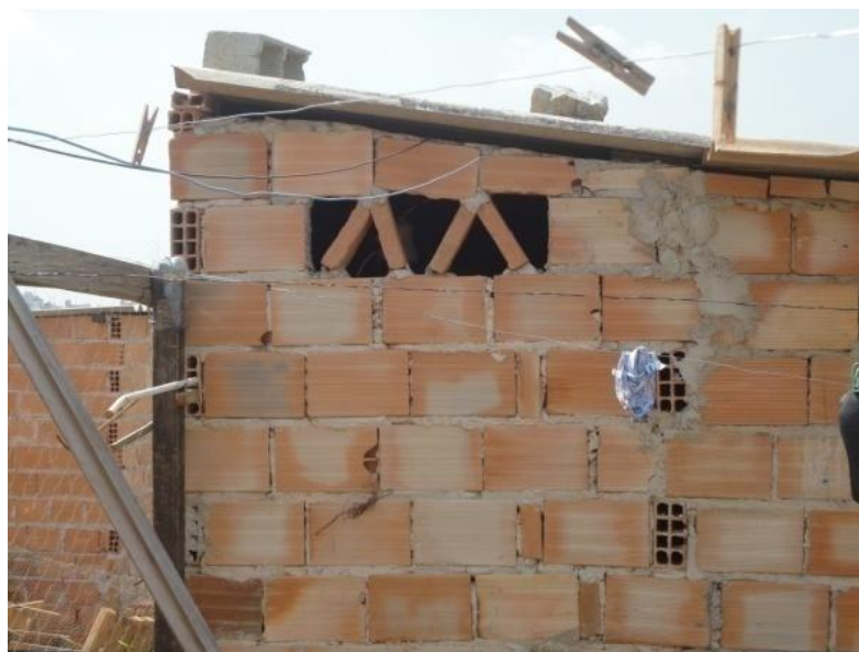
Figura 43- Ocupação Eliana silva: abertura construída com elementos de tijolo
