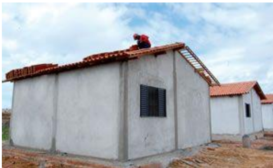
Figura 6 - Habitações construídas por meio de tecnologias "alternativas"
