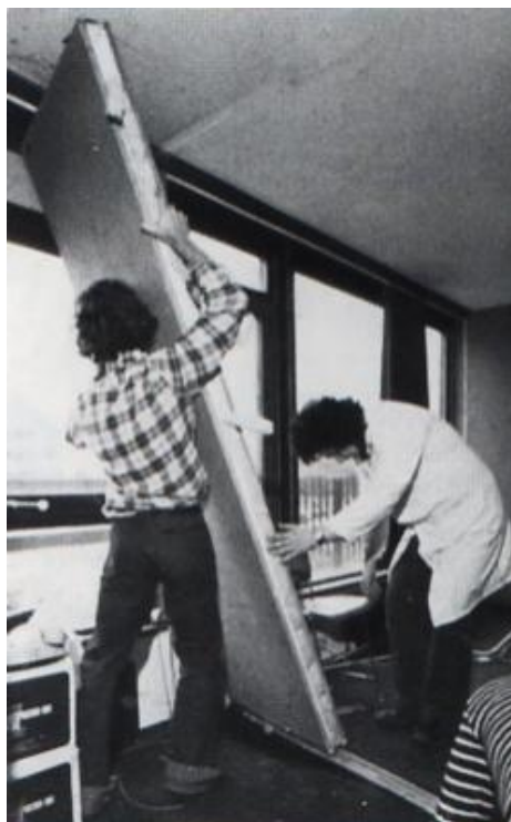
Figura 25- Lucien Kroll: Montagem dos sistemas pré-fabricados
