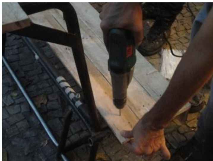
Figura 54 - Cidade Eletronika: Construção e projeto simultâneos
