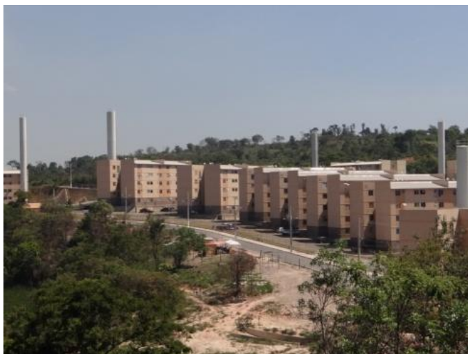
Figura 4 - Edifícios do PMCMV construídos em alvenaria estrutural
