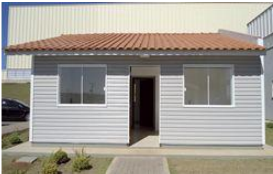
Figura 5 - Habitações construídas por meio de tecnologias “alternativas”
