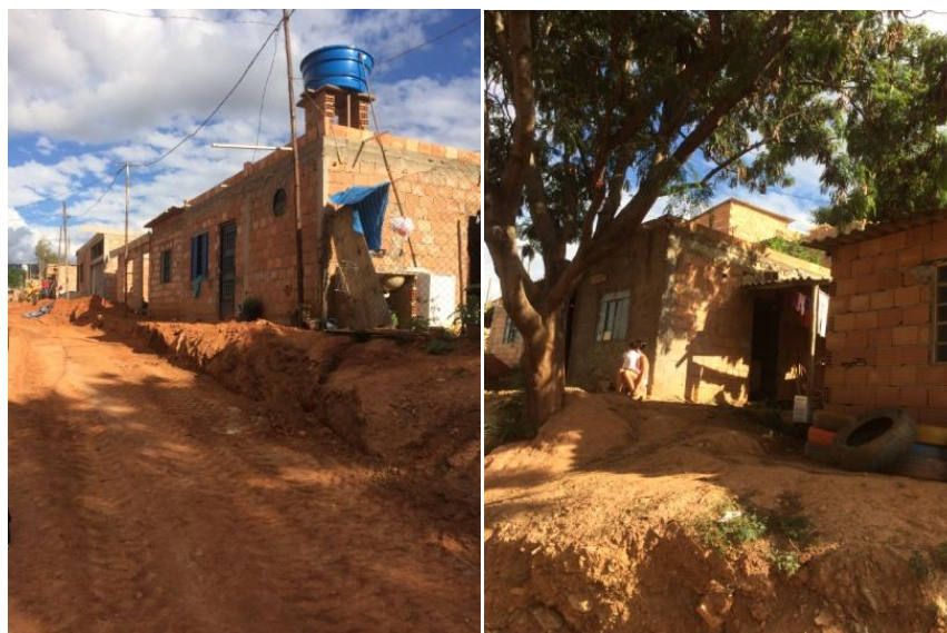
Figura 41- Ocupação Eliana Silva: Construções em alvenaria
