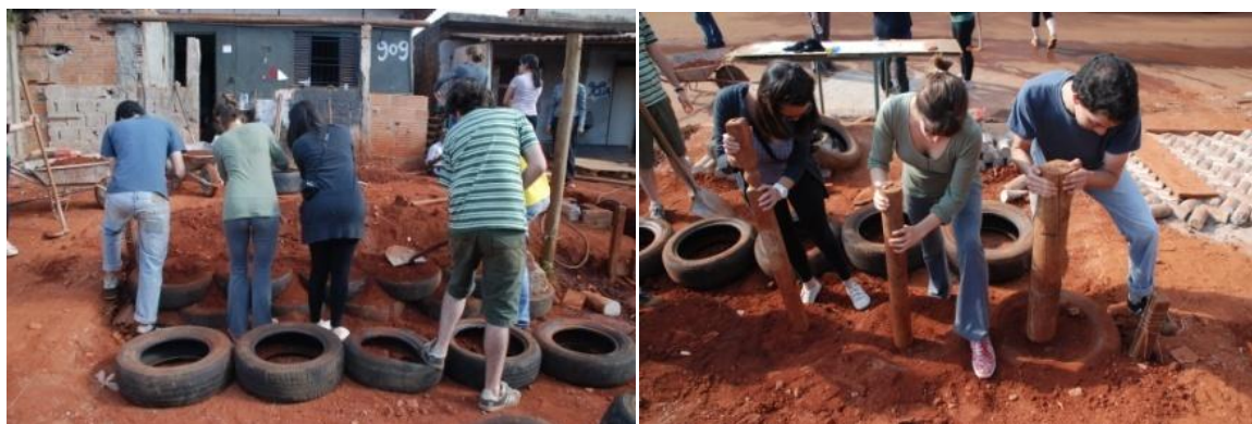
Figura 95 – Casa da Ivete: Muro de pneu
