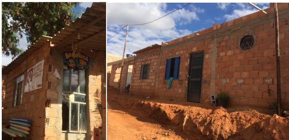
Figura 42 - Ocupação Eliana Silva: casas de alvenaria com esquadrias diversas
