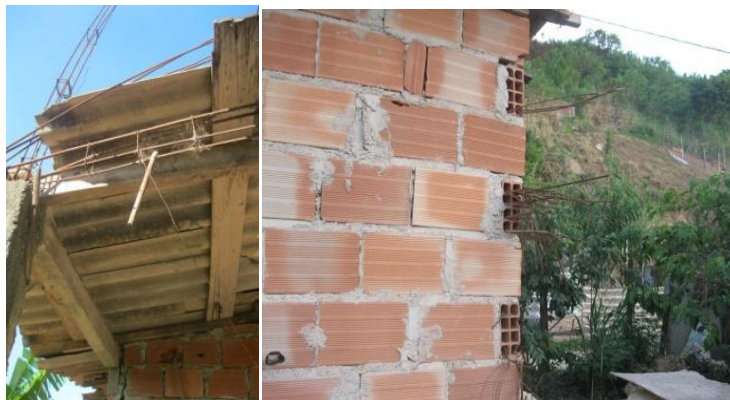
Figura 45- Tática construtiva: esperas de aço em vigas e pilares para futuras ampliações
