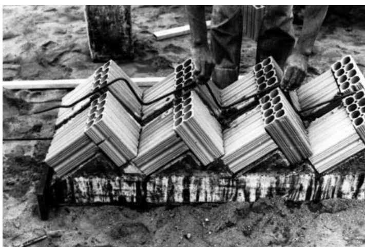
Figura 26- Laboratórios de Habitação: Painéis Cerâmicos
