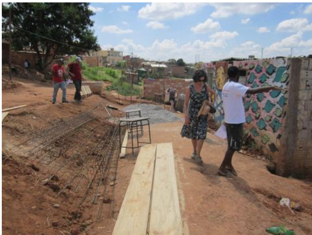
Figura 64 - Ocupação Eliana Silva: primeira visita à creche
