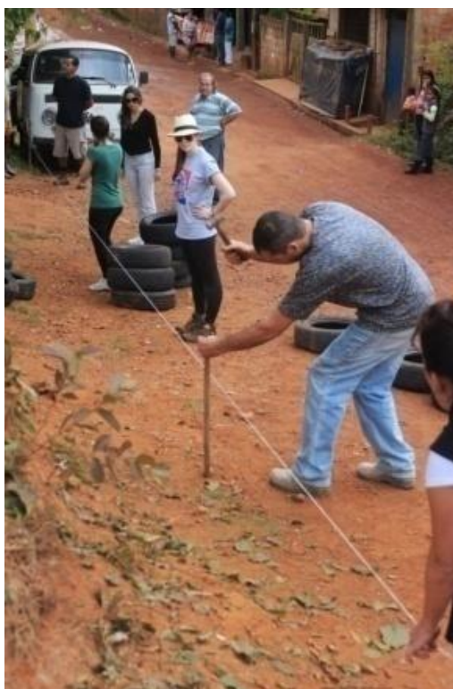
Figura 85 - Capela Velha: mutirão para a construção do muro de pneus
