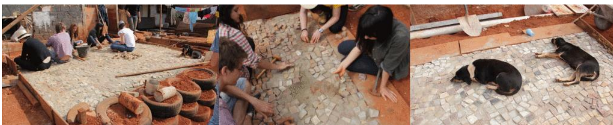
Figura 75- Casa da Ivete: Materiais usados na reforma (pedra portuguesa, corpos de prova de concreto, pallets, etc)
