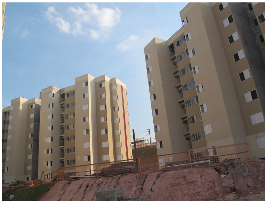
Figura 31- Conjunto habitacional construído por meio do PMCMV-entidades
