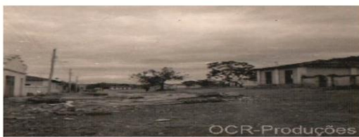
1940 - Rua Cônego Acácio- São José do Almeida
