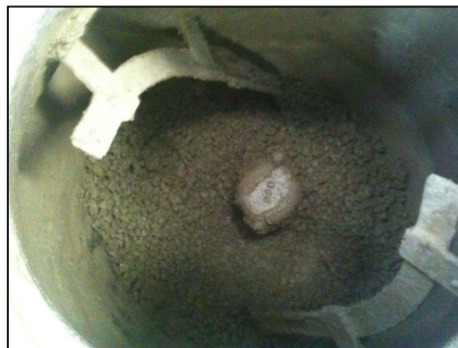
Figura 5.3 – Produção do concreto leve em betoneira.
