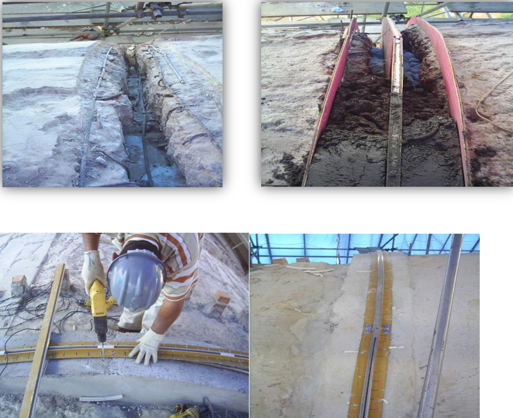
Figura 24: Abertura da junta de dilatação, preenchimento com denvergrout com 30% de pedrisco, perfil metálico, e preenchimento com neoprene.
