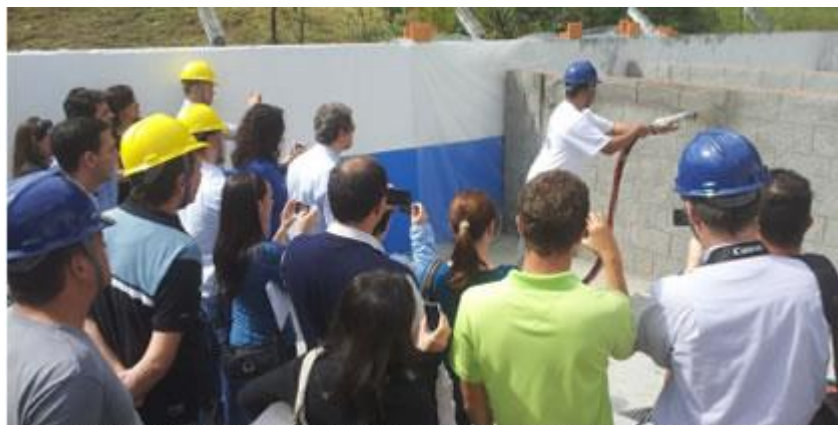
Figura 7: Argamassa Projetada Fonte: site ABCP - http://www.abcp.org.br/conteudo/imprensa/polo-de-sorocaba-trabalha-revestimento-de-argamassa#.U5DsXyO5fIU
