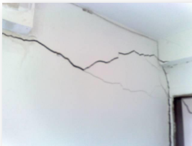
Figura 56: Foto área administrativa da edificação.
