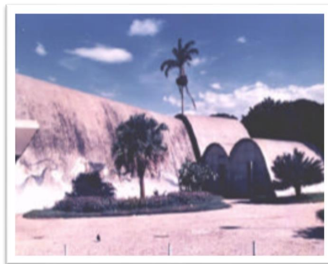
Figura 13: Situação da igreja São Francisco de Assis antes da reforma de 1990. Fonte: artigo: “Monitoramento e Avaliação Estrutural da igreja da Pampulha - Como Resolver um problema de 50 anos”
