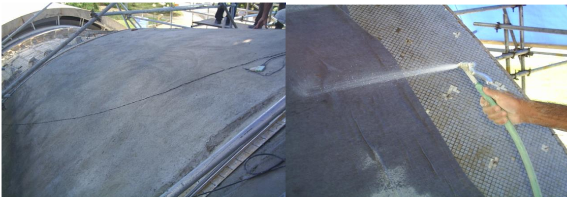
Figura 25: Fixação de tela soldada, limpeza do substrato, caldeamento do substrato, aplicação do micro-concreto.
