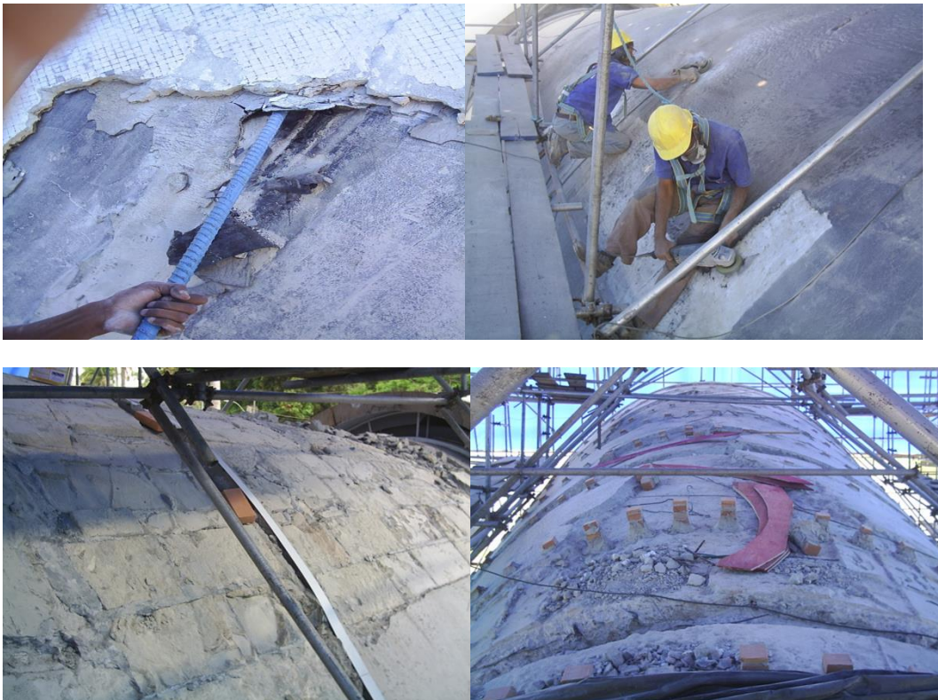
Figura 23:Imagens da Remoção do revestimento existente.
