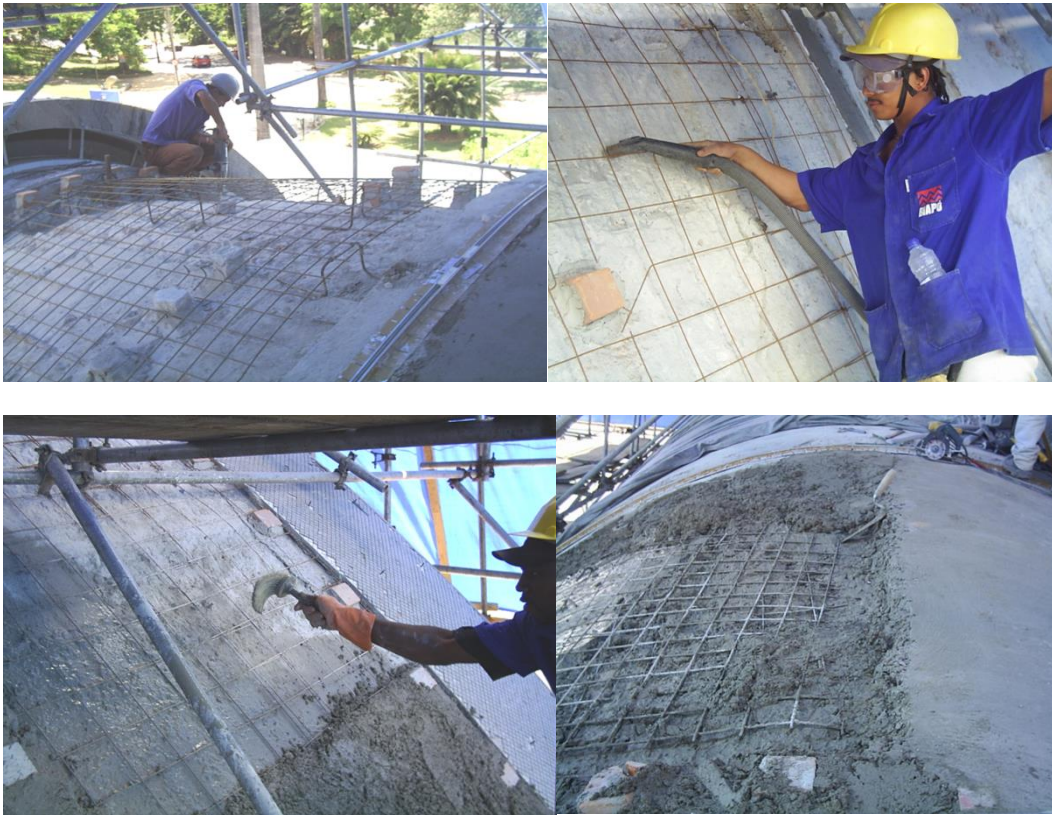
Figura 25: Fixação de tela soldada, limpeza do substrato, caldeamento do substrato, aplicação do micro-concreto.
