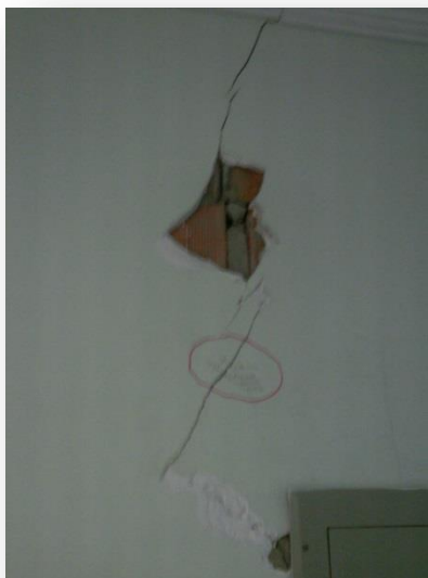
Figura 65: Revestimento de gesso com fissuras.
