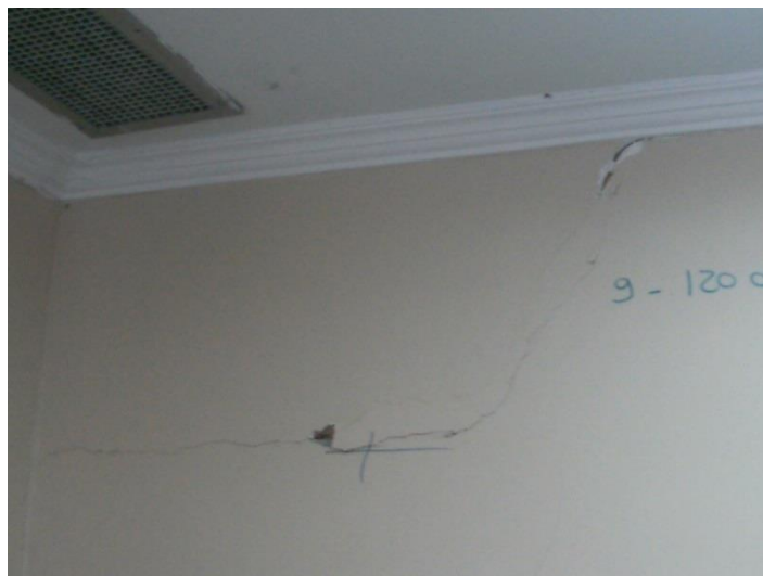
Figura 65: Revestimento de gesso com fissuras.
