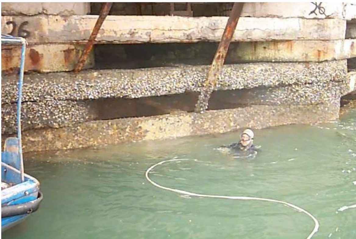
Figura 4-6 – Inspeções subaquáticas. (Fonte: Aguiar, 2014).
