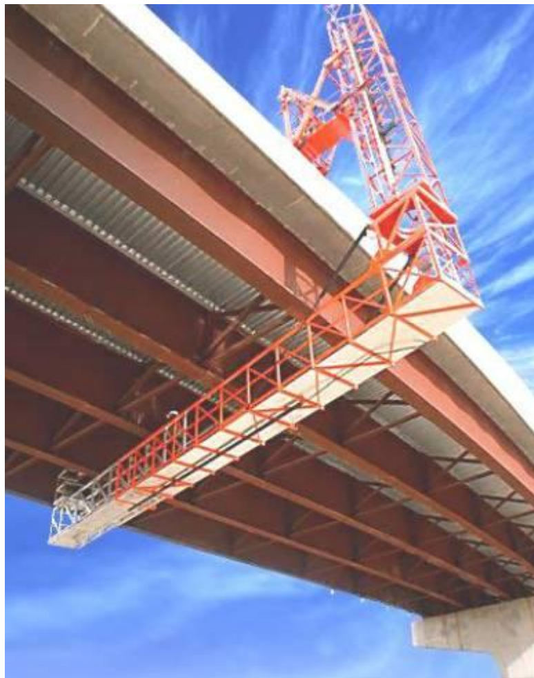
Figura 4-3 – Plataformas de inspeção em pontes. (Fonte: Aguiar, 2014).
