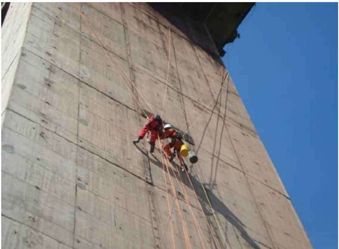
Figura 4-5 – Inspeção por profissionais em altura. (Fonte: Aguiar, 2014).
