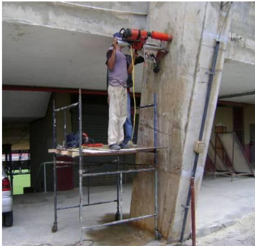
Figura 4-8 – Extração de corpos de prova de estruturas. (Fonte: Aguiar, 2014).
