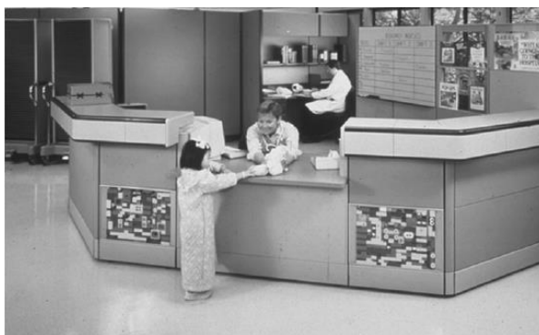
Figura 3.7: Trecho rebaixado no balcão permite o atendimento a pessoas de baixa estatura ou em cadeira de rodas. Fonte: Story, 2001, APUD Preiser & Ostroff, 2001.
