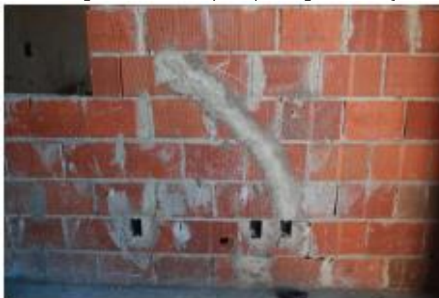
Figura 36- Rasgo na alvenaria para passagem de fiação elétrica
