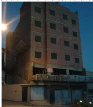
Figura 28 – Obra em alvenaria estrutural bairro Eldorado
