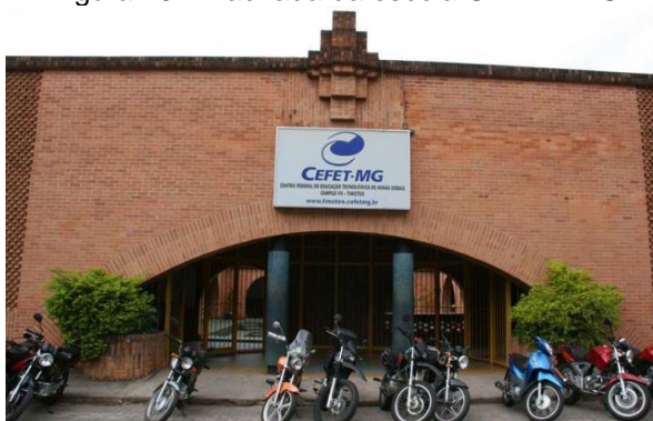
Figura 29 – Fachada da escola CEFET-MG
