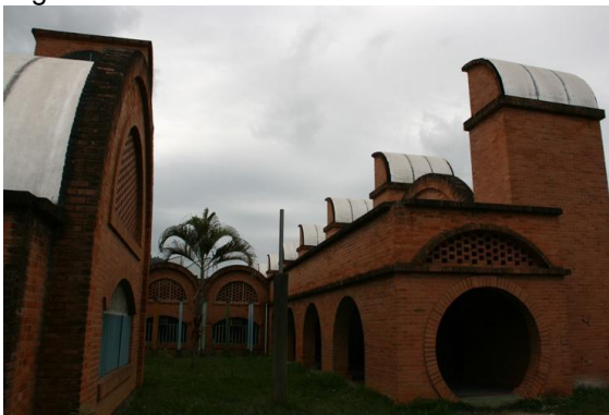
Figura 30 – Vista interna da escola CEFET-MG
