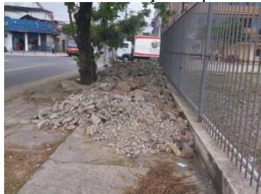
Figura 5 – Restos de obra obstruindo as calçadas públicas e gerando impacto visual
