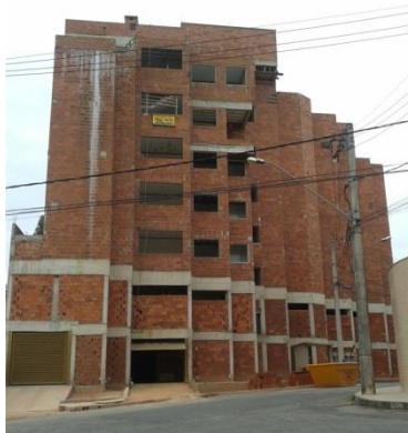
Figura 26 – Obra em alvenaria estrutural bairro Alto Serenata
