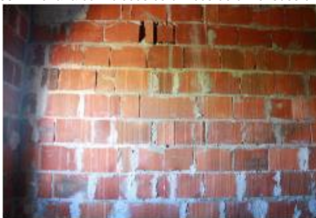
Figura 36- Rasgo na alvenaria para passagem de fiação elétrica
