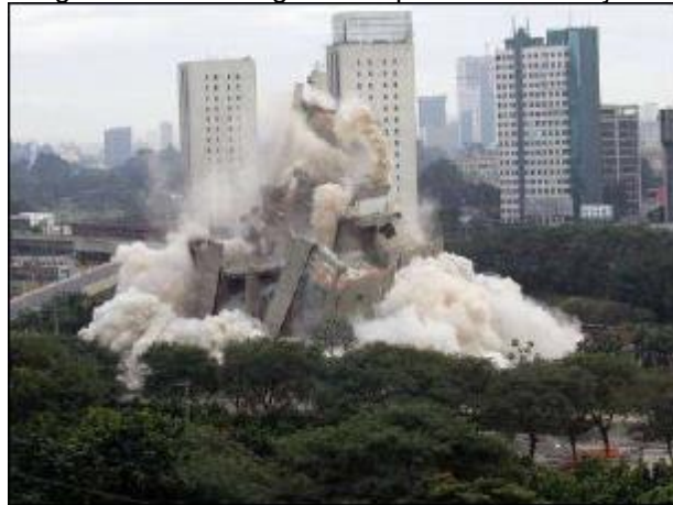
Figura 2 - Entulho gerado a partir de demolições
