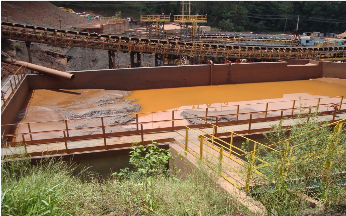
Figura 3.19: Caixa de contenção de resíduos Casa de Pedra CSN (ECM, 2012)
