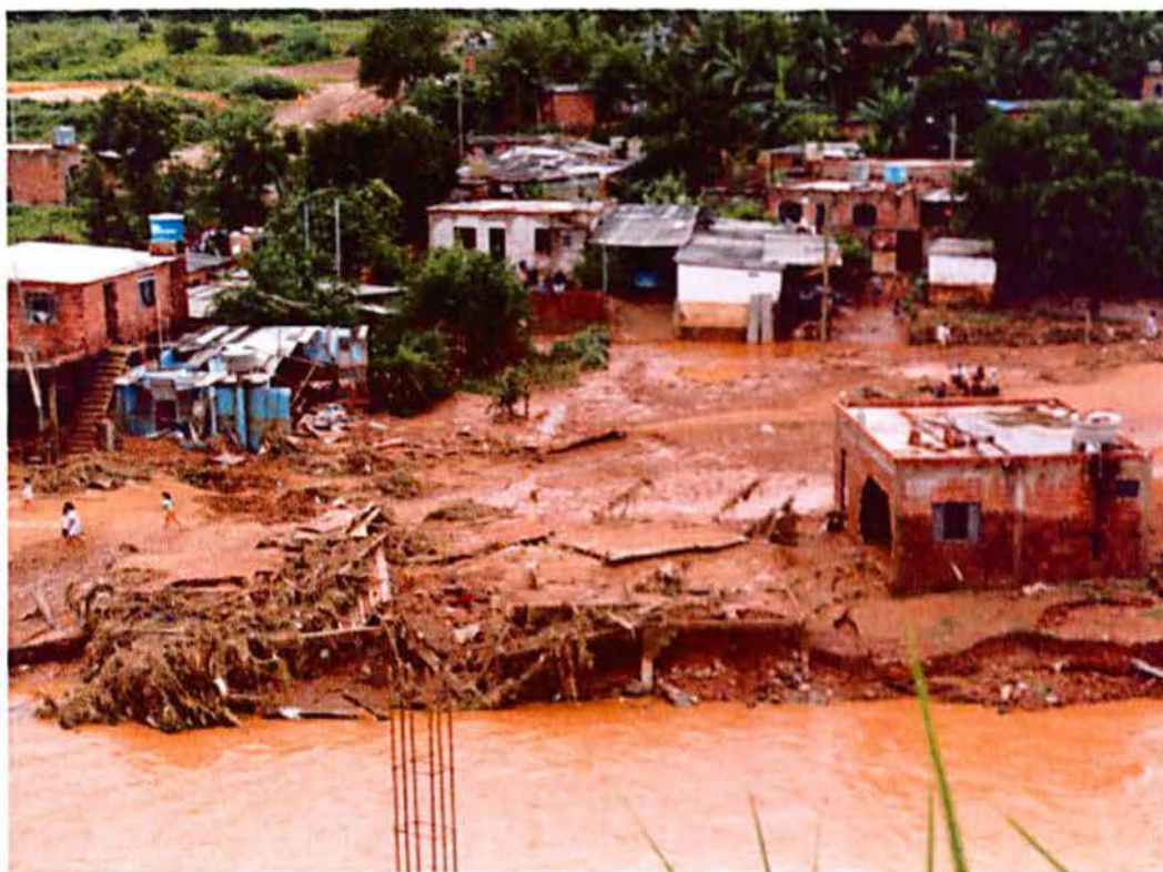
Foto 17: Destruição de moradias instaladas sobre a planície de inundação do ribeirão Ipanema, no bairro Limoeiro, pelas enchentes de fevereiro de 2000
