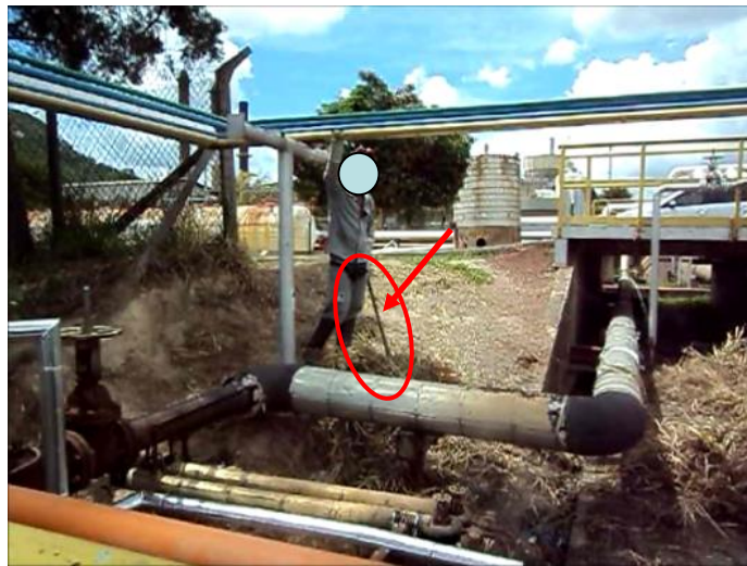
Figura 12 – Trabalhador descendo talude com o apoio da picareta
