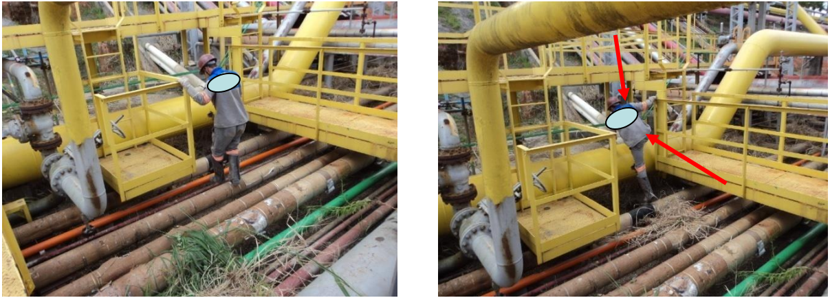
Figuras 21 e 22 – Trabalhador caminhando sobre as tubulações e escalando plataformas – os movimentos variados
