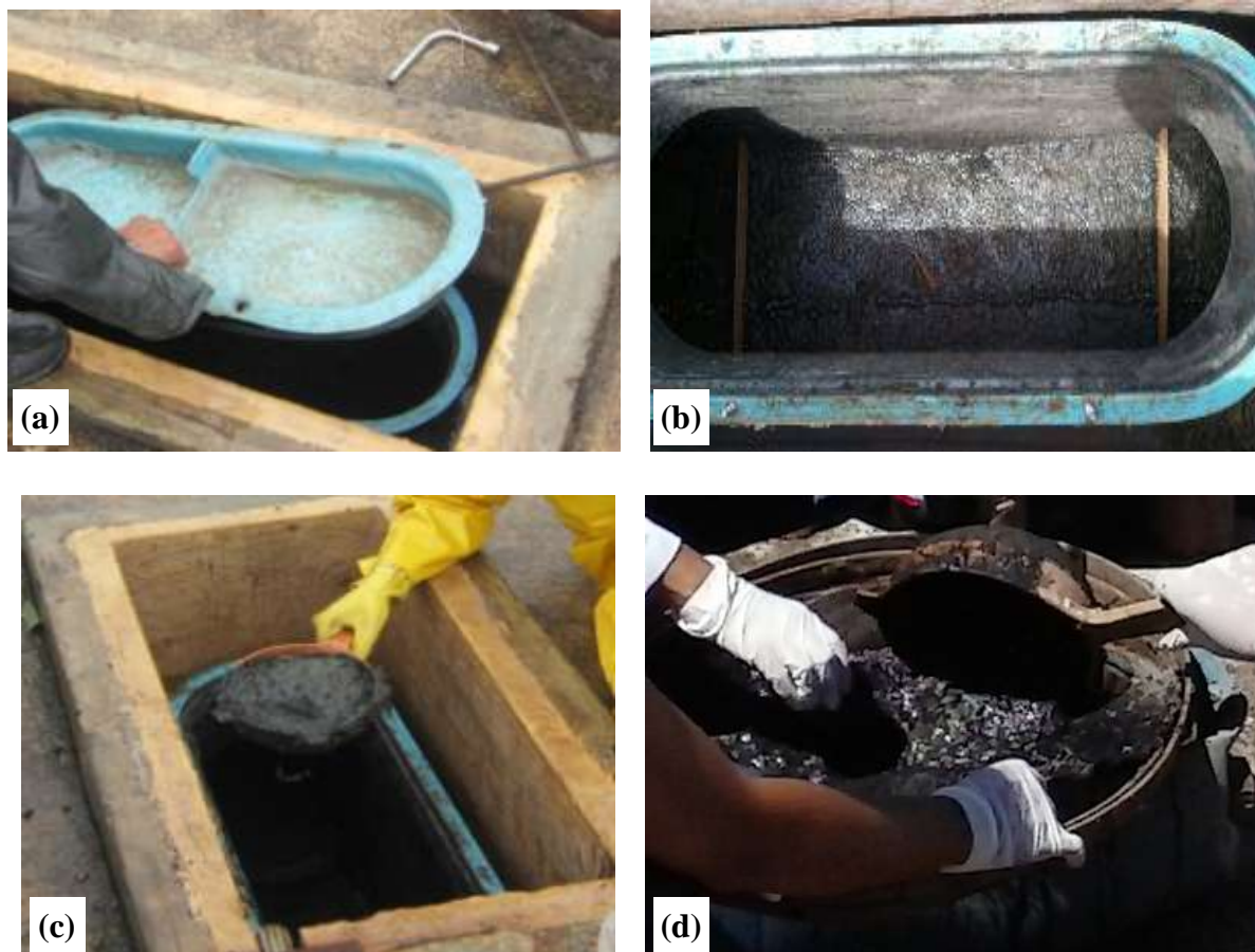
Figura 7.5: a) a abertura da escotilha; b) isolamento da área de influência da espuma abaixo da escotilha; c) remoção da espuma na área de influência e d) peneiramento da espuma coletada para redução da fração líquida da espuma
