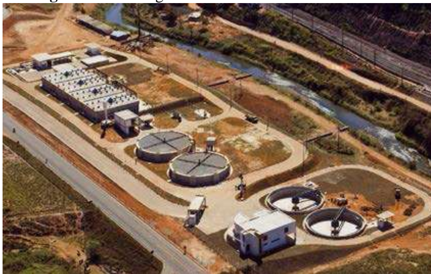
Figura 7.1: Vista geral das unidades da ETE Laboreaux
