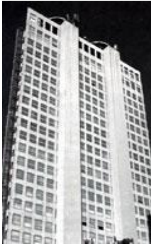
Figura 21 - Edifício-sede da Telefônica antes da reforma.
