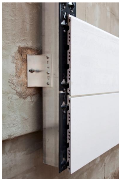
Figura 29 - Detalhe do SFV com cerâmica extrudada.
