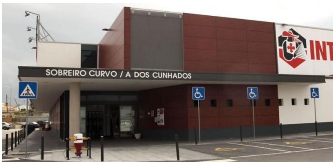
Figura 33 - Vista da fachada principal do supermercado.
