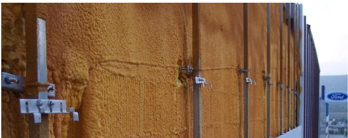
Figura 37 - Fachada ventilada montada em obra.
