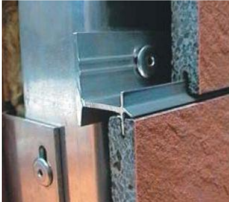
Figura 14 - Detalhe da fixação e da junta do concreto polímero.
