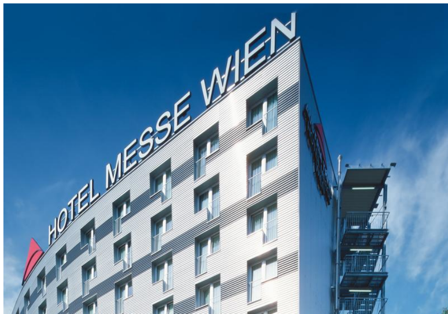
Figura 18 - Perfis de Alumínio da Fachada Ventilada.
