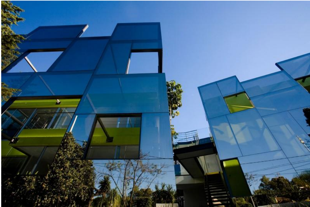
Figura 25 - Vista frontal da fachada do edifício.
