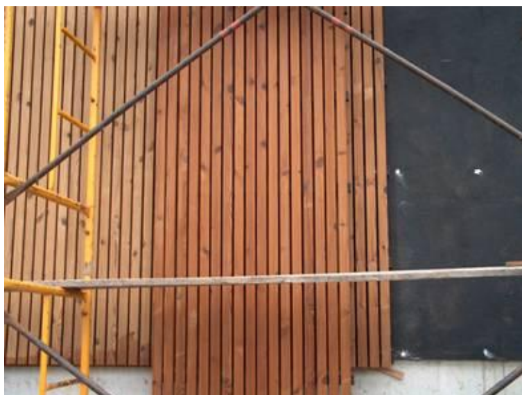
Figura 35 - Colocação de estrados de madeira modificada.
