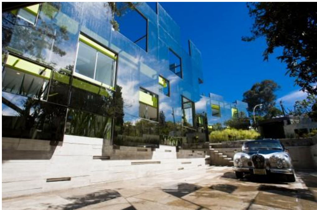
Figura 26 - Vista Posterior da fachada do edifício.
