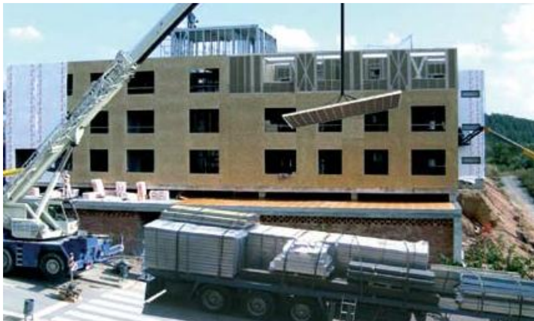
Figura 38 - Fachada ventilada pré-fabricada.
