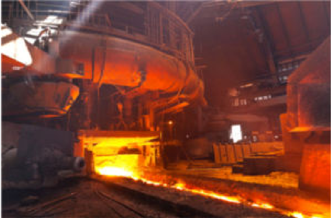
Figura 6 – Canal de Gusa em operação.
