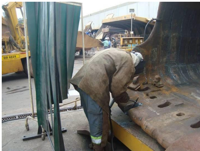
Figura 9 – Soldador realizando procedimento de escarificação.
