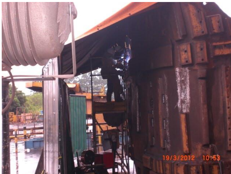
Figura 15 – Utilização de lona sob o implemento em dia de chuva.
