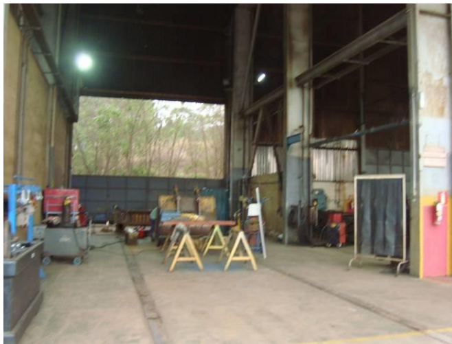
Figura 1 – Visualização geral da oficina de manutenção.
