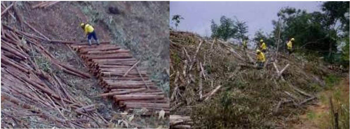
FIGURA 8: TRABALHADOR SOBRE TORAS E TERRENO SUJO
