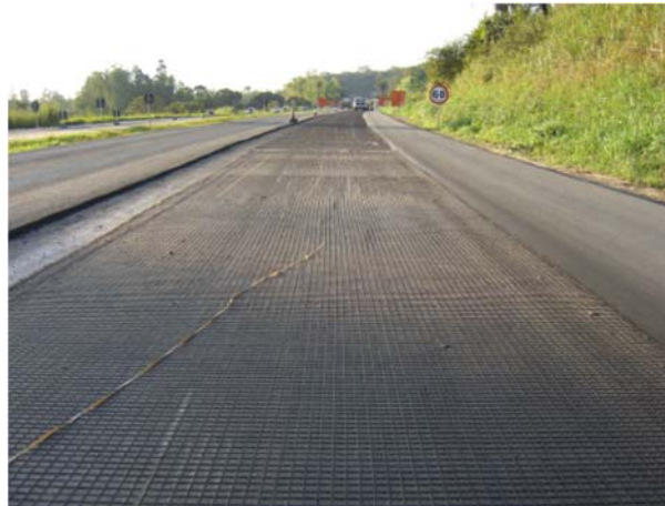
Figura 2.7 – Restauração da rodovia MG-424 (CARMO, 2014).
