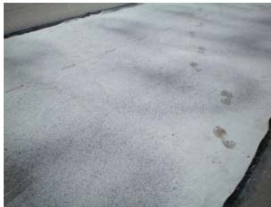
Figura 4.25 – Geotêxtil aplicado na pista, já com segundo banho de emulsão aplicado com uso de caneta (GUIMARÃES, 2013).
