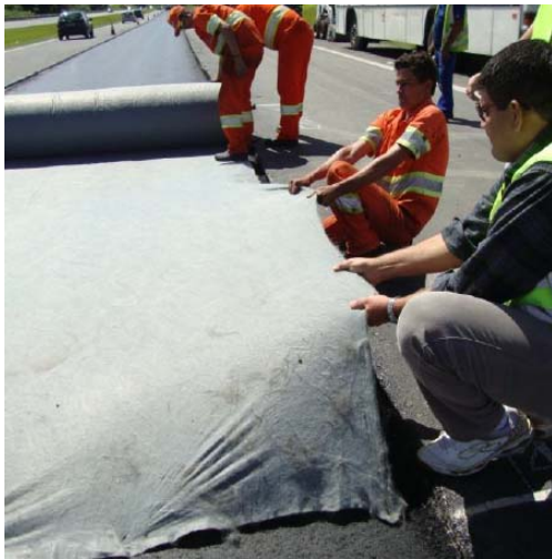
(a) colocação do material
