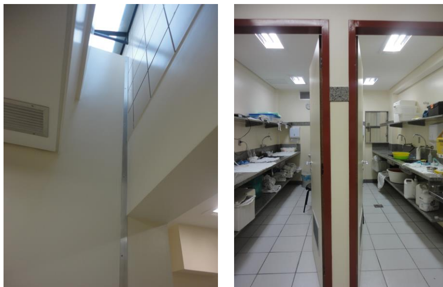
Figura 34: a) Detalhe da divisa entre a nova edificação (ampliação) e a antiga fachada existente (revestida em cerâmica) e detalhe da iluminação zenital; b) Preparo e expurgo da hemodinâmica. Fonte: fotografias da autora, em 2013.
