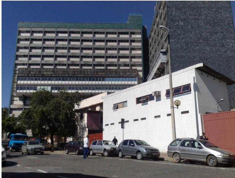
Figura 9: Alas Leste e Norte do HC/UFMG vistas da Alameda Álvaro Celso. Detalhe dos balanços nos blocos cirúrgico e obstétrico na Ala Leste e no Bloco cirúrgico na Ala Norte. Fonte: fotografia da autora, em 2011.
