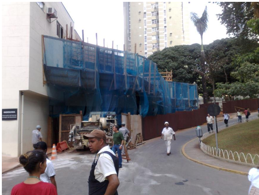
Figura 30: Expansão de área construída relativa à obra da Ressonância Magnética. Fonte: fotografia da autora, em 2011.
