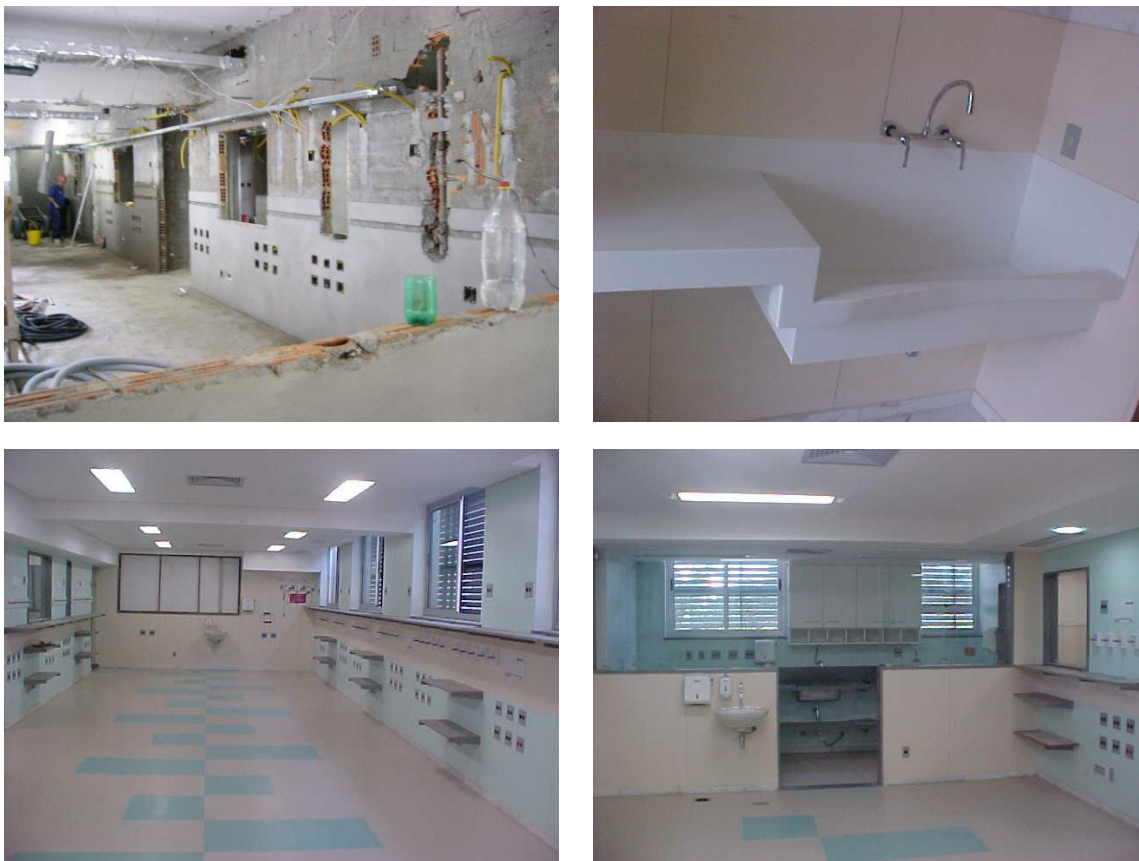
Figura 18: a) Obra da Enfermaria de médio risco em fase anterior a execução do forro; b) bancada em corium do Banco de leite, localizado no mesmo pavimento; c) Finalização da obra da enfermaria de médio risco; d) Finalização da obra da enfermaria de alto risco. Ao fundo visualiza-se o ambiente do preparo de medicamentos.
