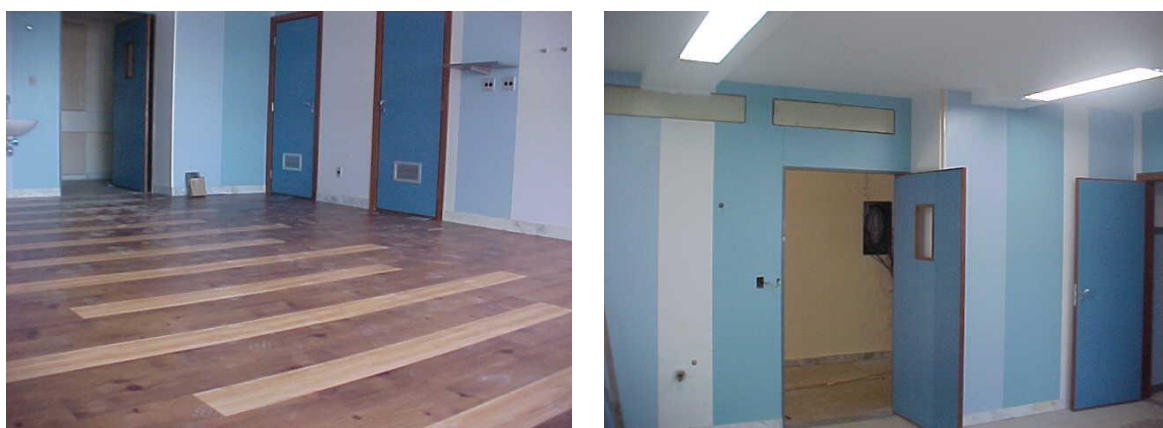
Figura 26: a) Enfermarias em fase final de acabamento com detalhe do piso vinílico; b) Enfermarias em fase final de acabamento com detalhe das portas.
