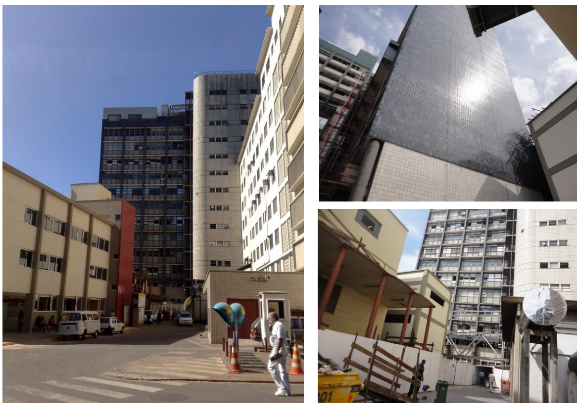
Figura 10: a) Acesso a área de Carga e Descarga do HC. Em primeiro plano, à direita o recebimento do Setor de Nutrição e Dietética (SND) e a Ala Oeste, a mais antiga. Ao fundo o Bloco B, Alas Norte e Sul; b) Bloco B, empena da fachada norte; c) À direita, área das caldeiras do hospital. Ao fundo, a obra da passarela metálica de ligação do hospital aos demais anexos.
