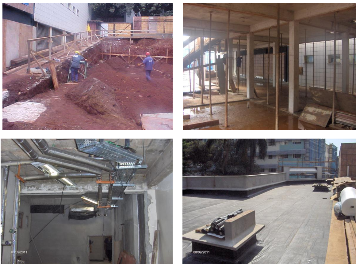
Figura 32: a) Início da obra da ampliação; b) Execução da estrutura em concreto armado; c) Obra na fase de execução da infraestrutura junto ao teto, antes da execução do forro; d) Detalhe da cobertura e impermeabilização da laje.
