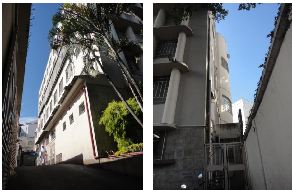
Figura 40: a) Fachada lateral esquerda e o acréscimo no primeiro pavimento para as instalações sanitárias do pronto-atendimento; b) Fachada lateral direita e o acréscimo no primeiro pavimento no setor da radiologia. Fonte: fotografias da autora, em 2013.
