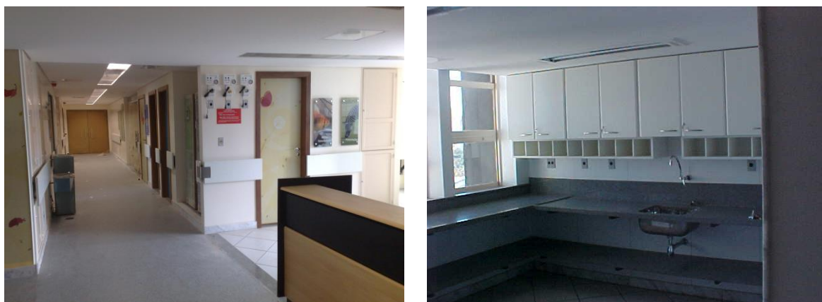
Figura 25: a) Circulação principal e detalhe do balcão do posto de enfermagem; b) Finalização da execução do ambiente de preparo de medicação.
