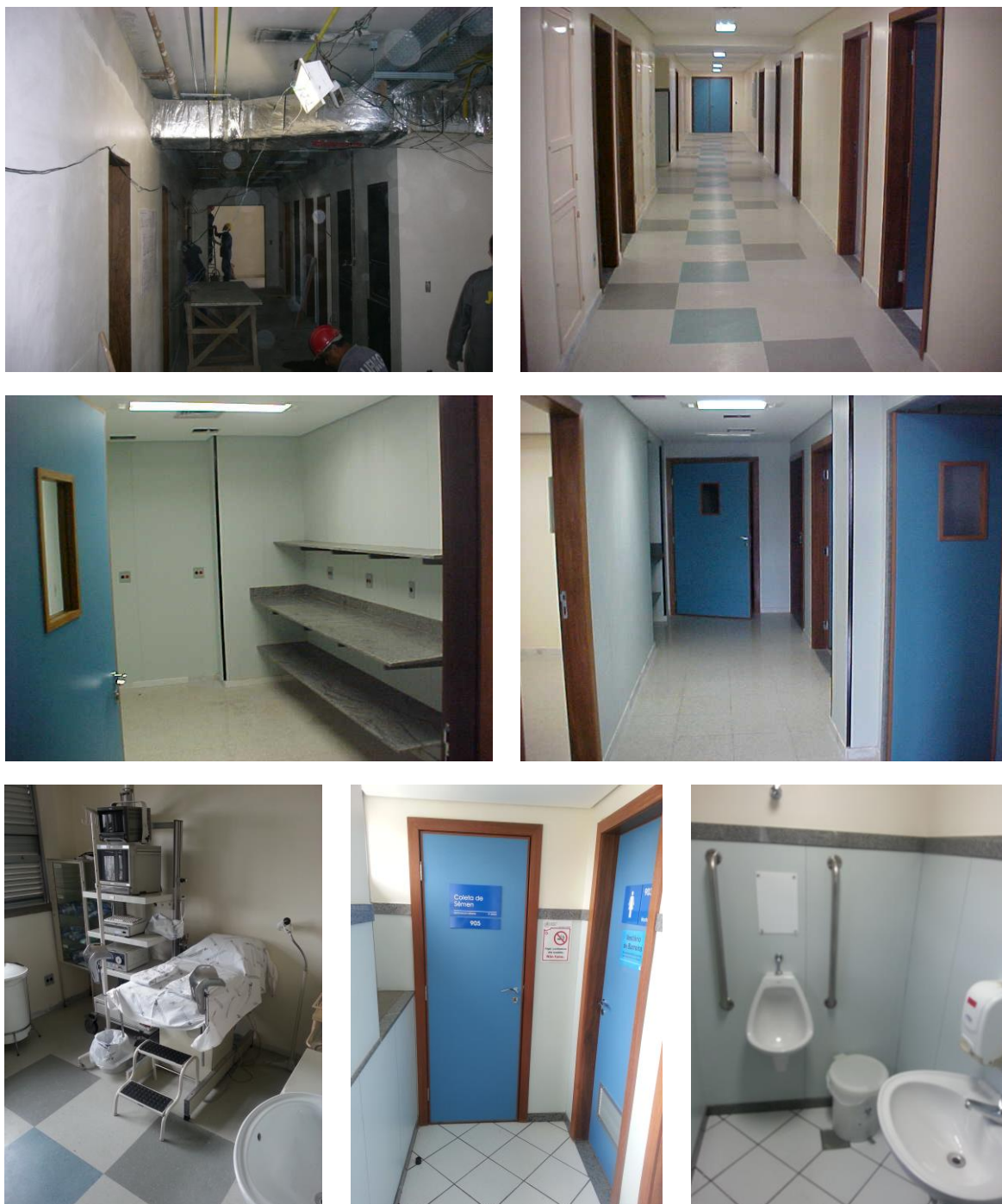
Figura 21: a) Obra na fase de execução da infraestrutura junto ao teto, antes da execução do forro; b) Circulação principal do setor e detalhe do piso vinílico; c) Laboratório de sêmen; d) Antecâmara dos laboratórios; e) Histeroscopia; f) Detalhe corredor lateral de acesso aos vestiários com barreira e coleta de sêmen; g) Instalação Sanitária (coleta de sêmen).
