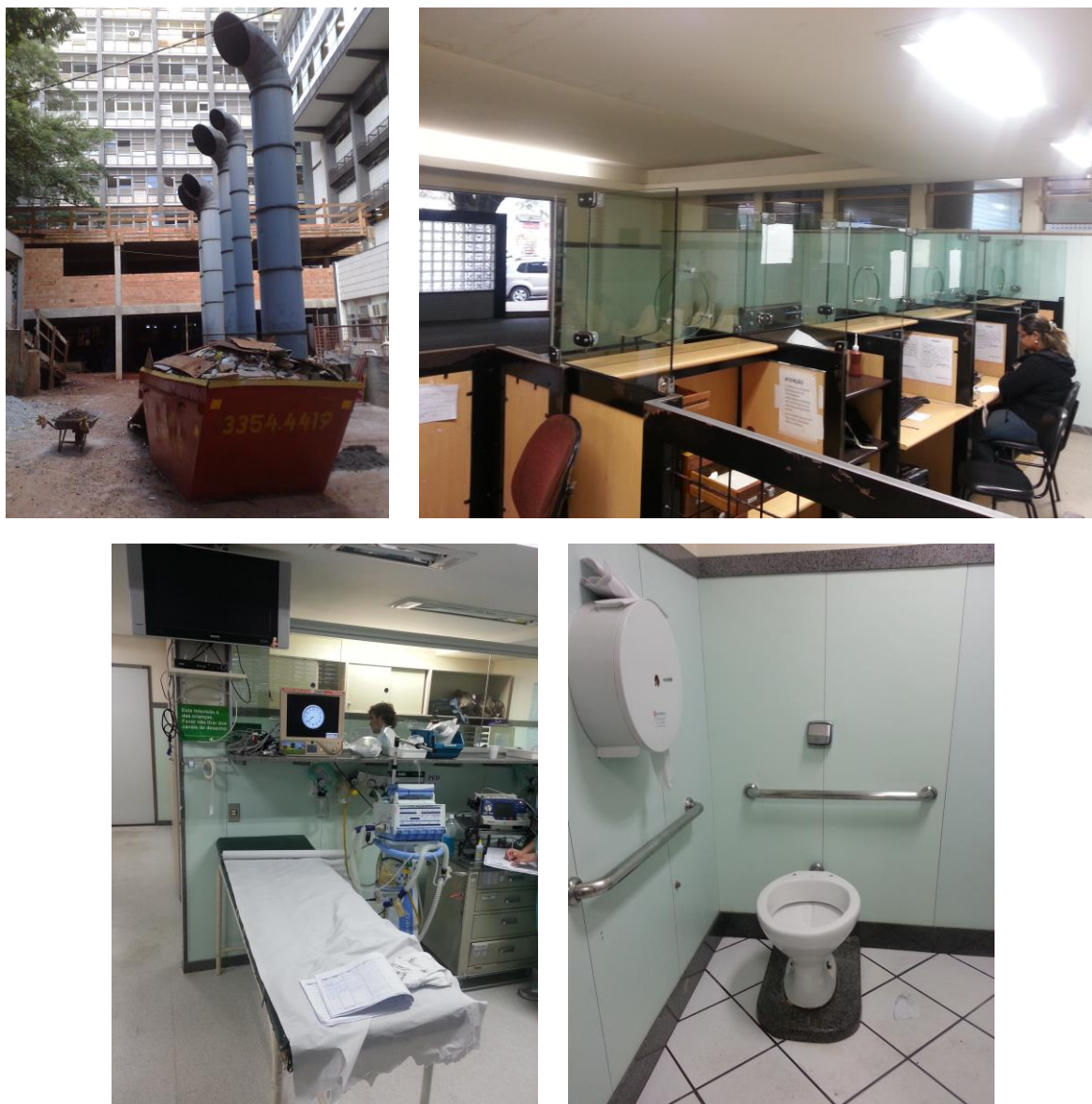
Figura 14: a) Obra de ampliação do PA (2ª fase) vista do pátio frontal do HC/UFMG; b) Recepção e triagem do PA; c) Observação pediátrica do PA; d) Sanitário público do PA.
