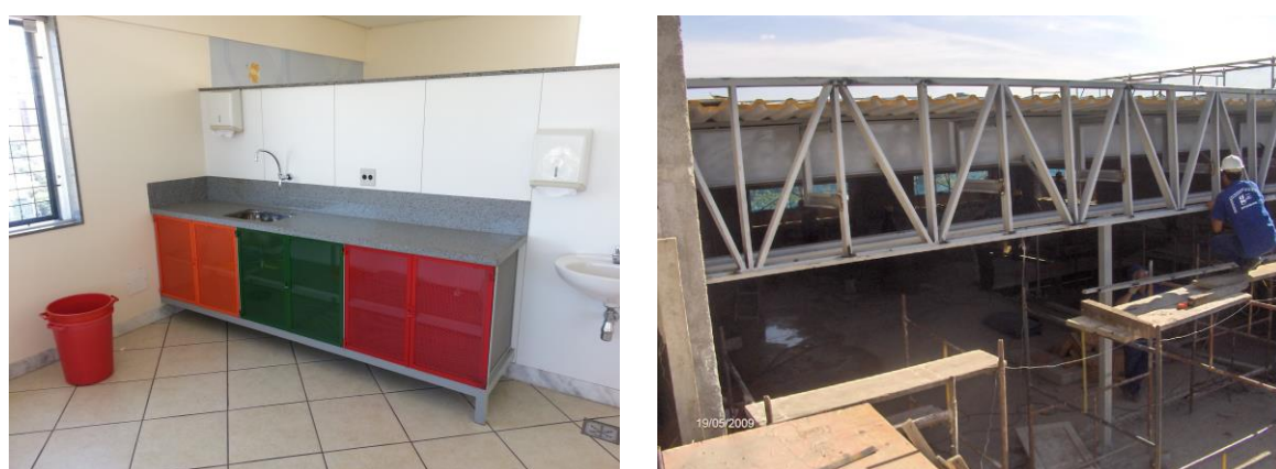
Figura 29: a) Detalhe da bancada de apoio da sala de recreação no 11º pavimento; b) Execução da estrutura da platibanda da cobertura do 11º pavimento (sala de recreação).
