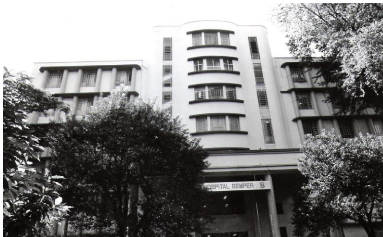
Figura 37: Fachada principal do edifício, já ocupado pelo Hospital Semper. Fonte: Acervo do Centro de Memória da Escola de Enfermagem apud Figueiredo et al. , s/d.
