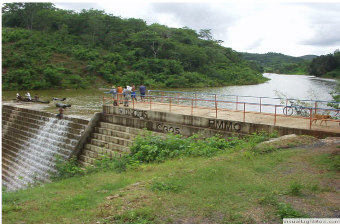
FIGURA. 16– Barragem de Miralta – Distrito de Montes Claros-MG Fonte: arquivo pessoal, 2012
