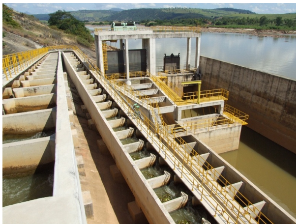
FIGURA 9 - Mecanismo de Transposição de Peixes UHE Eliezer Batista em Aimorés Fonte: UHE AIMORES, 2009.
