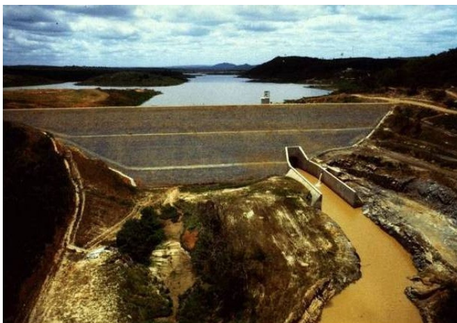
FIGURA 2 - Barragem de concreto de gravidade Fonte: SECRETARIA DA EDUCAÇÃO DO PARANÁ, 2012.
