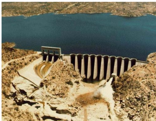
FIGURA 4 - Barragem dare contrafortes Fonte: CIGB, 2007
