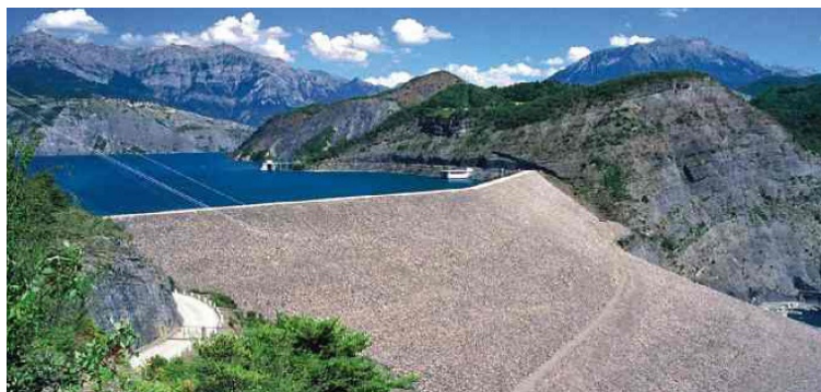
FIGURA 1 – Barragem de terra Fonte: CIGB, 2007.
