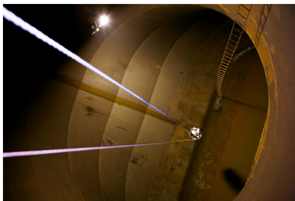
FIGURA 8 – Tubo de sucção da turbina, operação de salvamento de peixes Fonte: ITAIPU, 2012.
