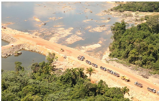
FIGURA 7 - Ensecadeira na construção da Usina de Belo Monte Fonte: ORM, 2012
