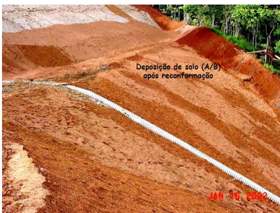
Figura 15: Solo orgânico disposto sobre o talude e berma (VALE, 2002).
