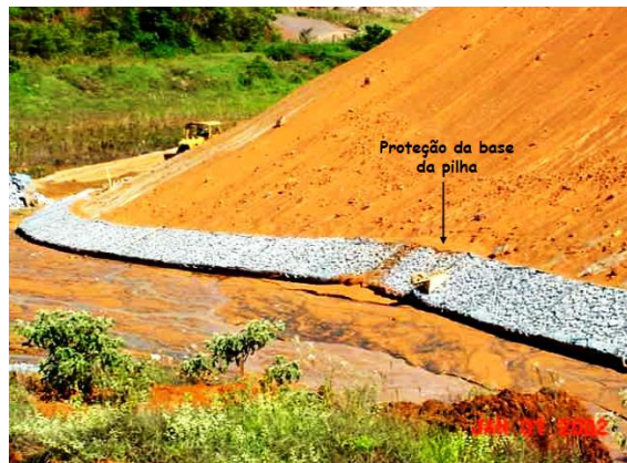
Figura 05: Detalhe do enrocamento protegendo a base da PDE (VALE, 2002).
