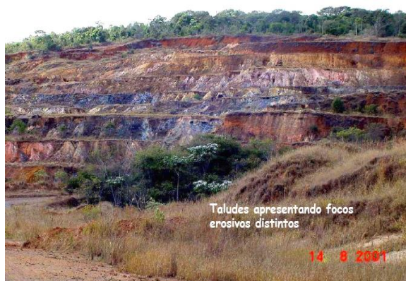
Figura 10: Detalhe dos taludes apresentando sulcos erosivos (VALE, 2002).
