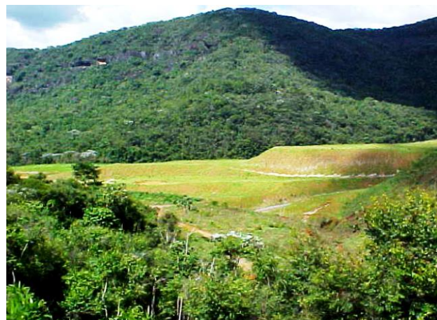
Figura 21: Taludes e bermas da PDE totalmente coberto por vegetação, dando início a sucessão ecológica – Depois (VALE, 2002).
