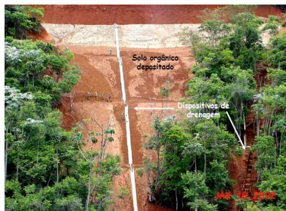
Figura 18: Micro coveamento realizado nos taludes e bermas (VALE, 2002).
