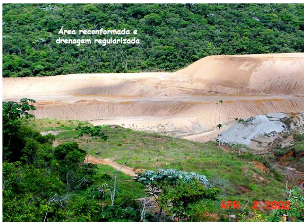
Figura 20: Taludes e bermas da PDE regularizados, sistema de drenagem implantado, pronto para receber as técnicas e práticas ecológicas – Antes (VALE, 2002).
