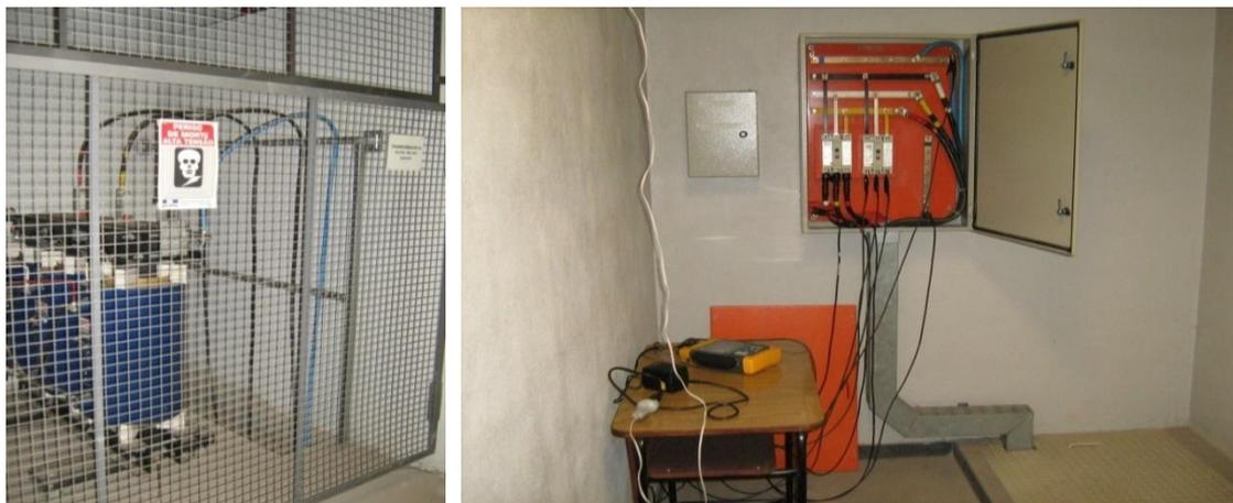
Figura 43- Transformador T4 e medição de sua tensão e corrente. (Fonte: Arquivo pessoal)
