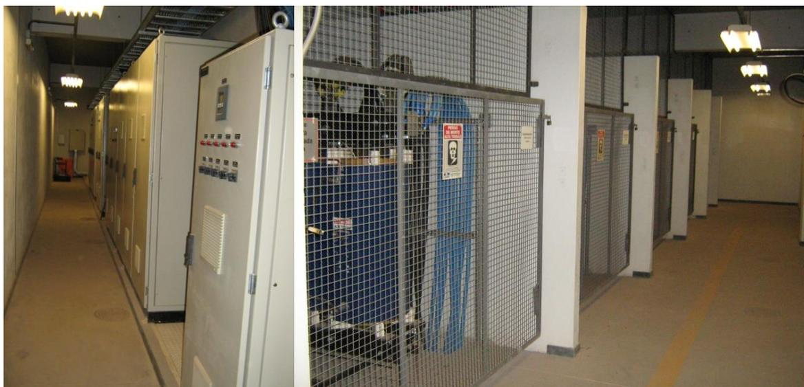
**Figura 25- Cubículos de baixa e de média tensão da SE do bloco 1 (Fonte: Arquivo pessoal).**
