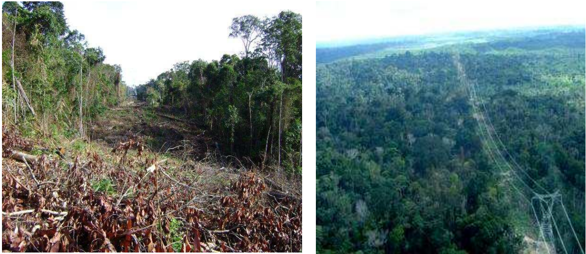
Figura 1.1 – Largura de faixa de segurança de uma linha de transmissão.
